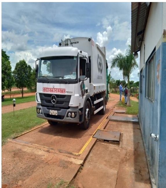
Figura 13: Balança da usina e aterro do município de Andradina.
