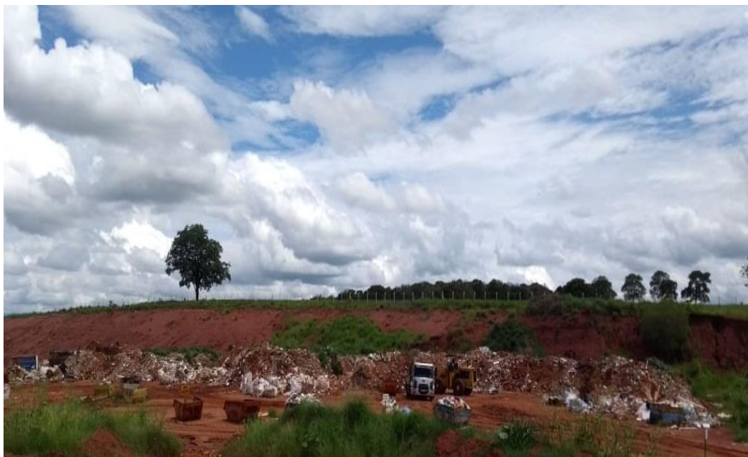
Figura 37: Área de descarte de RCC para uso dos caçambeiros – Ecoponto Maravilha. Fonte: Secretaria Municipal de Meio Ambiente.
