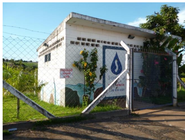
Foto 4.41 – EEE2 – Casa de Bomba
