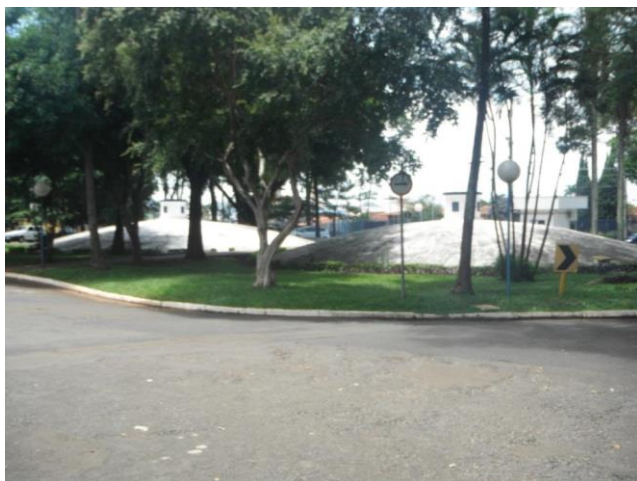
Foto 4.24 – Reservatórios ETA 4 e 5
