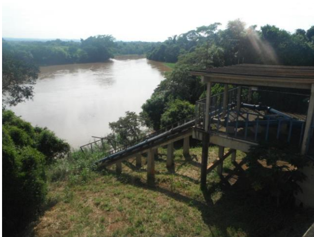
Foto 4.17 - Adução de água bruta – Rio Mogi Guaçu
