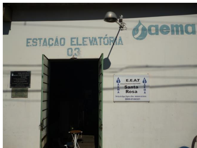
Foto 4.37 – EEAT8 – Casa de Bombas
