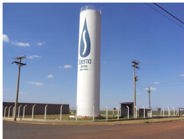
Foto 4.10 – Poço Distrito Industrial V
