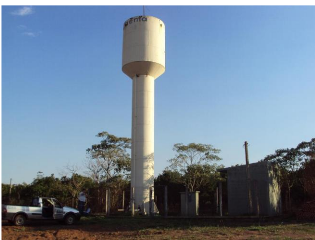
Foto 4.32 – Reservatório Elhiu Root
