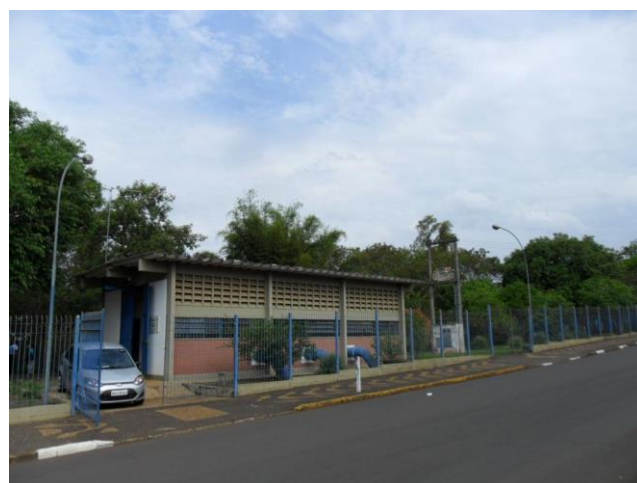
Foto 4.35 – EEAT3 – Casa de Bombas*
