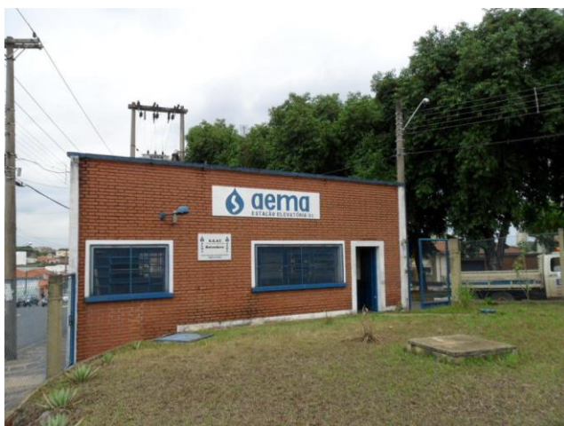
Foto 4.36 – EEAT5 – Casa de Bombas*
