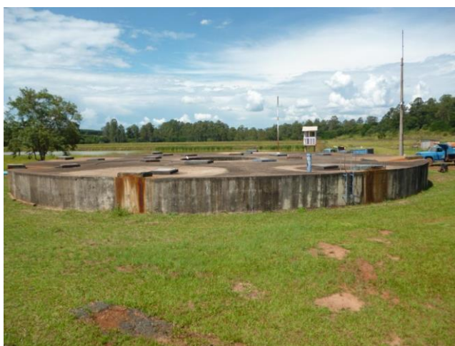
Foto 4.46 – Reatores UASB
