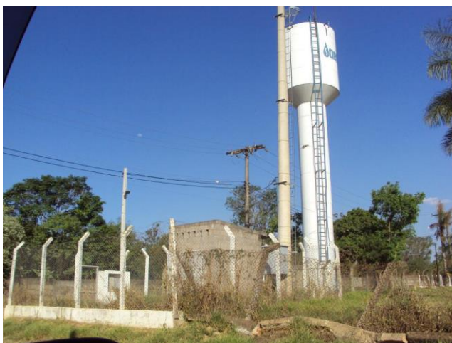
Foto 4.30 – Reservatório Cascata Veroca
