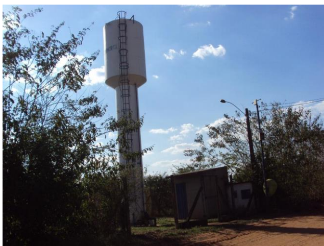
Foto 4.7 – Poço Assentamento Araras II
