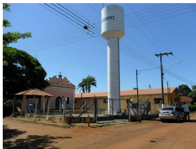
Foto 4.12 – Poço São Bento
