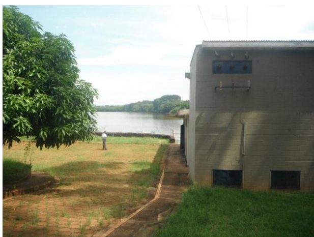
Foto 4.15 - Casa de Bombas da EEAB2
