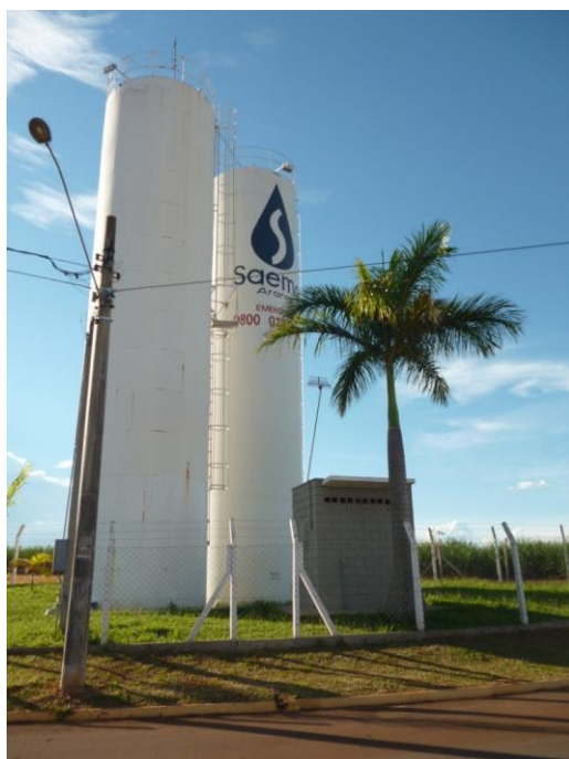
Foto 4.28 – Reservatórios Pedras Preciosas 1 e 2
