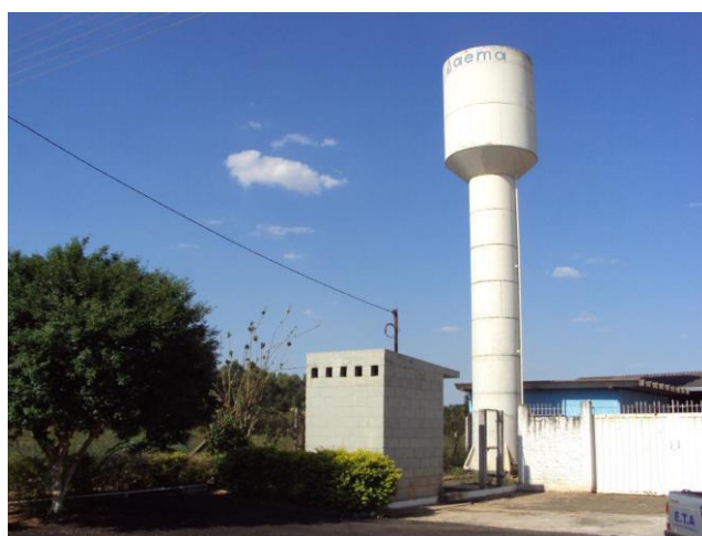
Foto 4.33 – Reservatório Morro Grande
