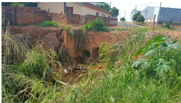
Foto 3.1 – Galeria na Rua Ângelo Sanches Parra
