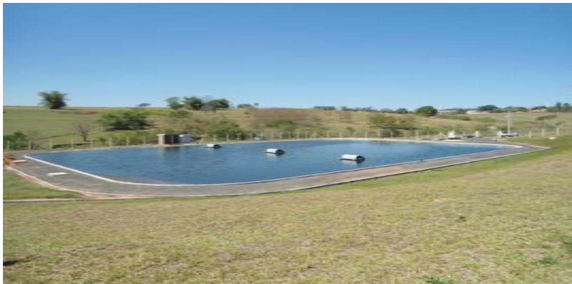
Foto 37 - Estação de Tratamento de Esgoto (Lagoa Facultativa Aerada) de Arco-Íris.
