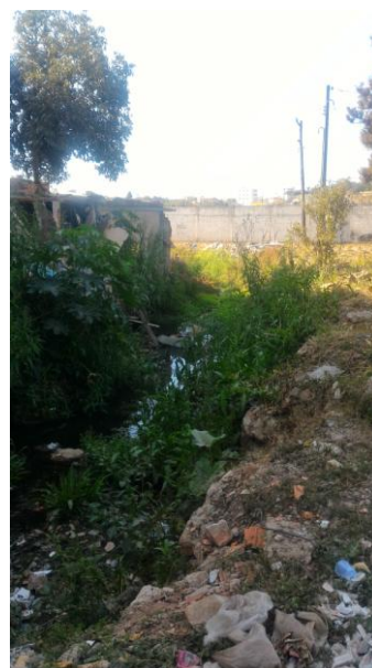
Foto 3.16 – Córrego Taboão (Cavalos) - Restos da demolição das casas construídas irregularmente sobre o córrego
