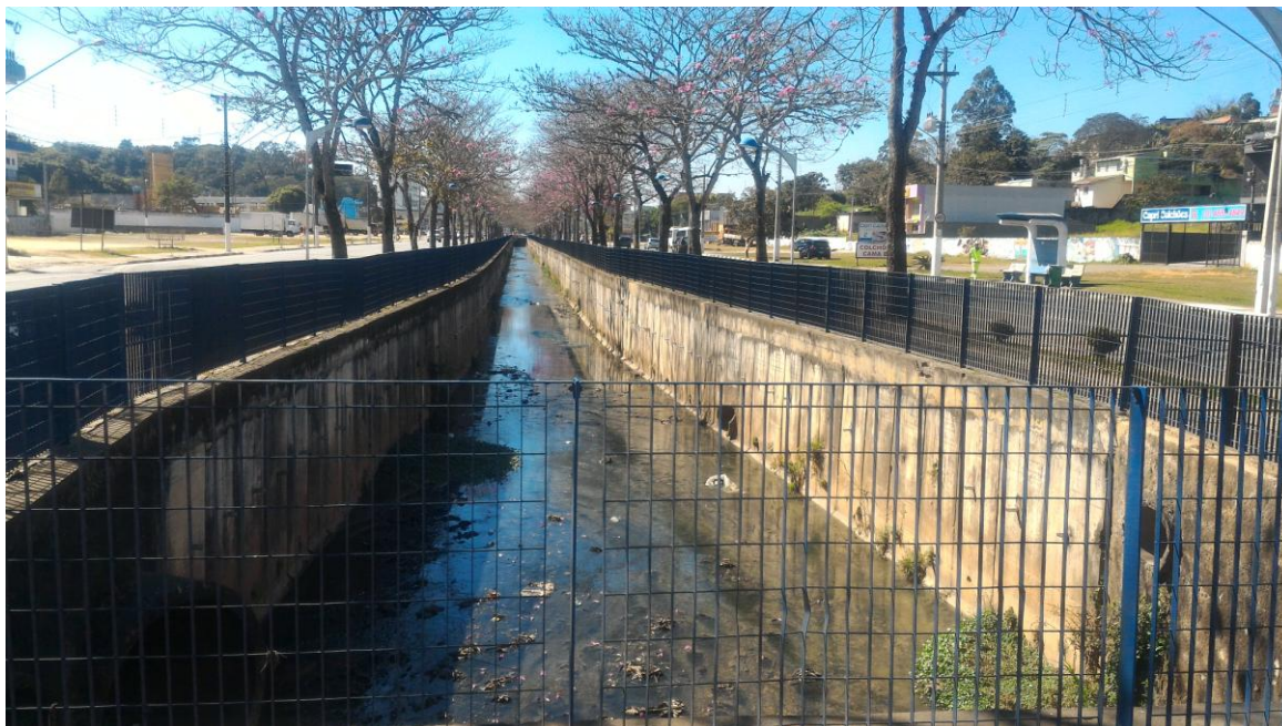
Foto 3.5 – Rio Baquirivú-Guaçu canalizado na Avenida João Manoel
