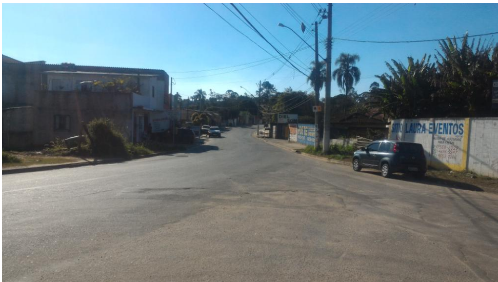
Foto 3.17 – Ponto de inundação entre a Rua Carmelino de Jesus e Estrada da Penha
