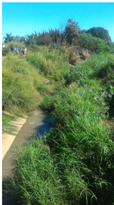
Foto 3.10 - Rio Baquirivú-Guaçu - Parte ainda não canalizada no Município de Guarulhos
