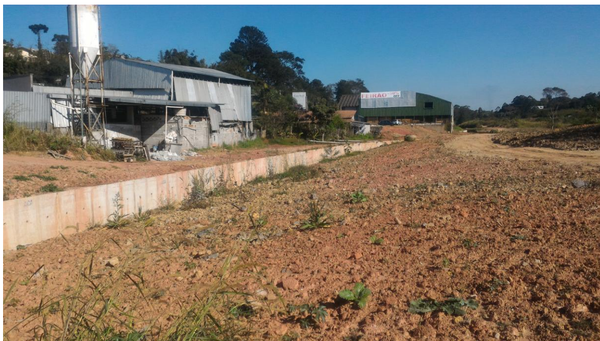
Foto 3.13 - Córrego Caputera - Trecho que está sendo canalizado com recursos da SABESP
