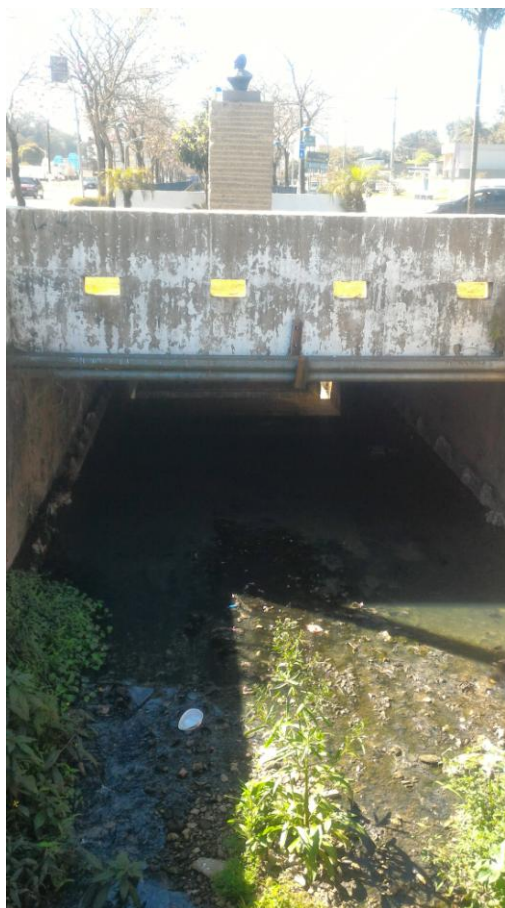
Foto 3.8 – Estreitamento do canal na região da rotatória entre as Avenidas João Manoel e Renova
