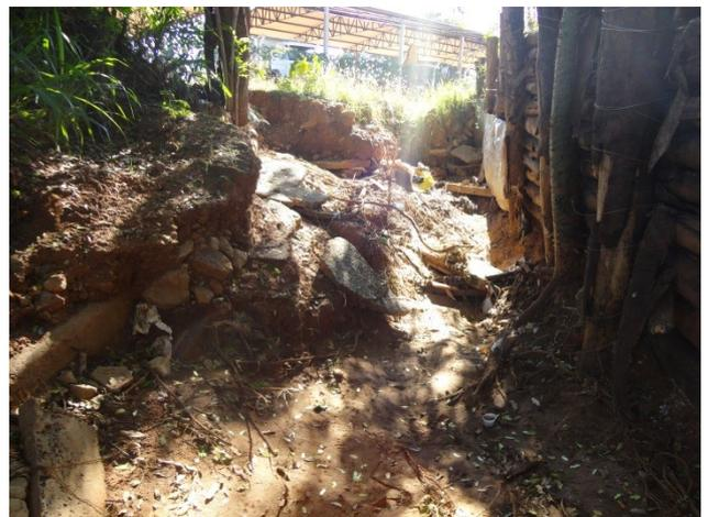
Foto 3.14 – Erosão provocada pelo escoamento superficial
