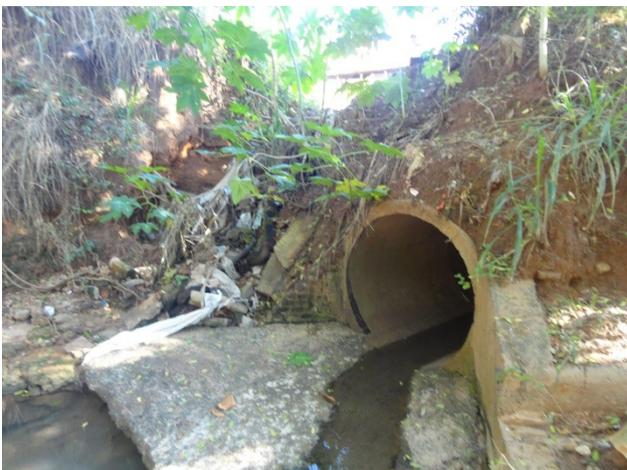
Foto 3.13 – Erosão próxima à estrutura de lançamento
