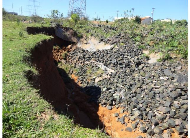
Foto 3.11 – Erosão provocada pelo escoamento superficial
