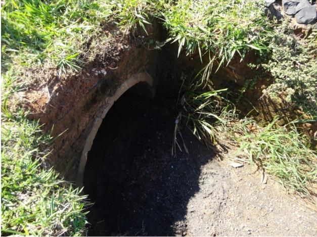
Foto 3.10 – Assoreamento do início do canal
