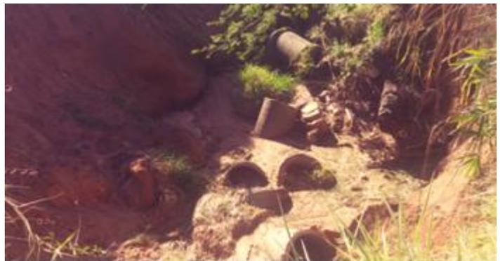
Foto 3.28 – Galerias engolidas pela erosão
