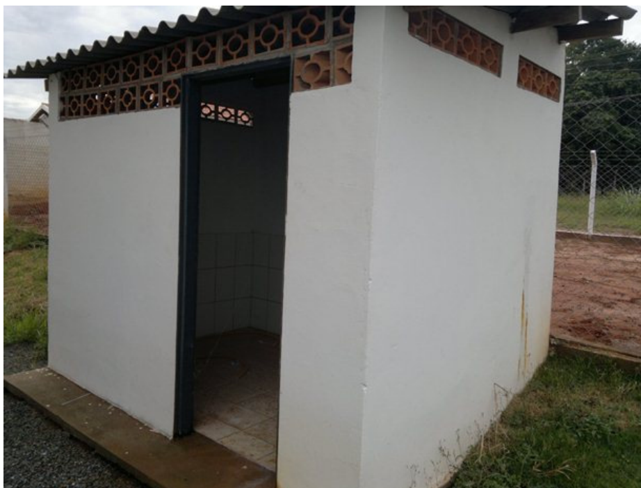
Foto: 59 – Local Armazenamento e Tratamento de Água Localização: – Entre as Ruas Projetada 13 e Projetada 03 – Bairro Residencial Lago Sul
