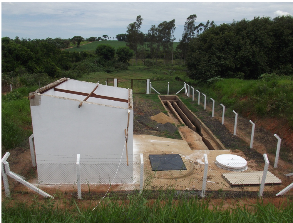
Foto: 70 – Vista Superior da Nova Elevatória de Esgoto Localidade: Denominado “Matadouro”.
