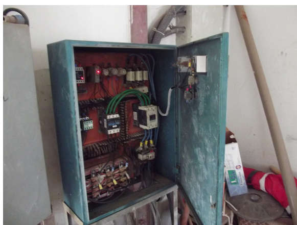
Foto: 28 – Painel de Controle de Partida e Entrada do Poço Profundo (P1) Localização: Praça Mário Covas.
