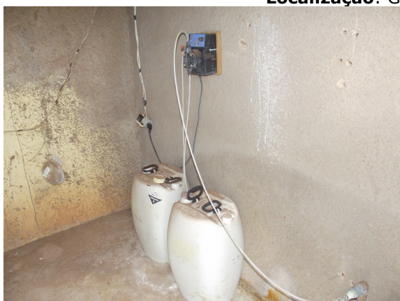
Foto: 34 – Armazenamento e Tratamento de Água (Cloro / Flúor) Sistema Central "Ginásio de Esportes" Localização: Ginásio de Esportes.
