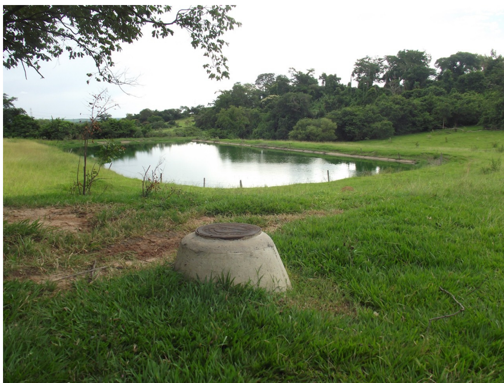
Foto: 79 - Imagem da 2ª Lagoa (retangular). A frente PV (Poço de Visita) do Novo Emissário. Localidade: Jardim Tropical
