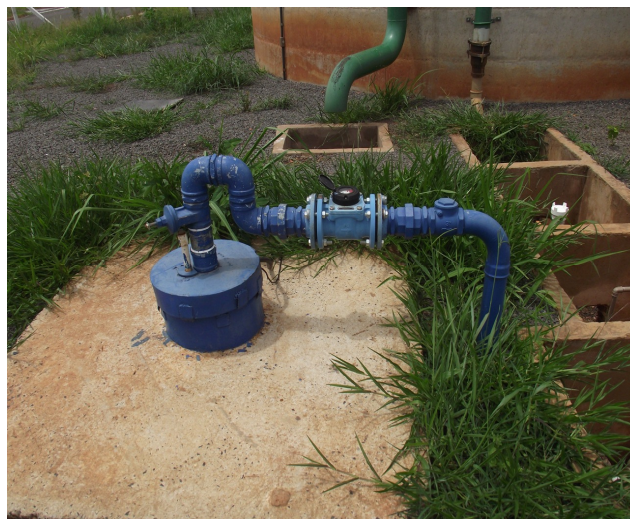
Foto: 55 – Painel de Comando e Entrada do Poço (P21) – Poço Com Medido de Vazão Localização: – Entre as Ruas Projetada 13 e Projetada 03 – Bairro Residencial Lago Sul
