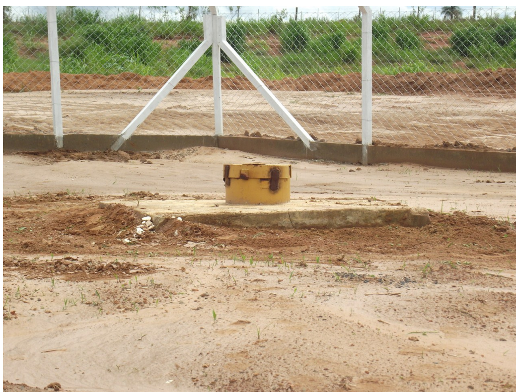
Foto: 61 – Entrada do Novo Poço Profundo que esta sendo construído
