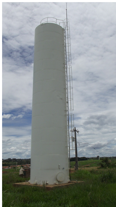
Foto: 17 – Reservatório Metálico (Inativo) - Capacidade: 60m 3 Localização: Av. Projetada I com Av. Projetada II – Bairro Residencial Borboleta II.
