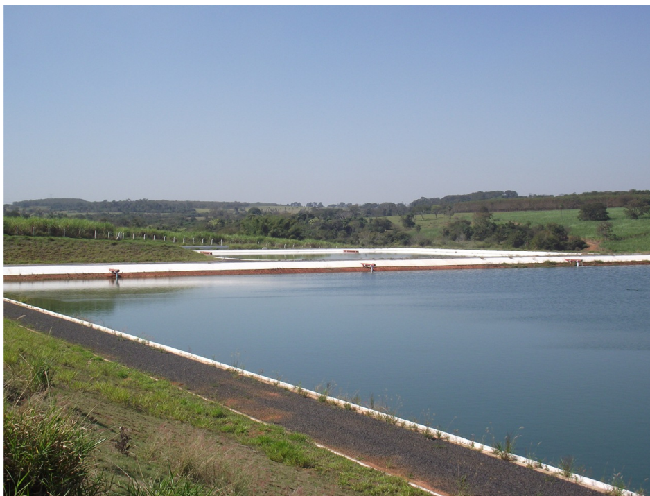
Foto: 87 – Visão I – Visão Externa do local onde se encontra a Estação de Tratamento de Esgoto - ETE de Bady Bassitt (1ª Lagoa ao Fundo e 2ª Lagoa)
