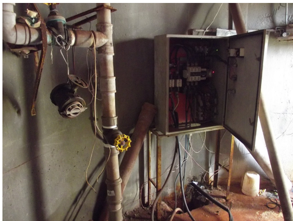
Foto: 38 – Painele de Comando e Entrada do Poço e (P8) Localização: Rua Wilson Antônio de Aquino, nº 310
