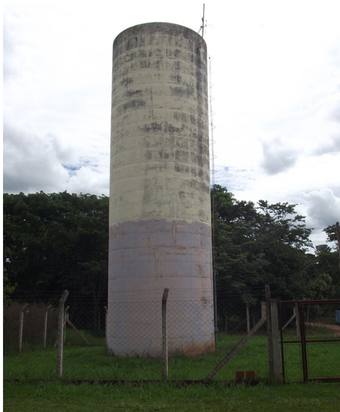
Foto: 21 – Reservatório de Concreto - Capacidade: 60m 3 Localização: Bairro Vertente
