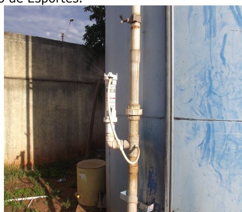
Foto: 34 – Armazenamento e Tratamento de Água (Cloro / Flúor) Sistema Central "Ginásio de Esportes" Localização: Ginásio de Esportes.
