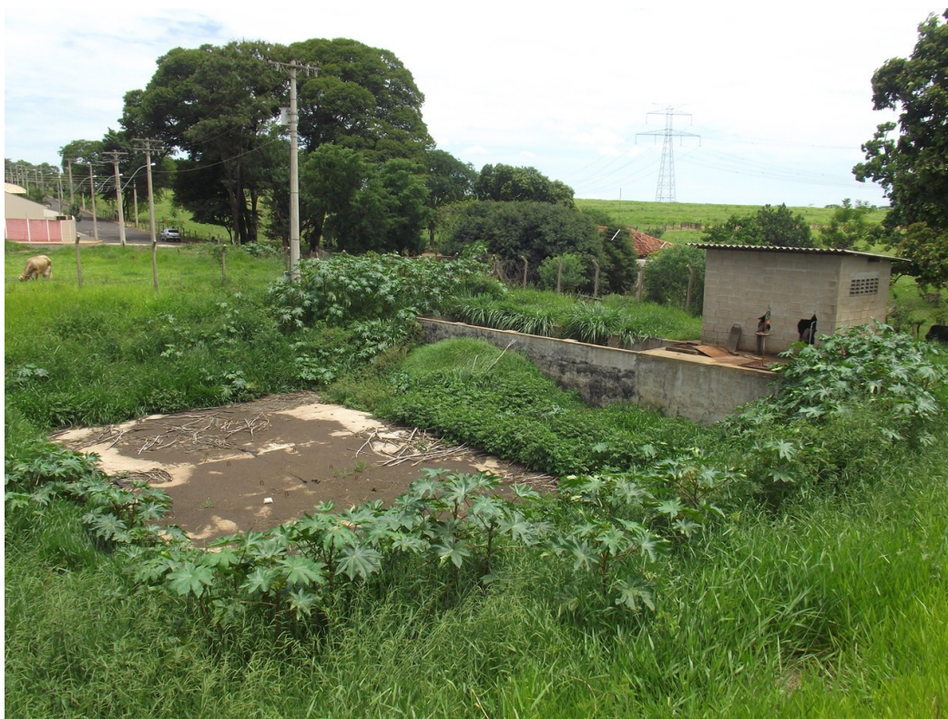
Foto: 74 – Vista Superior da Antiga Elevatória de Esgoto (Desativada) Localidade: Bairro Palmeiras.
