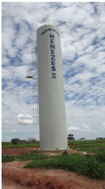
Foto: 18 – Reservatório Metálico - Capacidade: 60m 3 Localização: Bairro Residencial Menezes II
