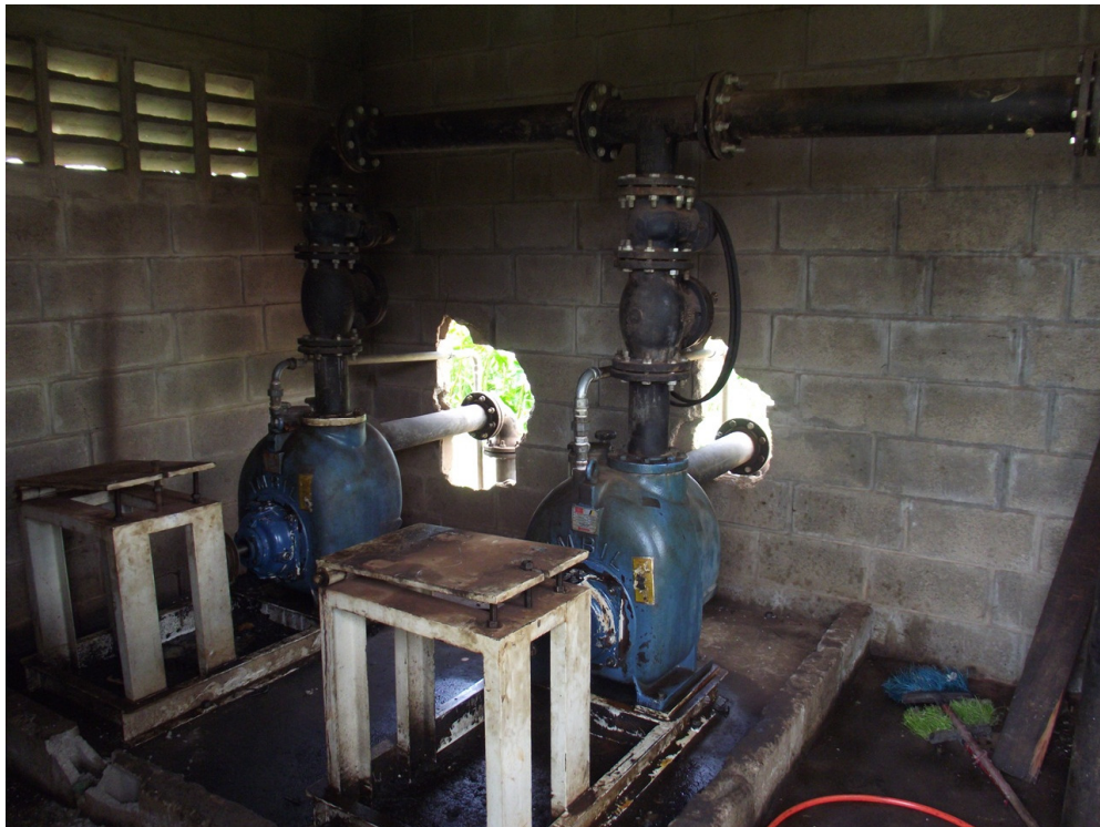
Foto: 72 - Visão do Interior da Antiga Elevatória de Esgoto (Casa das Bombas) Localidade: Bairro Palmeiras.
