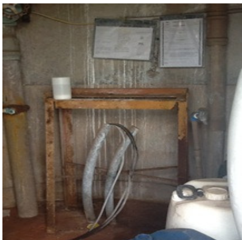
Foto: 37 – Local do Armazenamento dos Produtos Químicos e Tratamento de Água (P7) – Apresentando Vários Vazamentos na Entrada do Tratamento Localização: Entre as Ruas Otacílio José Mesquita e Rua Antônio de Melo
