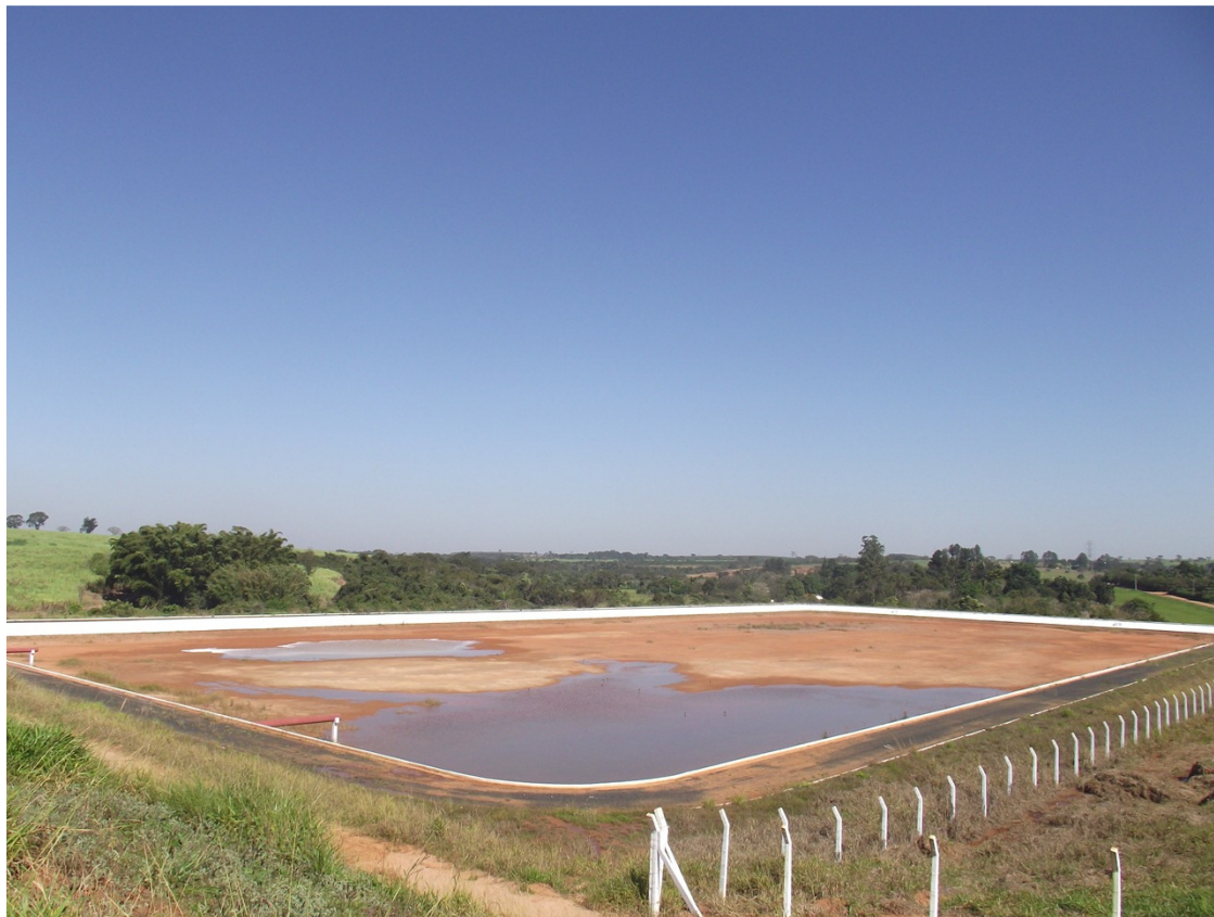
Foto: 93 – Visão VII – Vista da 4ª - Lagoa de Tratamento de Esgoto (Ainda Sem o Recebimento de Esgoto) Localidade: Antiga Fazenda Morená
