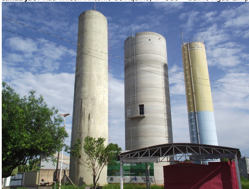
Foto: 09 – Foto dos 03 reservatórios juntos – Capacidade Total 515m 3 Localização: Rua Wilson Antônio de Aquino, nº 310 – Bairro Água Limpa I.
