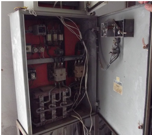
Foto: 30 – Painel de Controle de Partida e Local onde esta o Poço Profundo (P2) Localização: Praça Mário Covas.
