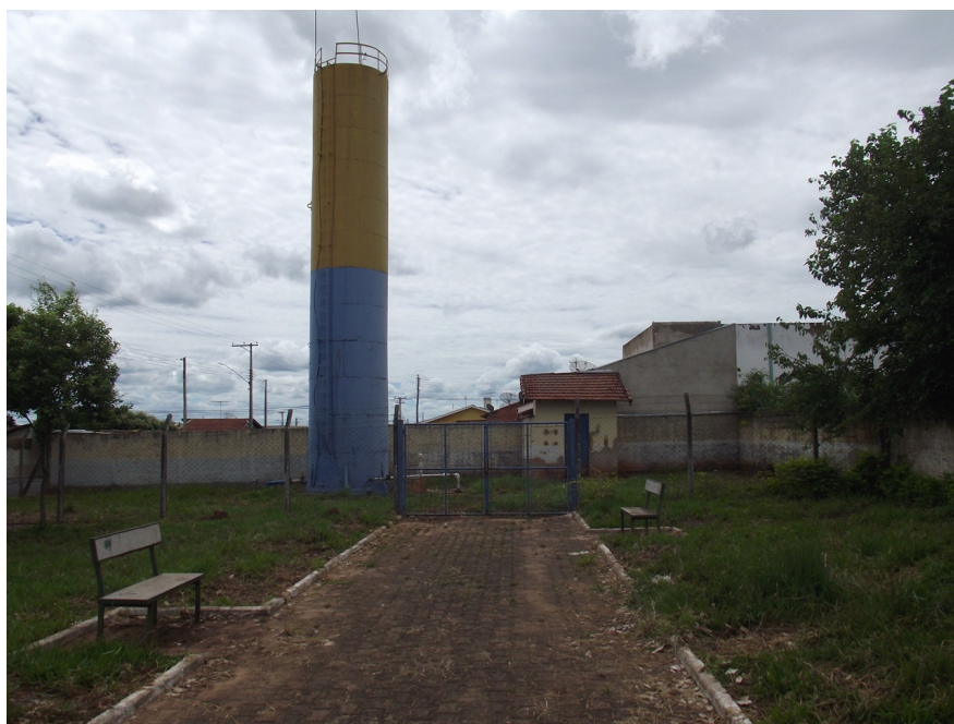
Foto: 11 – Reservatório Metálico - Capacidade: 60m 3 Localização: Rua Sebastião Vaz de Lima com Rua Anhanguera – Cohab II.
