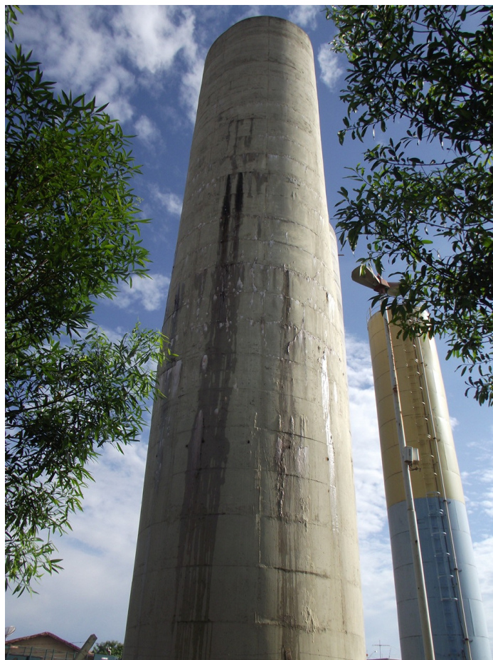
Foto: 07 – Reservatório Concreto (Velho) – Capacidade 120m 3 Ao fundo - Reservatório Metálico – Capacidade 145m 3 (Inativo) Localização: Rua Wilson Antônio de Aquino, nº 310 – Bairro Água Limpa I.
