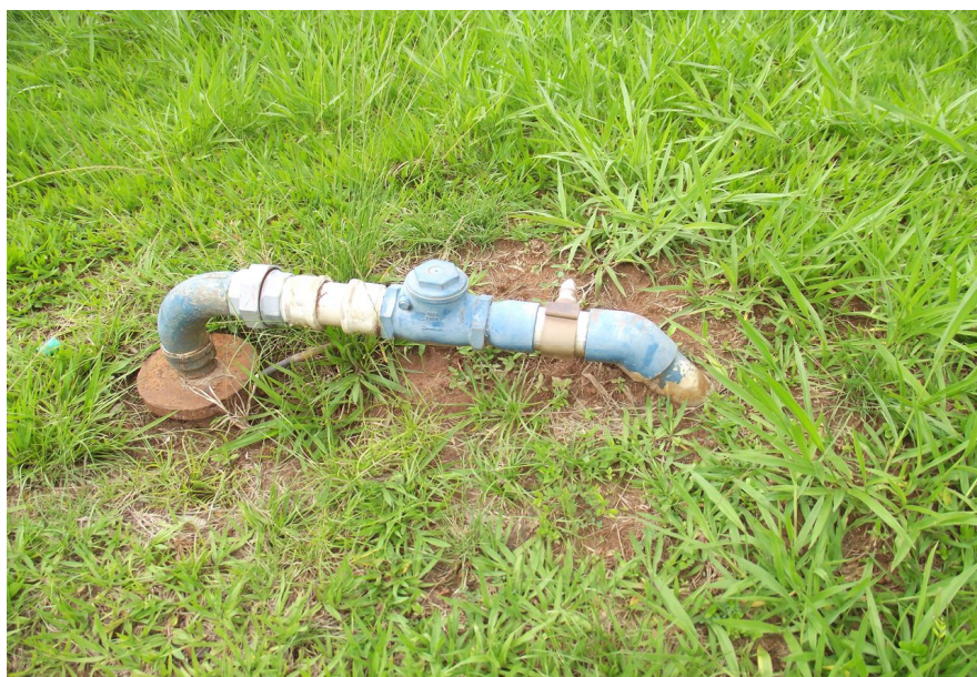
Foto: 23 - Entrada Poço Profundo (Bairro Vertente)
