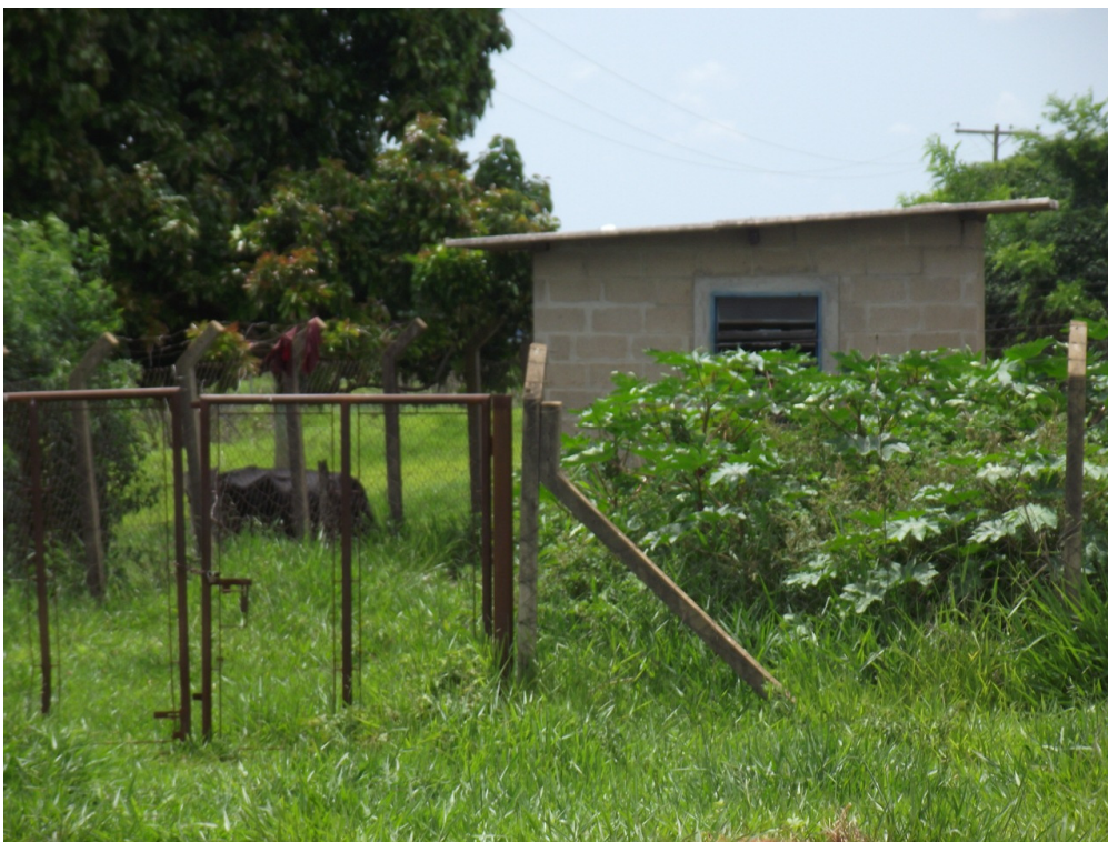
Foto: 71 – Entrada da Antiga Elevatória de Esgoto (Desativada) Localidade: Bairro Palmeiras.
