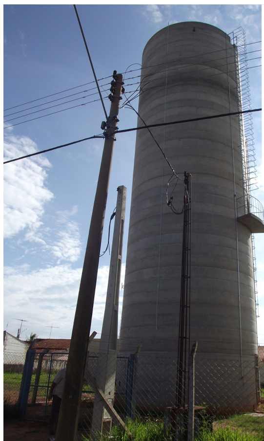
Foto: 08 – Reservatório Concreto (Novo) – Capacidade 250m 3 (Inativo) Localização: Rua Wilson Antônio de Aquino, nº 310 – Bairro Água Limpa I.
