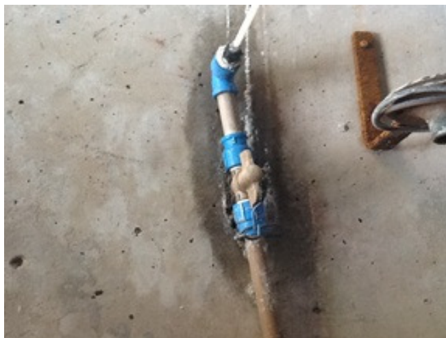
Foto: 37 – Local do Armazenamento dos Produtos Químicos e Tratamento de Água (P7) – Apresentando Vários Vazamentos na Entrada do Tratamento Localização: Entre as Ruas Otacílio José Mesquita e Rua Antônio de Melo
