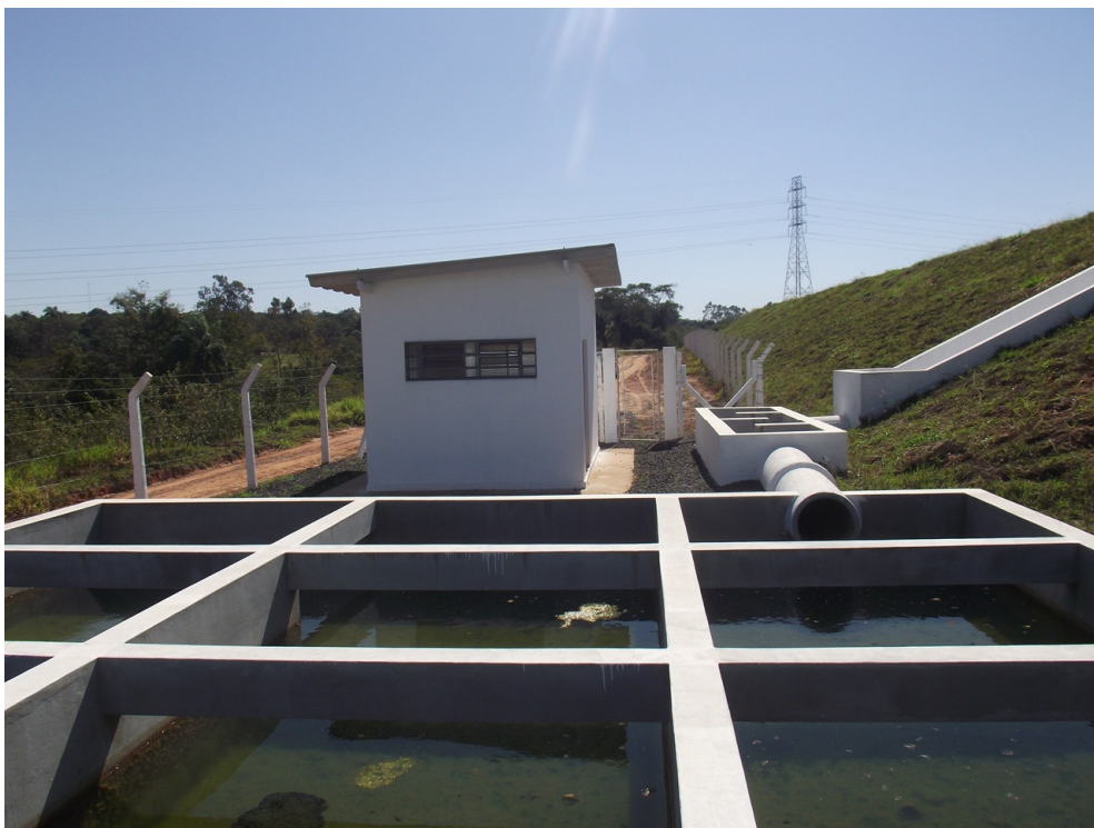
Foto: 102 – Visão IV – Tratamento Facultativo dos Efluentes Estação de Tratamento de Esgoto - ETE Localidade: Antiga Fazenda Morená
