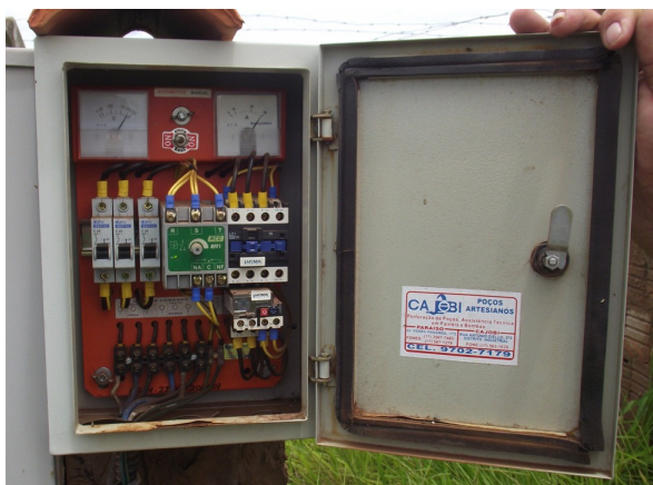
Foto: 54 – Painel de Comando e Entrada do Poço (P20) – Poço Com Medido de Vazão Localização: – Rua João Pedro Paulino, nº 455 – Bairro Residencial Menezes II
