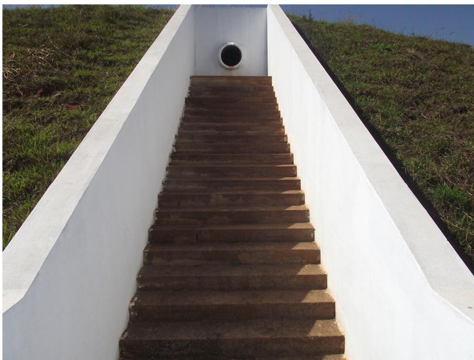
Foto: 96 – Saída dos Efluentes das Lagoas para o Tratamento (Ainda Sem o Recebimento de Esgoto) Localidade: Antiga Fazenda Morená
