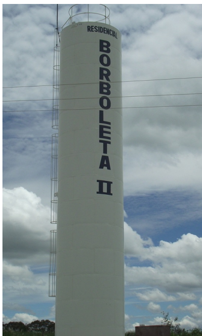
Foto: 17 – Reservatório Metálico (Inativo) - Capacidade: 60m 3 Localização: Av. Projetada I com Av. Projetada II – Bairro Residencial Borboleta II.
