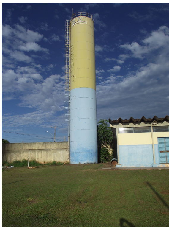
Foto: 03 – Reservatório Central – Capacidade de 145m 3 - Localização: Ginásio de Esportes – Centro
