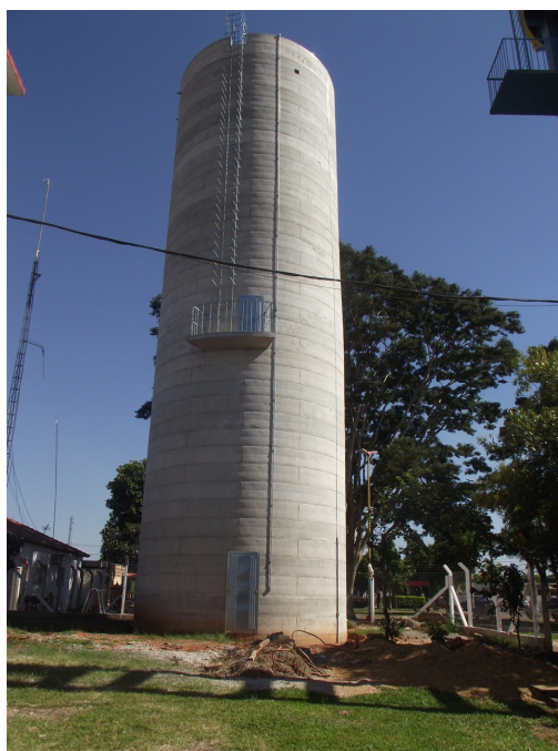
Foto: 02 – Reservatório Central (Inativo) – Capacidade de 250m 3 Localização: Praça Mário Covas – Centro
