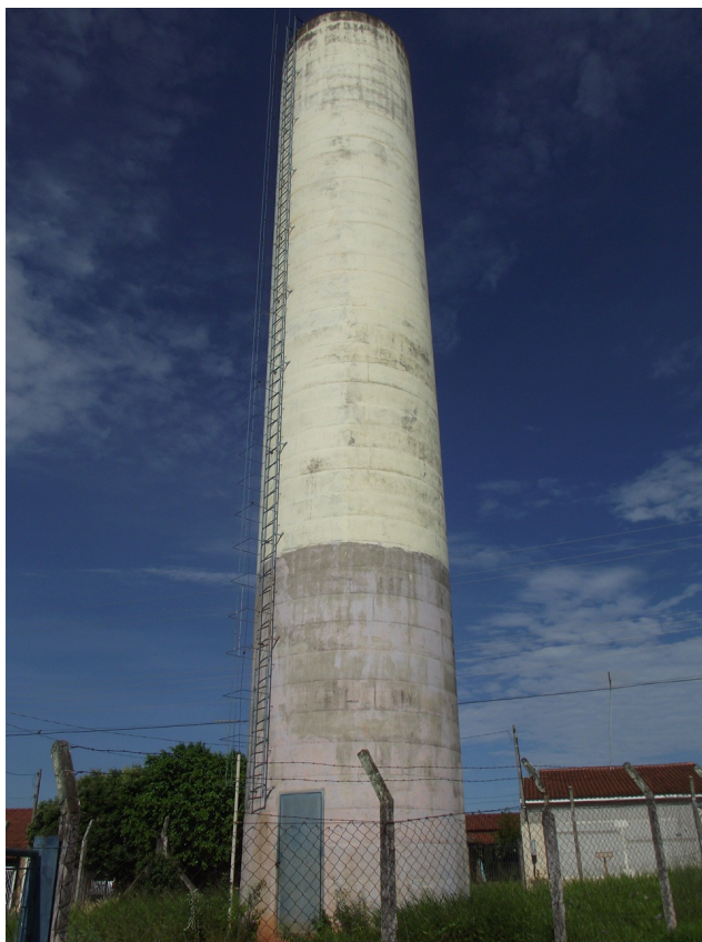
Foto: 10 – Reservatório de Concreto – Capacidade: 100m 3 Localização: Praça Lino Pradela – Cohab I
