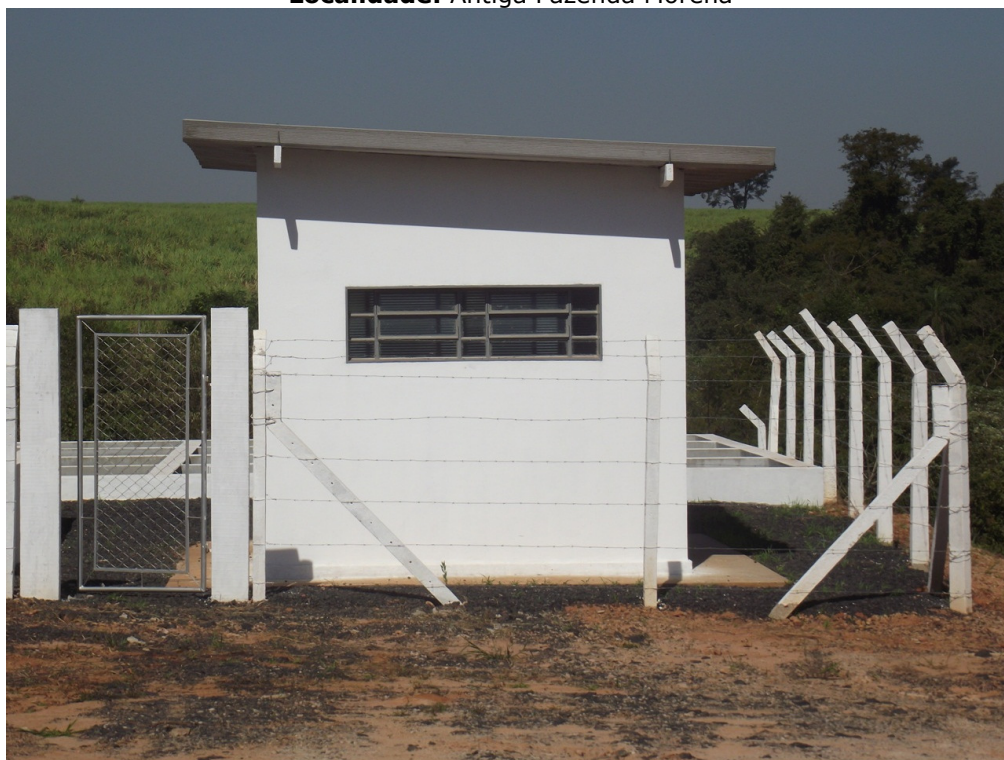
Foto: 97 – Entrada da Guarita da Estação de Tratamento de Esgoto – ETE Localidade: Antiga Fazenda Morená
