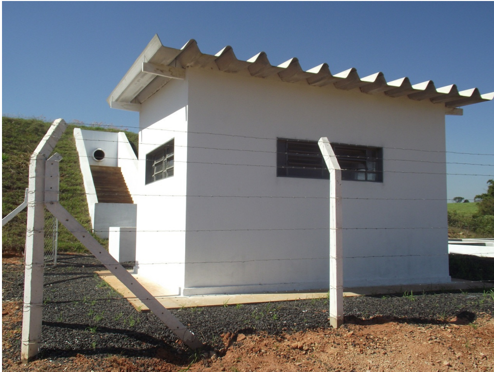
Foto: 98 –Lateral da Guarita da Estação de Tratamento de Esgoto – ETE Localidade: Antiga Fazenda Morená
