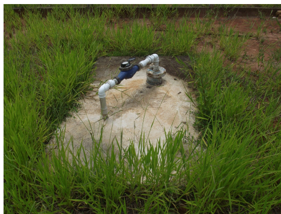
Foto: 54 – Painel de Comando e Entrada do Poço (P20) – Poço Com Medido de Vazão Localização: – Rua João Pedro Paulino, nº 455 – Bairro Residencial Menezes II
