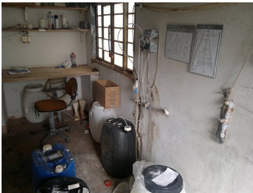
Foto: 27 – Armazenamento dos Produtos Químicos (Cloro / Flúor) para Tratamento de Água Localização: Praça Mário Covas.
