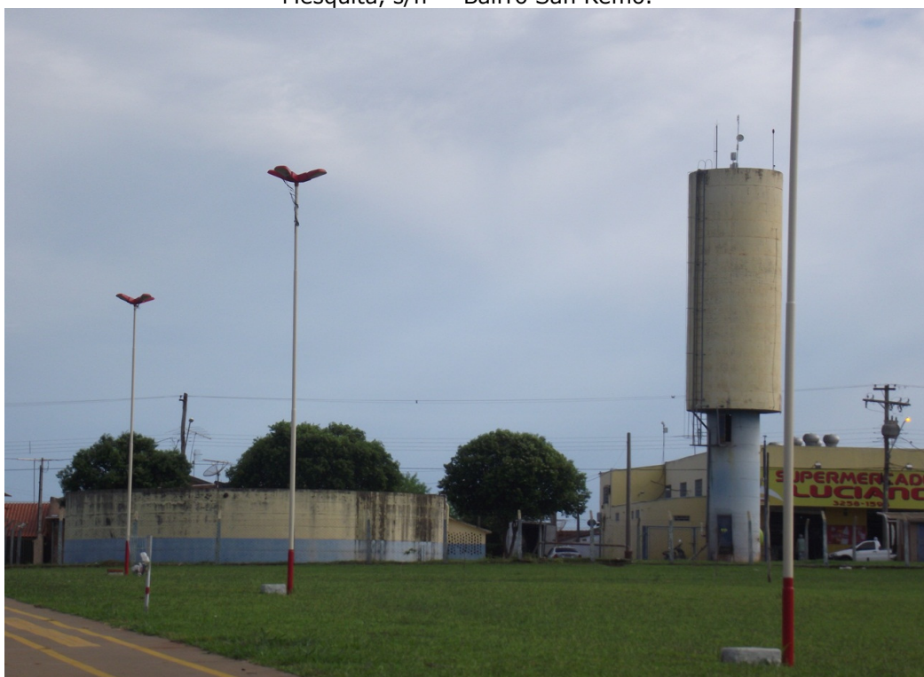
Foto: 06 – Reservatório Apoiado e Elevado – idem acima – Capacidade Total dos 02 reservatórios 850m 3 - Localização: Rua Otacílio José Mesquita, s/nº - Bairro San Remo.
