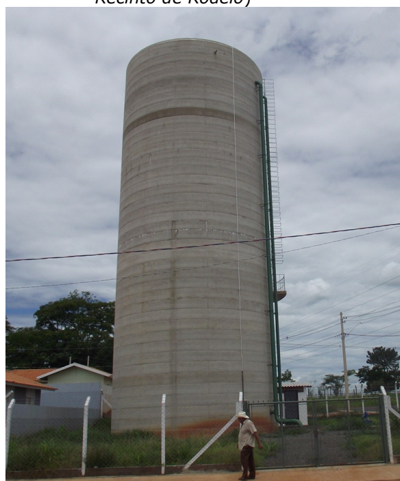
Foto: 20 – Reservatório de Concreto - Capacidade: 250m 3 Localização: Entre as ruas Projetada 03 e Projetada 13 – Bairro Residencial Lago Sul
