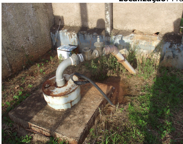
Foto: 33 – Entrada do Poço Profundo (P5) e Painel de Controle de Partida Localização: Ginásio de Esportes.
