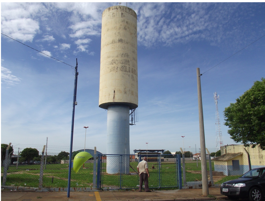
Foto: 05 – Reservatório Elevado – Capacidade 100m 3 - Localização: Rua Otacílio José Mesquita, s/nº - Bairro San Remo.
