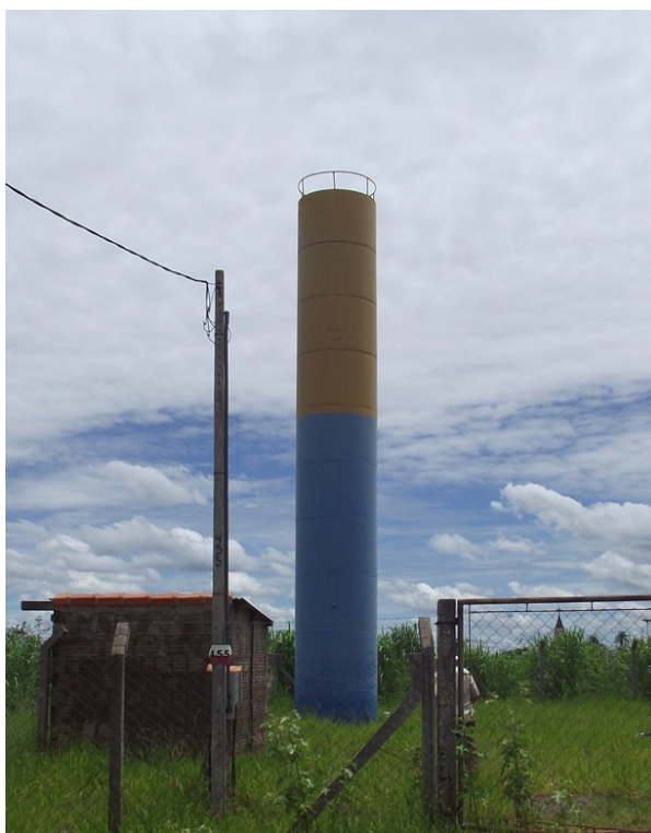
Foto: 19 – Reservatório Metálico - Capacidade: 25m 3 Localização: Rua João Pedro Paulino, nº 455 – Bairro Residencial Jardim das Flores ( Atrás do Recinto de Rodeio )
