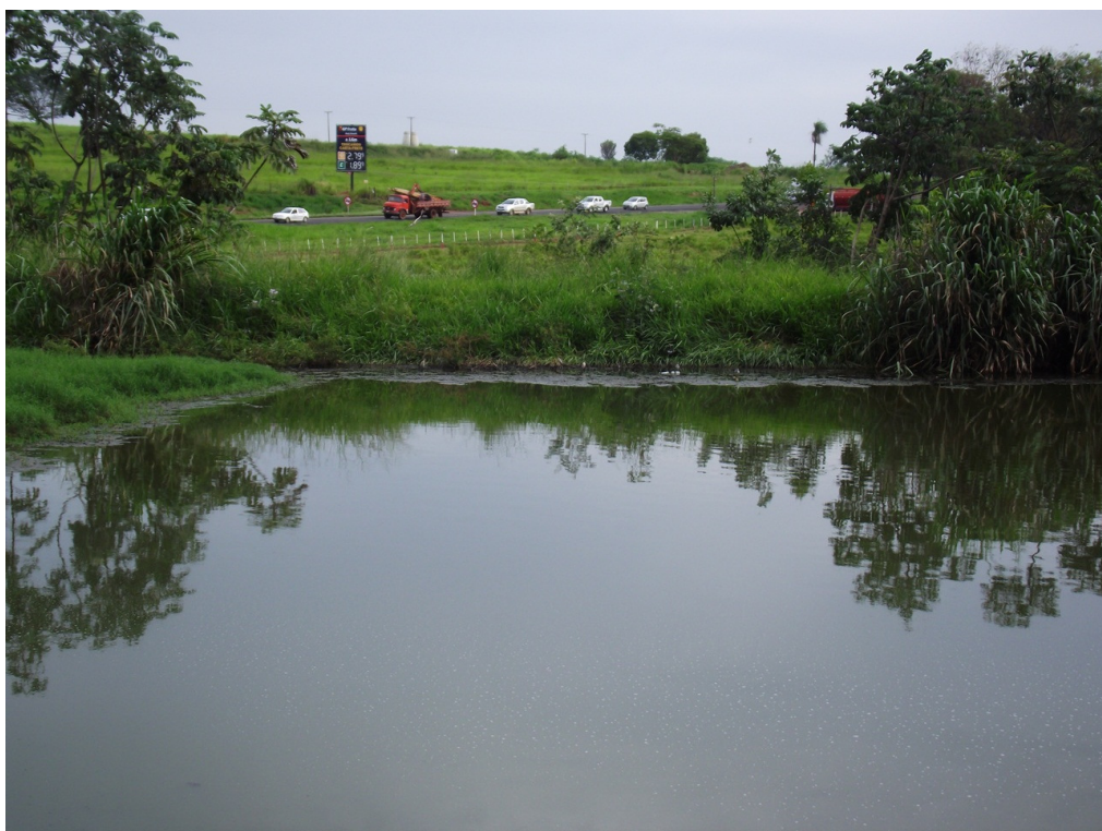
Foto: 84 – Visão II - Vista parcial da 3ª lagoa de tratamento. Localidade: Denominada BR 153
