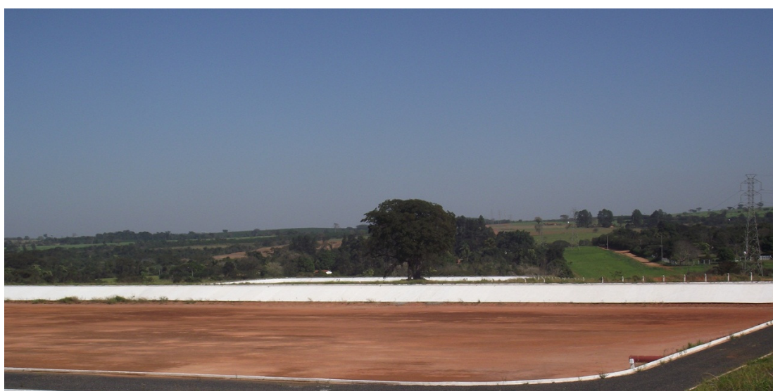
Foto: 90 – Visão IV – Vista Parcial da 3ª - Lagoa de Tratamento de Esgoto (Ainda Sem o Recebimento de Esgoto) Localidade: Antiga Fazenda Morená
