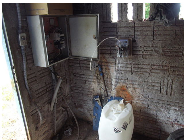
Foto: 42 – Armazenamento e Tratamento (Cloro / Flúor) - Painel de Comando e Entrada do Poço Localização: – Rua Sebastião Vaz de Lima, s/nº - Cohab II
