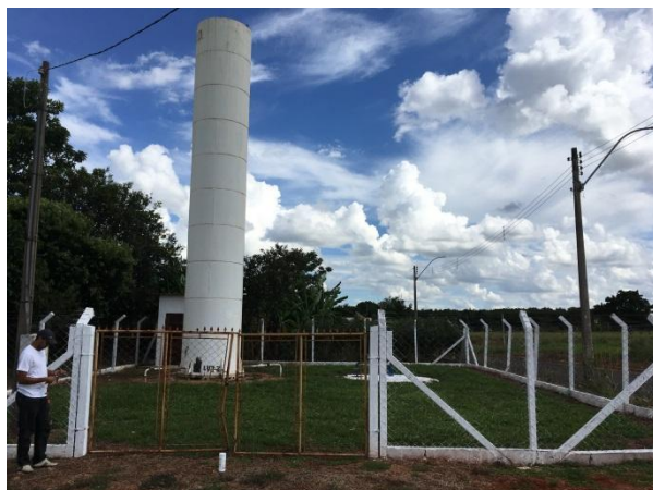
Foto 3.20 - Identificação do Reservatório: Reservatório-07
