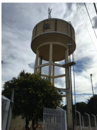
Foto 3.15 - Identificação do Reservatório: Reservatório-01
