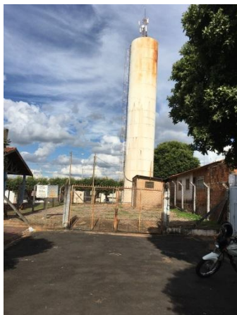
Foto 3.19 - Identificação do Reservatório: Reservatório-06
