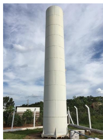
Foto 3.22 - Identificação do Reservatório: Reservatório-08
