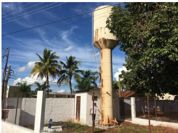
Foto 3.23 - Identificação do Reservatório: Reservatório-09
