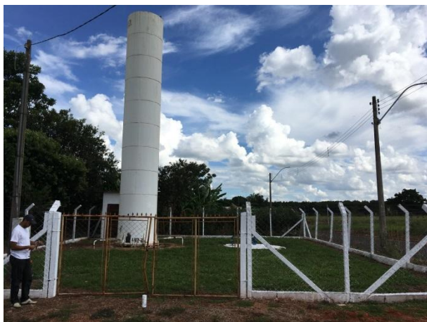
Foto 3.21 - Identificação do Reservatório: Reservatório-07
