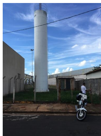
Foto 3.16 - Identificação do Reservatório: Reservatório-03
