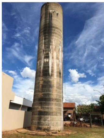
Foto 3.25 - Identificação do Reservatório: Reservatório-11
