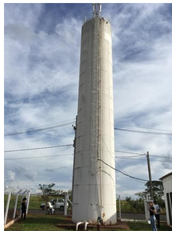
Foto 3.24 - Identificação do Reservatório: Reservatório-10
