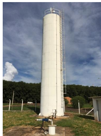
Foto 3.26 - Identificação do Reservatório: Reservatório-13
