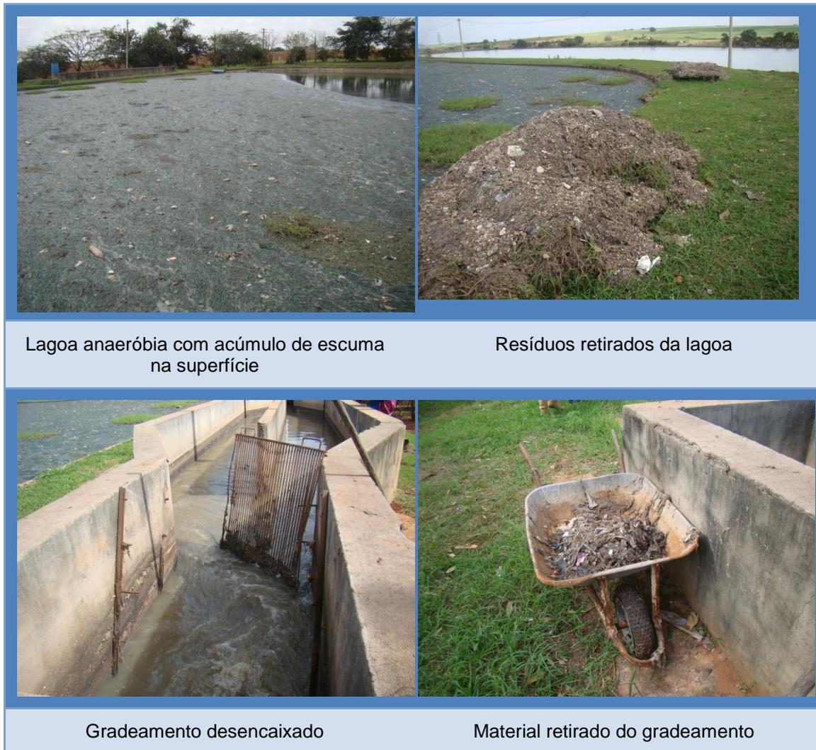
Lagoa anaeróbia com acúmulo de espuma na superfície
