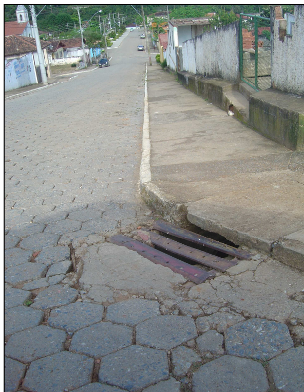
Foto 1 – Microdrenagem Existente no Município de Barra do Chapéu
