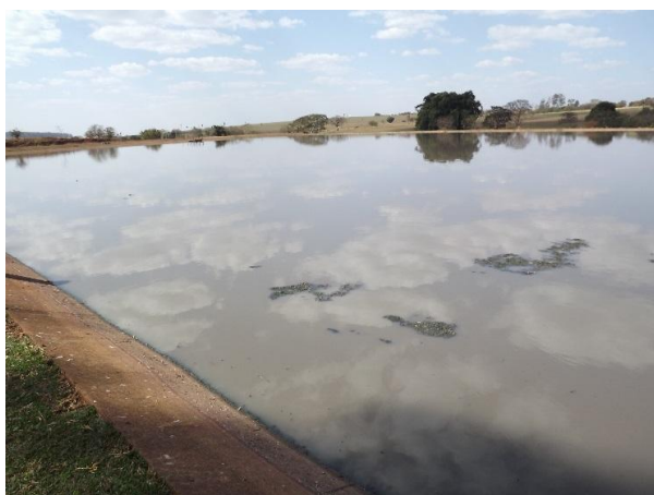
Foto 3.165 – Vista geral da lagoa facultativa
