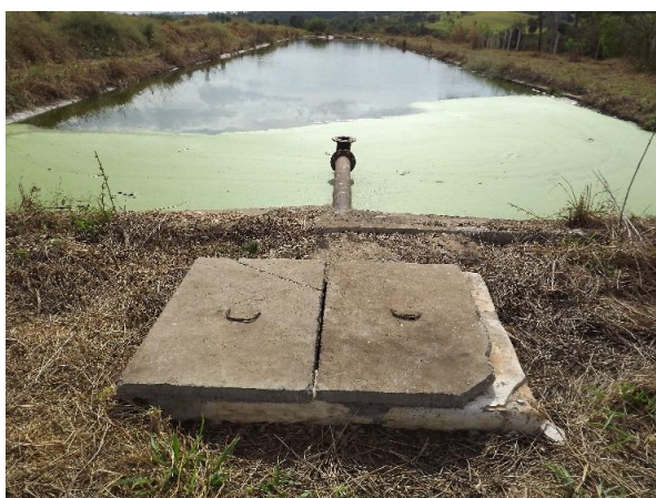
Foto 3.242 – Vista geral da lagoa facultativa com eutrofização
