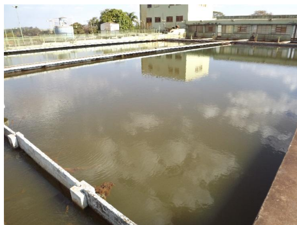
Foto 3.61 – Detalhe dos decantadores retangulares
