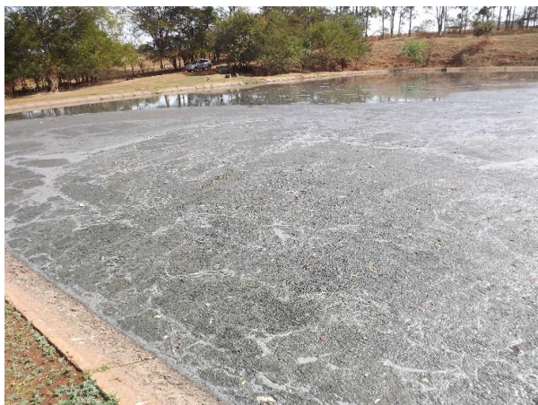
Foto 3.161 – Detalhe de excesso de sobrenadante na lagoa anaeróbia
