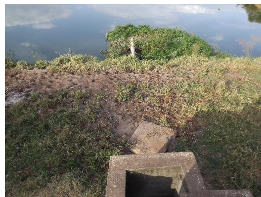
Foto 3.222 – Detalhe de uma das tubulações de entrada na lagoa de estabilização (zona anaeróbia)
