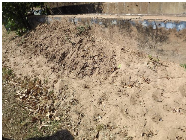
Foto 3.178 – Detalhe do acúmulo de areia retirada do desarenador
