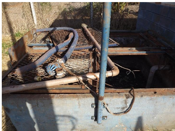
Foto 3.139 – Detalhe de poço de sucção da EEE Jardim Caiçara
