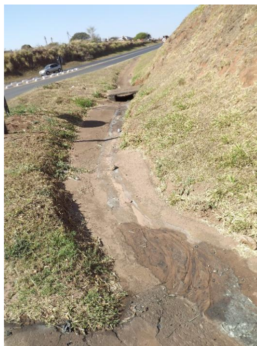
Foto 3.267 – Sarjetão para drenagem de via de acesso do viaduto no ponto apresentado
