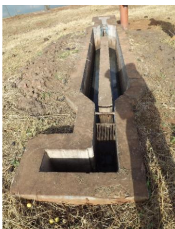
Foto 3.229 – Detalhe da entrada do efluente na ETE VI (gradeamento)
