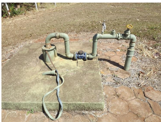
Foto 3.35 – Vista geral do Poço São Francisco
