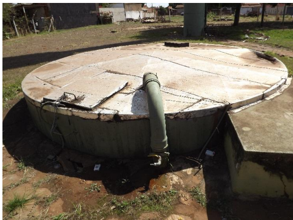
Foto 3.96 – Vista geral do RSE São Francisco
