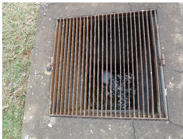
Foto 3.186 – Detalhe da tubulação de saída do efluente para o Córrego das Pedras
