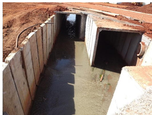
Foto 3.277 – Detalhe de obra de nova canalização em andamento
