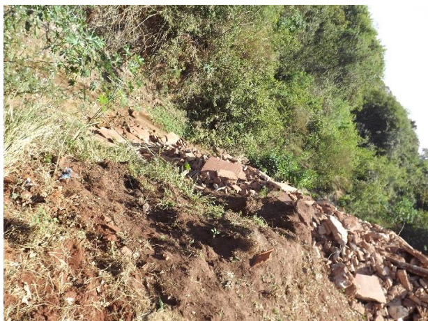
Foto 3.272 – Detalhe de resíduos da construção civil em encosta do córrego
