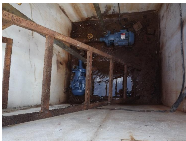
Foto 3.127 – Vista da EEAT Alberto Moreira
