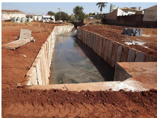
Foto 3.276 – Vista geral da obra de nova canalização do Córrego do Aleixo (Av. 11 com Rua 18)
