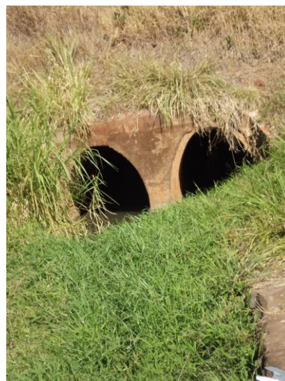
Foto 3.262 – Detalhe da galeria de águas pluviais abaixo da Rod. Brigadeiro Faria Lima
