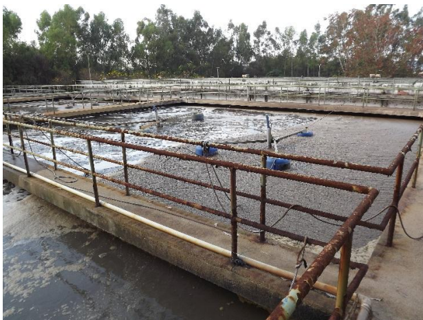
Foto 3.205 – Vista geral de parte do tanque de aeração
