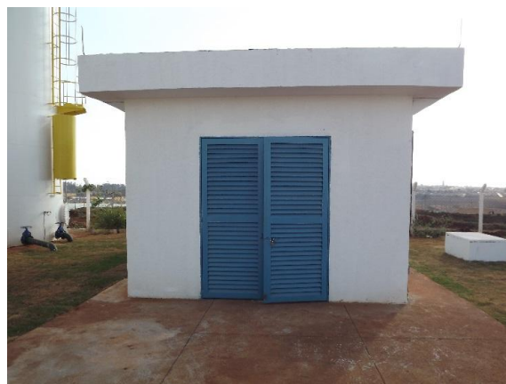
Foto 3.114 – Detalhe de casa de abrigo da EEAT II Vida Nova
