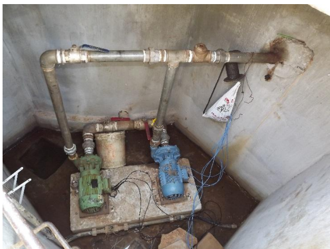
Foto 3.125 – Vista geral da EEAT São Francisco
