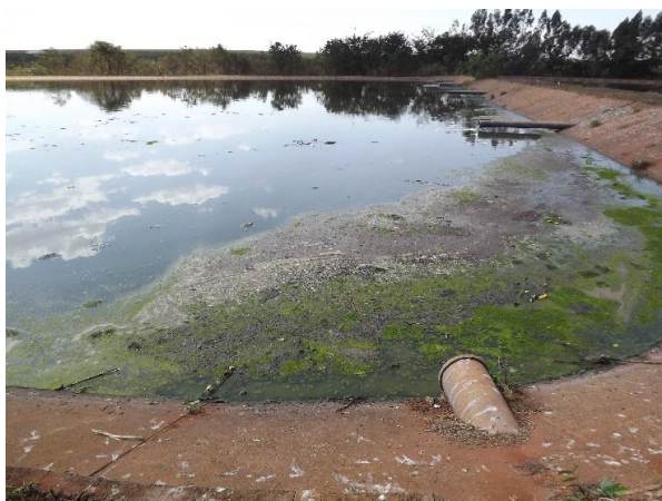
Foto 3.185 – Detalhe de eutrofização na lagoa de polimento
