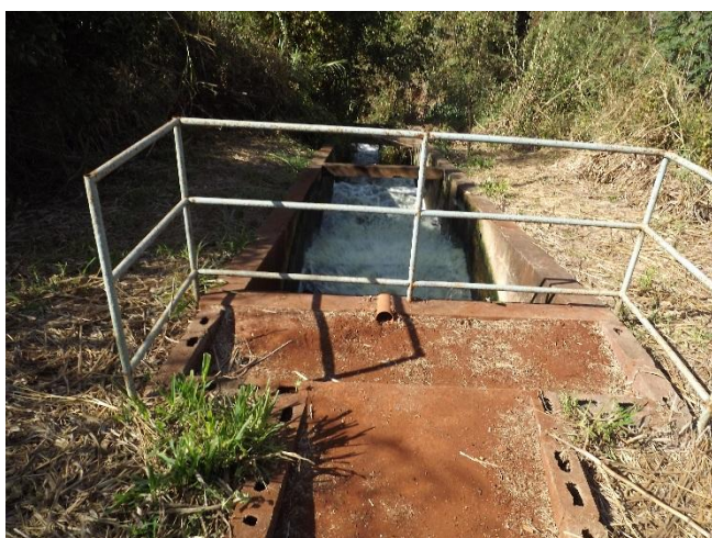
Foto 3.199 – Vista geral da escada hidráulica na saída da ETE III
