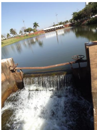
Foto 3.1 – Vista de Lago no Córrego do Aleixo e captação de água bruta
