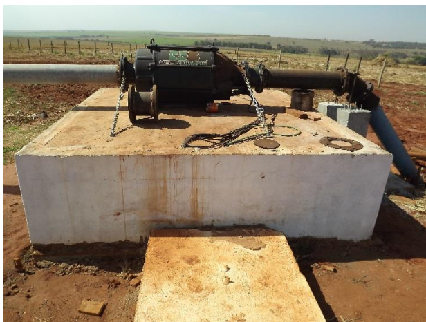
Foto 3.27 – Detalhe do booster na saída do Poço Tubular Profundo Novo
