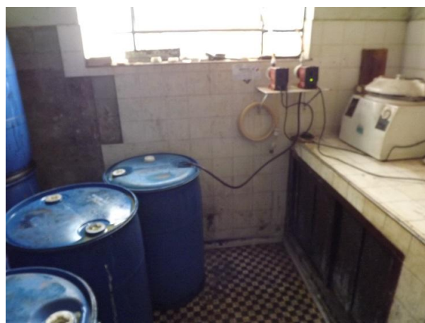
Foto 3.55 – Detalhe de local de armazenagem de PAC (policloreto de alumínio) na ETA
