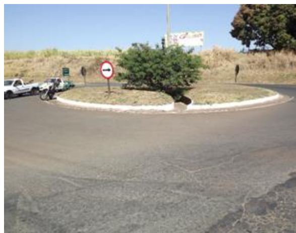
Foto 3.265 – Detalhe estrutura de drenagem na rotatória próximo ao ponto apresentado
