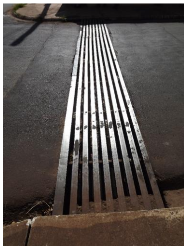
Figura 3.260 – Detalhe de boca de leão no cruzamento da Av. 47 com Rua 24
