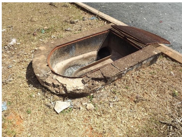
Foto 3.179 – Detalhe de caixa de passagem na entrada da lagoa anaeróbia
