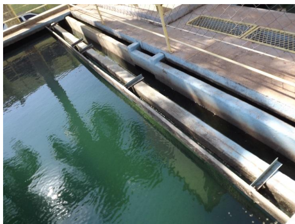
Foto 3.47 – Detalhe de canaleta de drenagem dos decantadores da ETA
