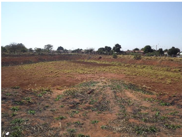
Foto 3.246 – Vista geral da bacia de retenção no bairro São Francisco
