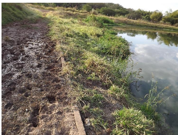
Foto 3.223 – Detalhe de vazamento de esgoto antes da entrada na lagoa (à esq.), assoreamento e eutrofização na lagoa (à dir)
