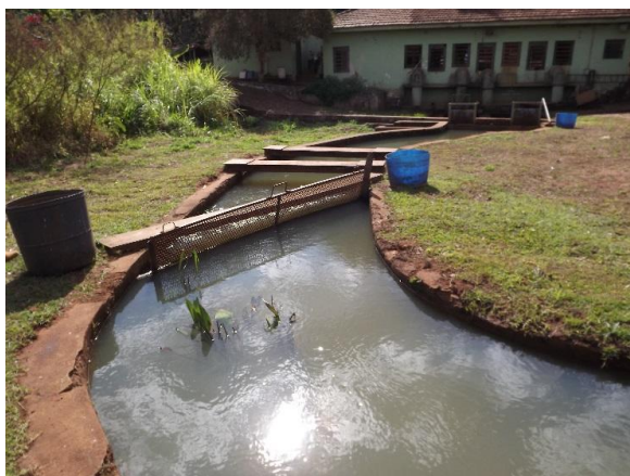
Foto 3.9 – Detalhe de tomada para a captação de água do Ribeirão Pitangueiras
