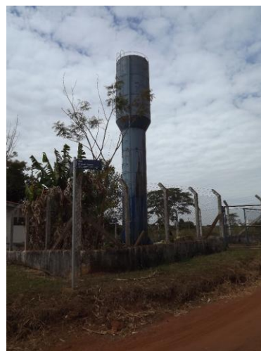
Foto 3.99 – Vista geral do REL Ibitu
