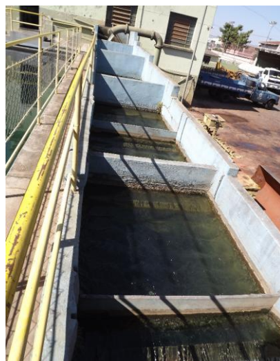
Foto 3.45 – Vista geral do floculador chicaneado
