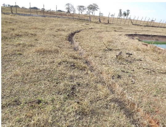
Foto 3.237 – Detalhe do sistema de drenagem de águas pluviais no interior da ETE VI
