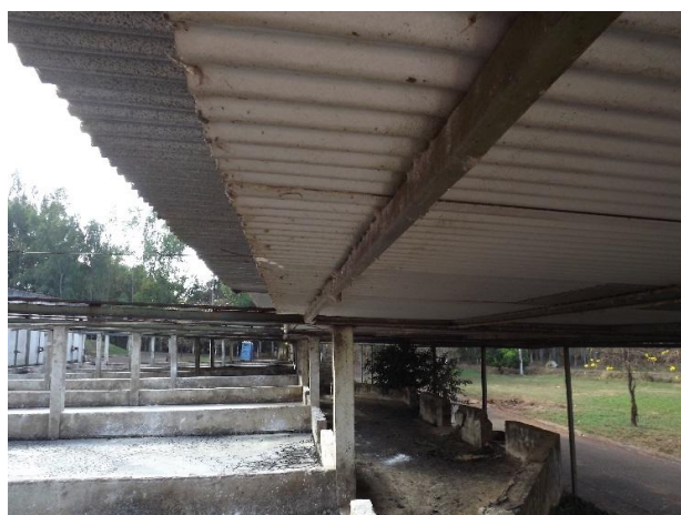
Foto 3.215 – Detalhe do sistema de cobertura móvel com acionamento manual
