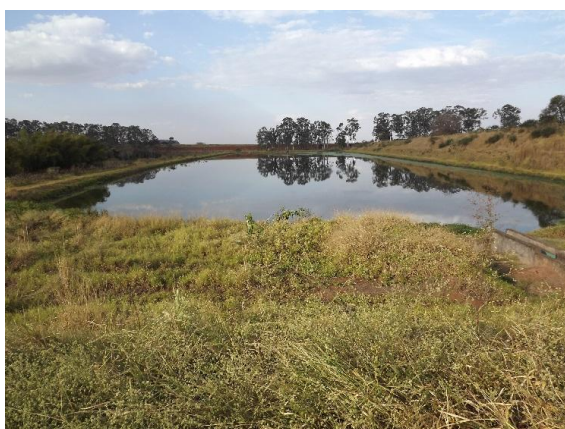
Foto 3.227 – Vista geral da lagoa de tratamento da ETE V
