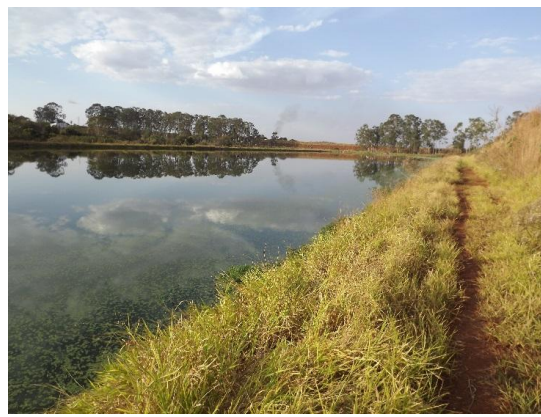
Foto 3.226 – Vista geral da lagoa de estabilização com detalhe para o crescimento de algas no seu interior
