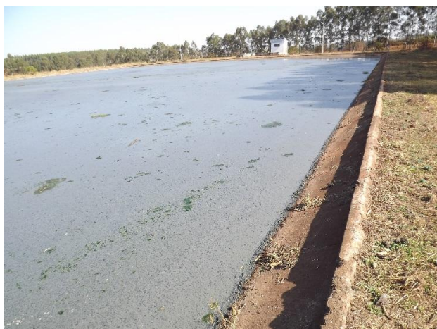
Foto 3.195 – Detalhe de lagoa anaeróbia com excesso de sobrenadante – Linha 2
