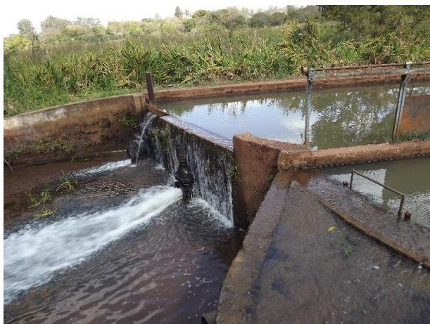
Foto 3.7 – Vista geral de barragem para captação de água superficial no Ribeirão Pitangueiras
