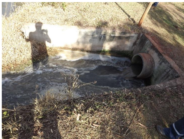
Foto 3.218 – Ponto de lançamento do efluente da ETE IV no Ribeirão Pitangueiras
