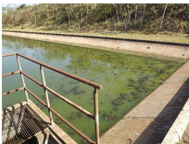
Foto 3.194 – Detalhe de eutrofização na lagoa de maturação (Linha 1) na ETE III
