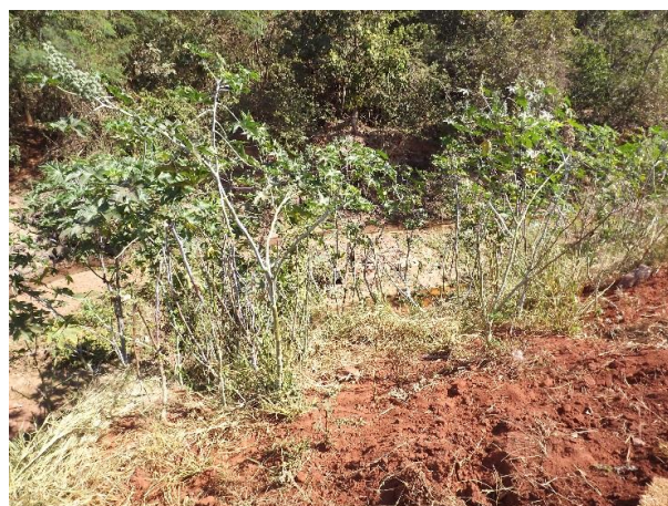
Foto 3.275 – Detalhe do talude nas margens do córrego
