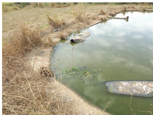
Foto 3.241 – Detalhe de manta geotêxtil na superfície da lagoa anaeróbia e eutrofização
