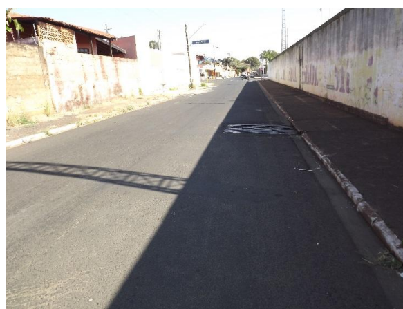
Figura 3.253 – Vista de boca de lobo em forma de grelha (vertedor de soleira livre) na Rua 24 (entre Av. 43 e 45)
