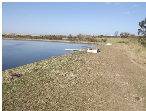
Foto 3.190 – Detalhe de tubulação de entrada da lagoa anaeróbia (apenas uma em funcionamento)
