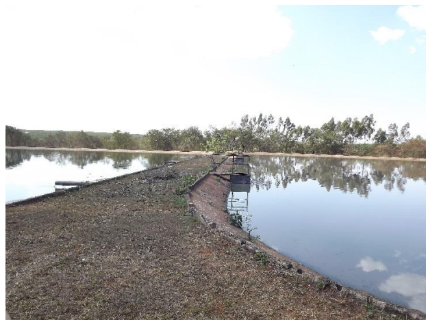
Foto 3.184 – Saída da lagoa de maturação e entrada da lagoa de polimento
