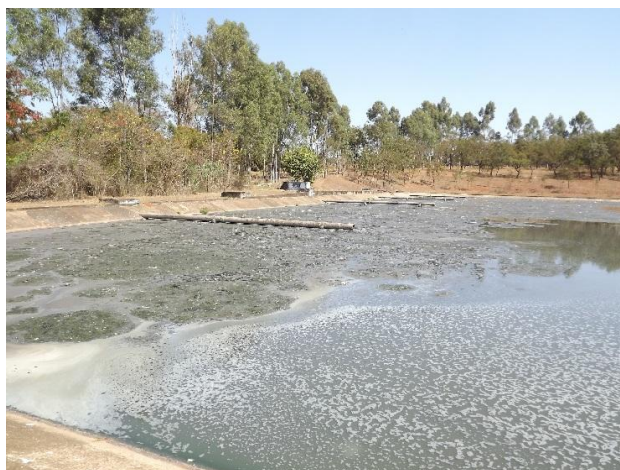
Foto 3.180 – Detalhe de excesso de sobrenadante na lagoa anaeróbia
