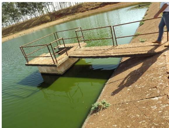
Foto 3.168 – Vista geral da lagoa de maturação (eutrofizada) e vertedor (à frente)
