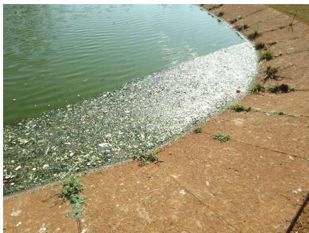
Foto 3.169 – Detalhe de sólidos grosseiros acumulados na lagoa de maturação
