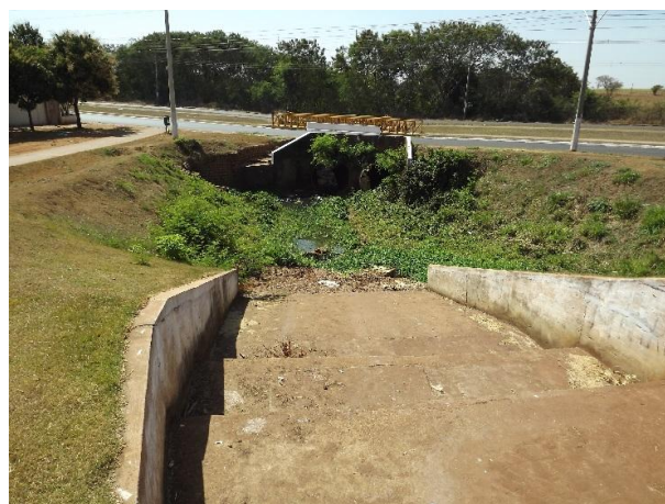
Foto 3.249 – Detalhe do vertedor de lago do Parque Ecológico Enéas Carneiro
