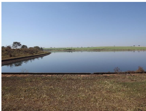
Foto 3.196 – Vista geral de lagoa facultativa – Linha 2
