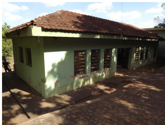
Foto 3.14 – Vista geral de casa de bombas da captação no Ribeirão Pitangueiras
