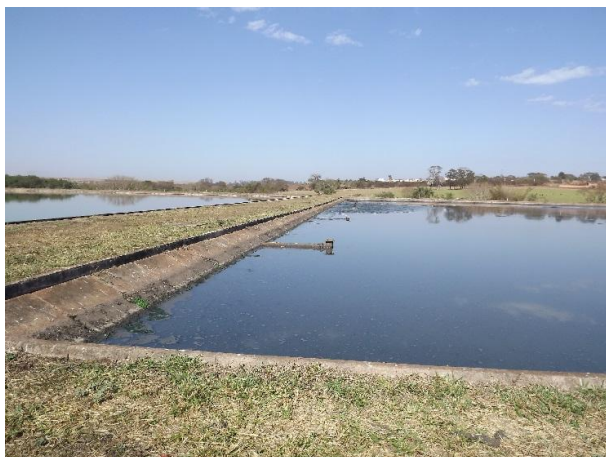
Foto 3.191 – Saída da lagoa anaeróbia e entrada na lagoa facultativa – Linha 1
