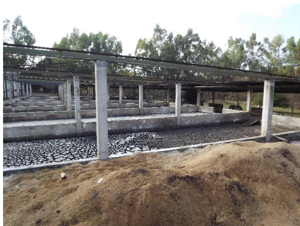
Foto 3.214 – Vista geral dos leitos de secagem de lodo
