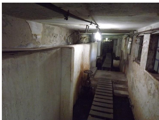
Figura 3.54 – Saída dos filtros e canaleta de aplicação de cloro e flúor (à esquerda)
