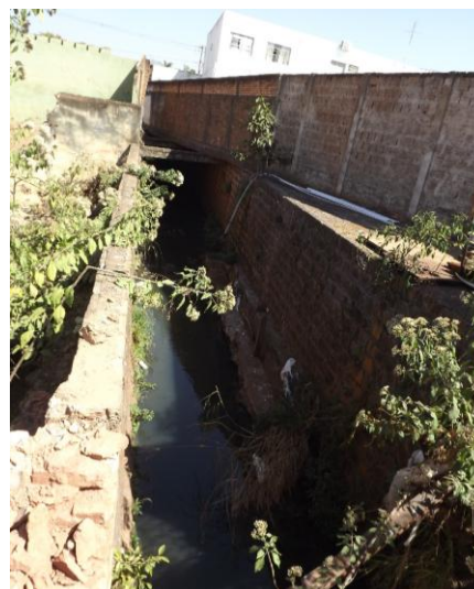
Figura 3.283 – Canal antigo de drenagem de águas pluviais no Córrego do Aleixo (Rua 22 entre Av 11 e 13)
