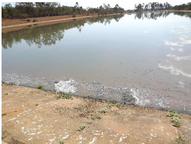
Foto 3.183 – Vista geral da lagoa facultativa
