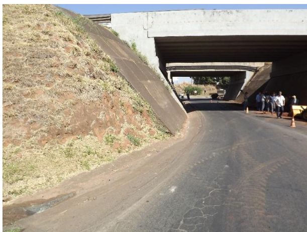
Foto 3.264 – Vista geral viaduto na Av. Rio Dalva, abaixo da Rod. Brigadeiro Faria Lima
