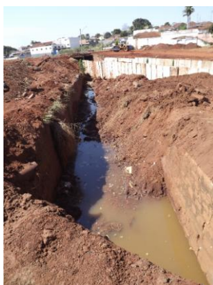
Foto 3.278 – Detalhe de canal novo (em construção) e antigo do Córrego do Aleixo
