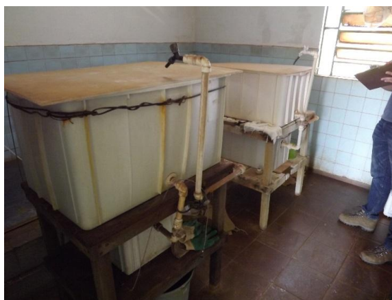
Foto 3.24 – Detalhe do reservatório de ácido fluorssilícico no Poço Comitivas
