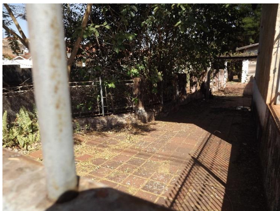
Figura 3.280 – Trecho do canal do Córrego do Aleixo que cruza interior de residência na Rua 20
