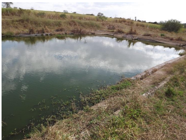
Foto 3.238 – Vista geral da lagoa anaeróbia – ETE VII Ibitu
