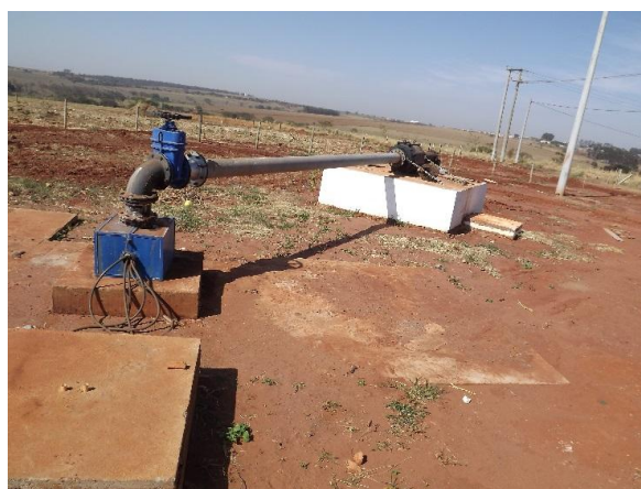
Foto 3.26 – Vista geral do Poço Tubular Profundo Novo
