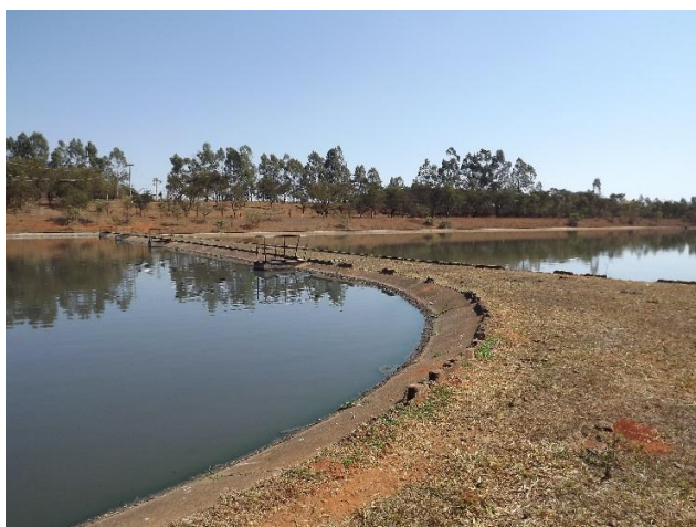
Foto 3.181 – Detalhe de saída da lagoa anaeróbia e problemas no talude
