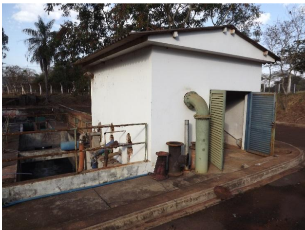
Foto 3.153 – Vista geral da ETE IV
