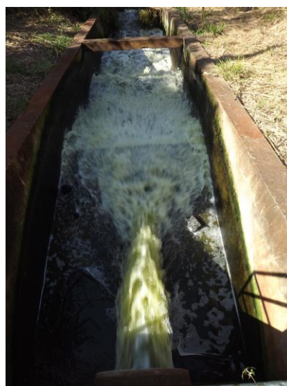
Foto 3.200 – Detalhe de lançamento de efluente tratado na escada hidráulica na ETE III
