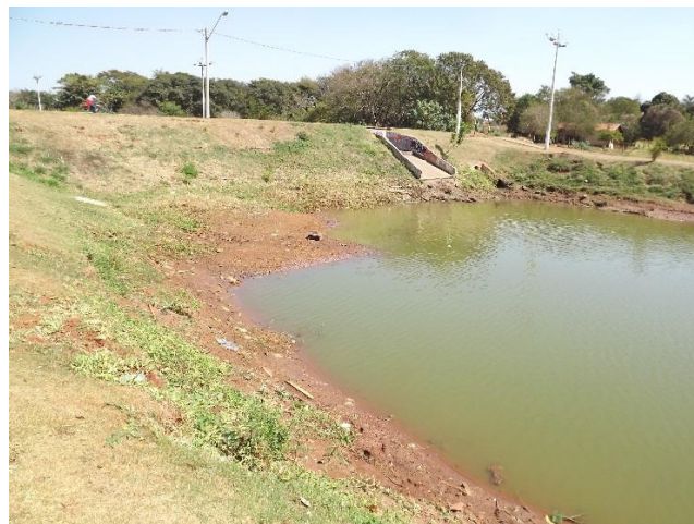
Foto 3.247 – Vista geral da bacia de retenção do Parque Ecológico Enéas Carneiro
