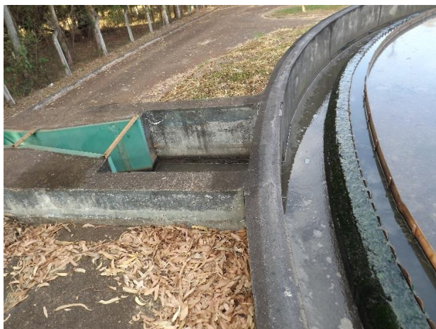
Foto 3.217 – Detalhe de ponto de saída do efluente do decantador secundário para lançamento no corpo hídrico
