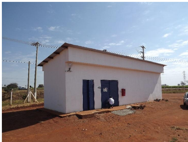
Foto 3.28 – Detalhe de casa de energia do Poço Tubular Profundo Novo
