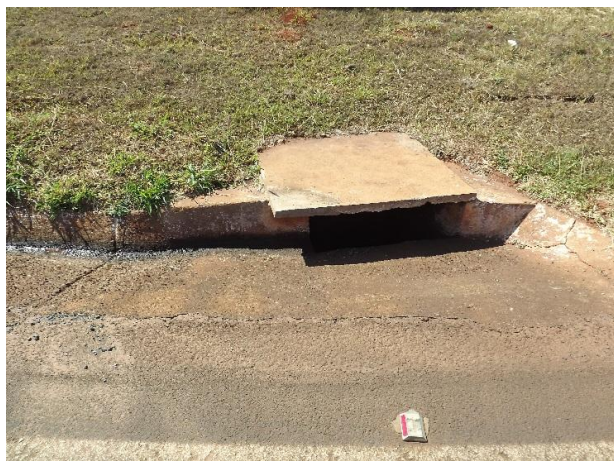
Foto 3.270 – Detalhe de boca de lobo no ponto apresentado
