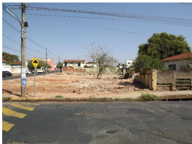
Figura 3.282 – Detalhe de terreno desapropriado para a construção de novo canal de drenagem de águas pluviais
