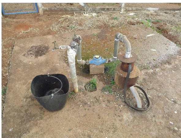
Foto 3.41 – Vista geral do Poço Alberto Moreira
