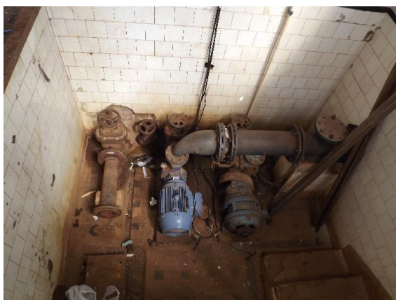
Foto 3.105 – Vista geral da EEAT São Benedito
