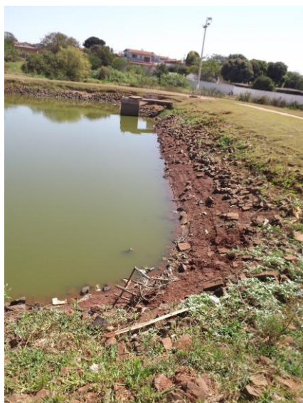
Foto 3.248 – Detalhe do talude da bacia de retenção do Pq. Ecológico Enéas Carneiro
