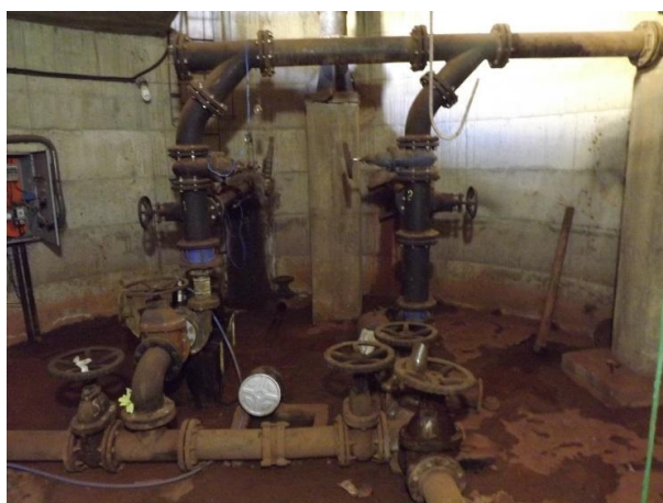
Foto 3.117 – Vista geral da EEAT Cristiano de Carvalho
