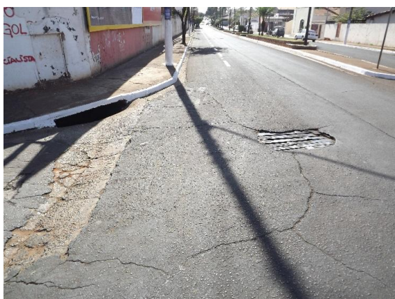
Figura 3.250 – Vista do cruzamento da Rua 24 com Av. 43 com detalhe para boca de lobo na esquina e grelha no leito carroçável
