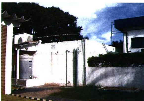
Foto 08 - Reservatório semi enterrado de 260m<sup>3</sup>
