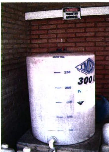
Foto 02 - Tanque de armazenamento de ácido Fluossilícico
