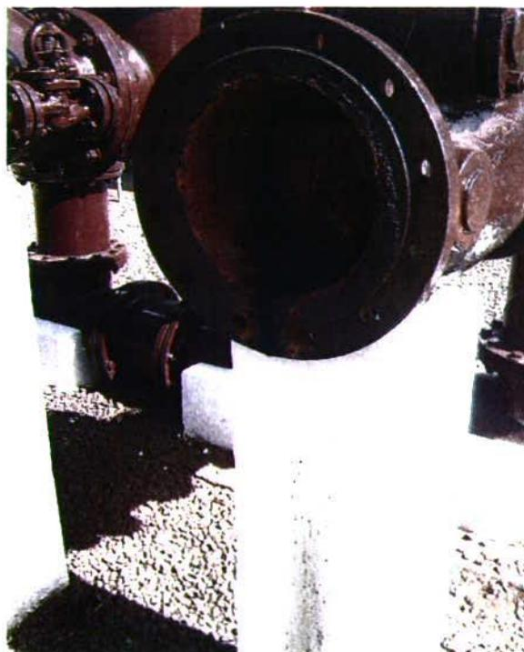
Foto 16: Bocal da bomba, com vazamento
