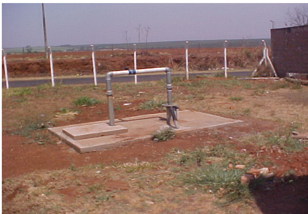
Vista de Poço Artesiano
