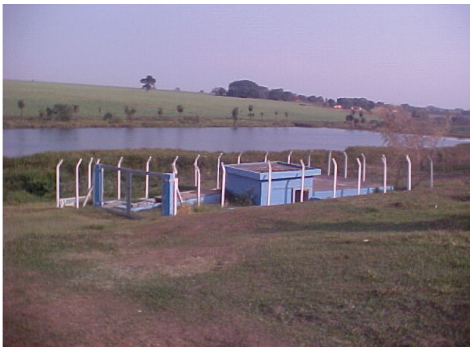
Vista da Elevatória de Esgoto Bruto
