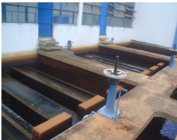
Vista dos Filtros ETA 2
