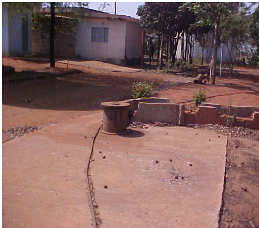
Vista do Poço 2 – a ser recuperado
