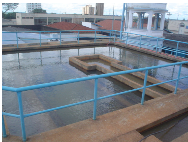
Vista do Decantador ETA 1
