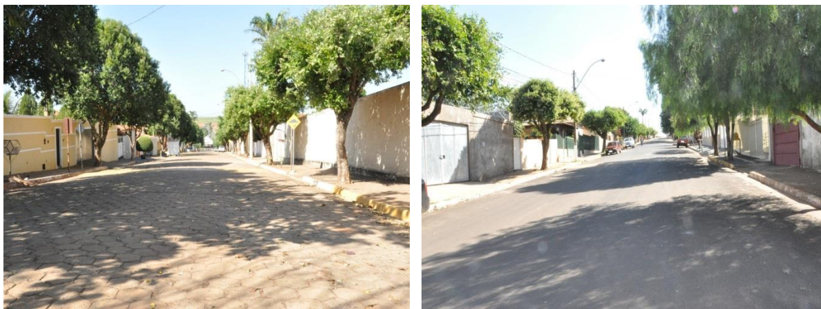
Figura 43. Alagamento na Rua Hugo Scatena, cruzamento com as Ruas Ernesto Scatena e Rua 27 de Março
