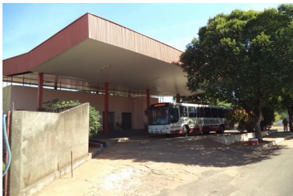
Figura 92. Terminal Rodoviário do Município de Bento de Abreu
