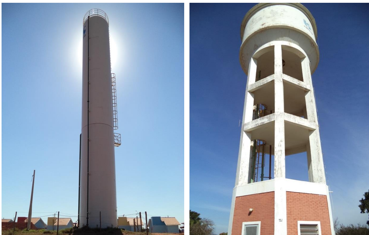
Figura 23. Reservatório 1 e 2, respectivamente
