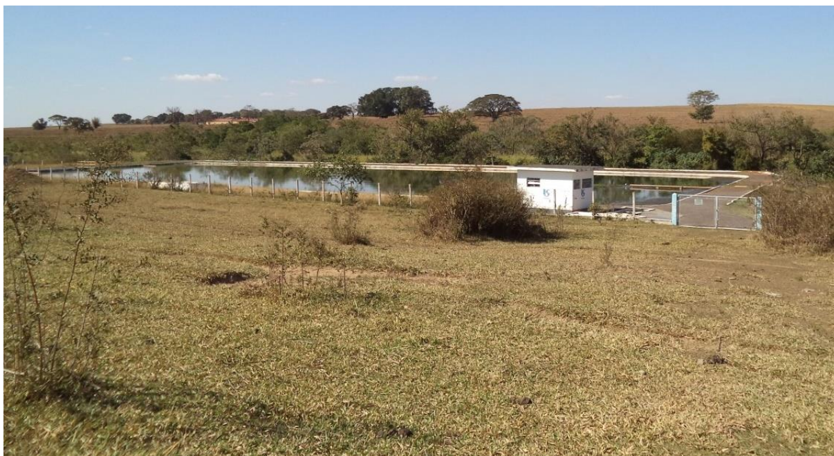
Figura 28. Estação de Tratamento de Esgoto em Bento de Abreu
