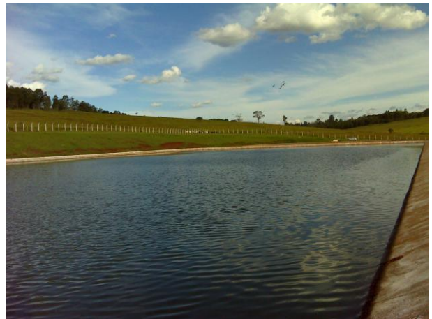
FOTO 4.13 – LAGOA FACULTATIVA DA ETE NORTE
