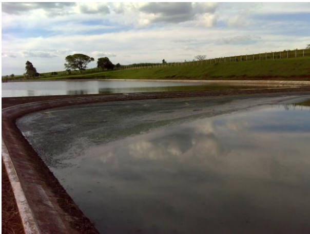
FOTO 4.12 – LAGOAS ANAERÓBIA E FACULTATIVA DA ETE NORTE
