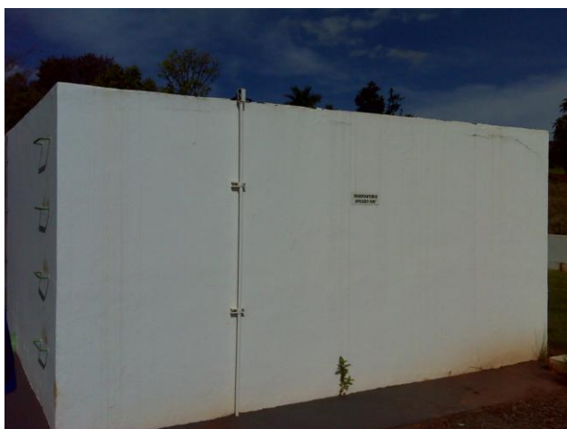
FOTO 4.3 – RESERVATÓRIO APOIADO R5
