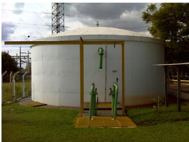
FOTO 4.5 – RESERVATÓRIO APOIADO R4
