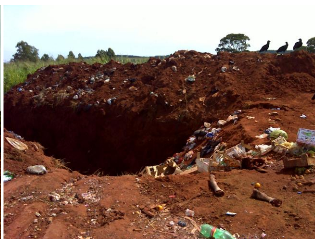
FOTO 4.17 – VALA ABERTA NO ATERRO DE BERNARDINO DE CAMPOS
