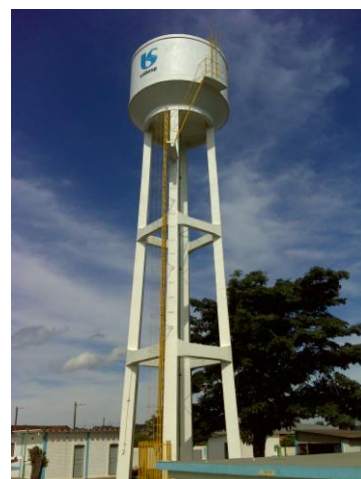
FOTO 4.6 – RESERVATÓRIO ELEVADO T1
