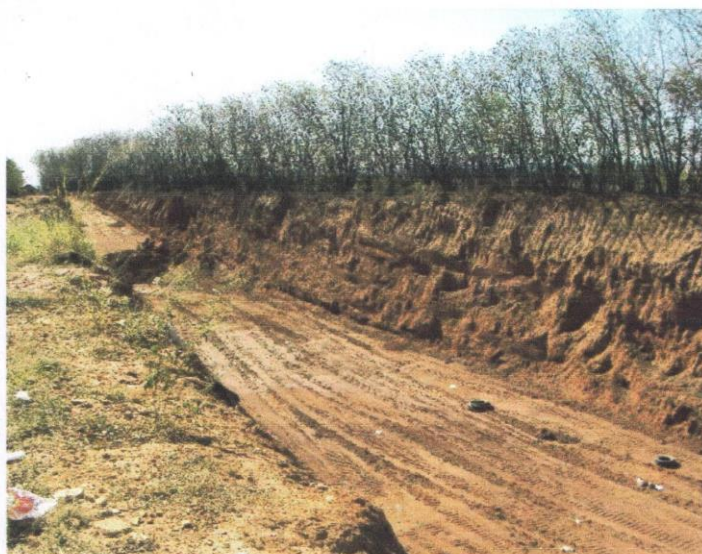
Foto 03: Acesso às valas
