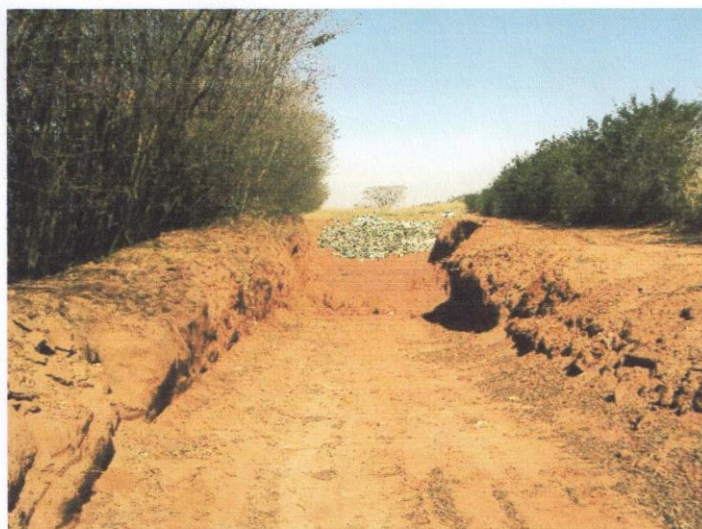
Foto 04: Vala aberta com resíduos - antes do aterramento da vala
