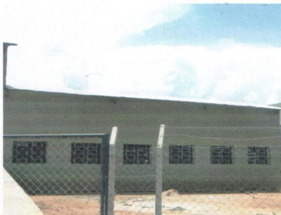
Foto 09 - Galpão para futura triagem
