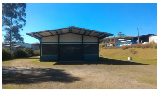
Foto 3.9 – Exterior do posto de recebimento
