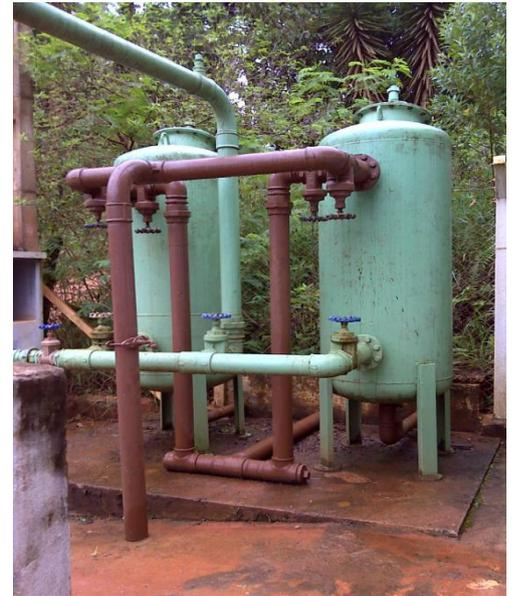
FOTO 4.5 – DETALHE DOS FILTROS DA ETA DE BOM SUCESSO DE ITARARÉ
