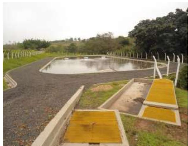
FIGURA 02: Lagoa aeróbica para tratamento de esgoto em Borá.
