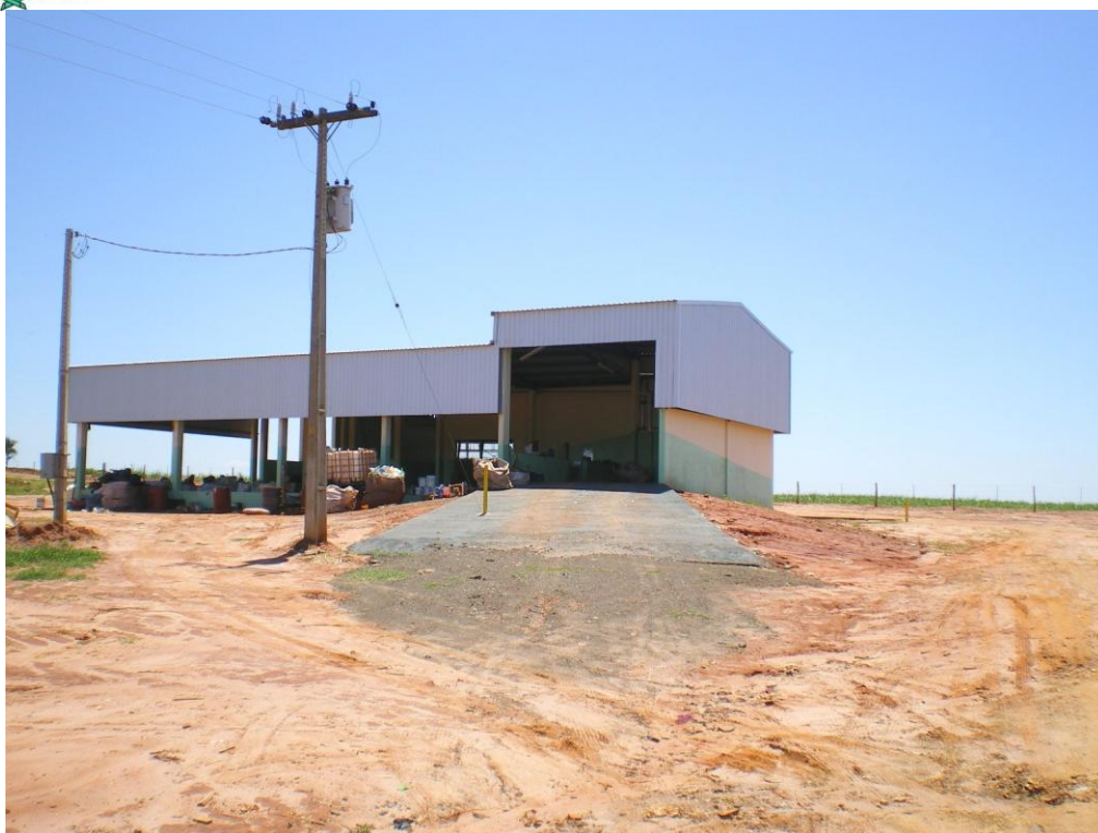
FIGURA 02 – Central de Reciclagem
