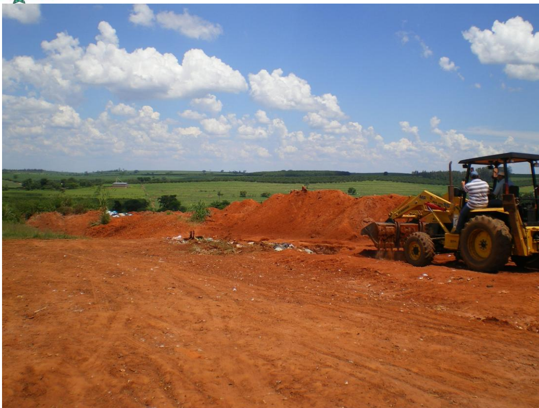
FIGURA 05 – Aterro em Valas sendo operado
