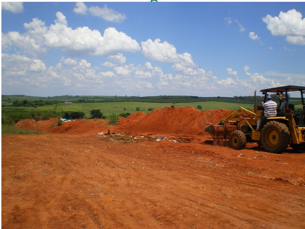
FIGURA 05 – Aterro em Valas sendo operado
