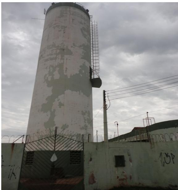
**Imagem 66 – Reservatório nº 19 – Elevado de concreto, com capacidade de 200 m<sup>3</sup> localizado no sistema de reservação São João.**
