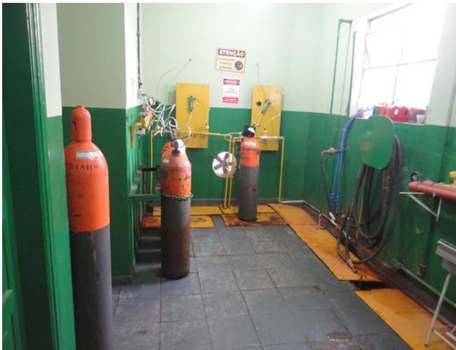
Imagem 35 – Cilindros de cloro liquefeito
