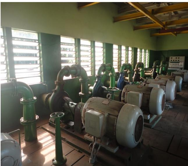
**Imagem 46 – Conjunto de bombas de recalque de água para os reservatórios do pátio da SAE (EEAT 01)**
