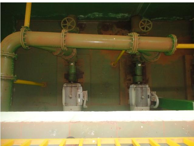
**Imagem 48 – Conjunto de bombas de recalque de água para os reservatórios bairro Paineiras (EEAT 03)**
