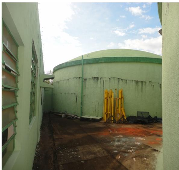
**Imagem 62 – Reservatório nº 11 – Apoiado de concreto, com capacidade de 1000m<sup>3</sup> localizado no Pátio da SAE.**
