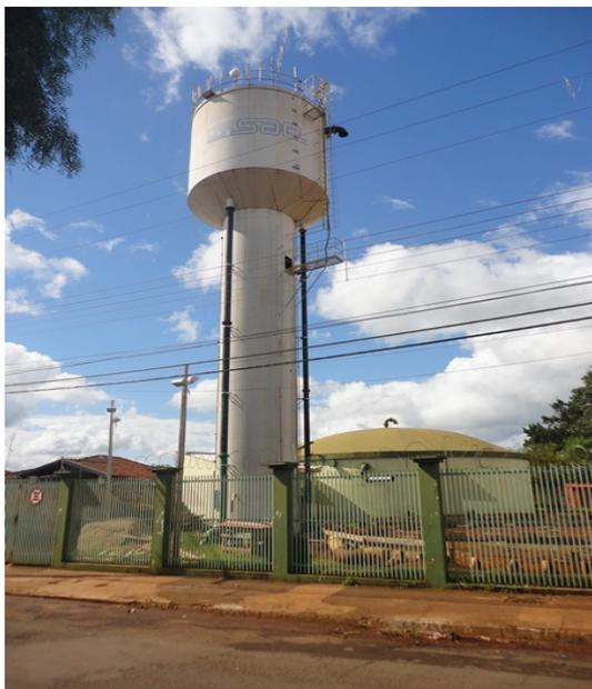
**Imagem 69 – Reservatórios nº 20,26 e 28 – com capacidade total de 2150 m<sup>3</sup> localizados no Jd. Anchieta.**
