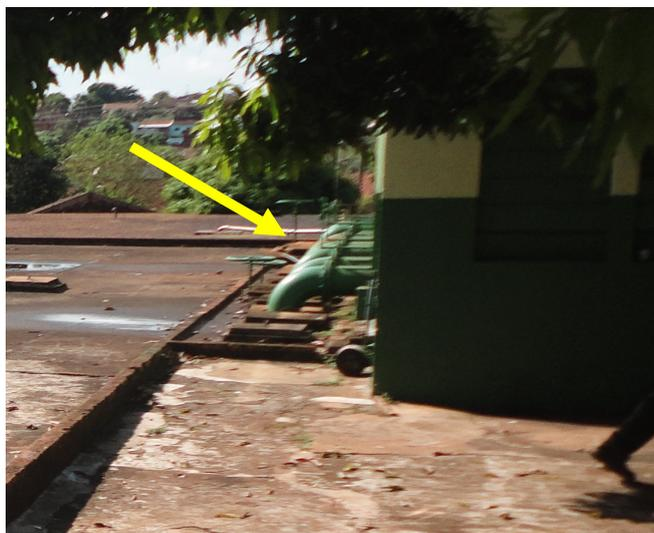
**Imagem 45 – Canos de sucção do conjunto moto bomba instalados na EEAT**
