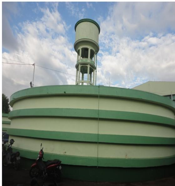
**Imagem 61 – Reservatório nº 06 – Apoiado de concreto, com capacidade de 1000m<sup>3</sup> localizado no Pátio da SAE.**
