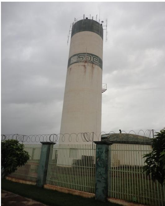
**Imagem 63 – Reservatório nº 23 – Elevado de concreto, com capacidade de 200 m<sup>3</sup> localizado no sistema de reservação São Silvestre.**
