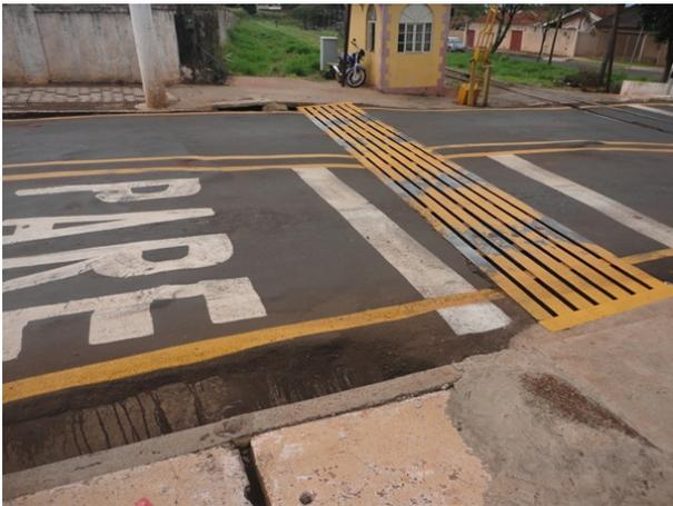
**Imagem 115 – Canal de drenagem construído após o acidente**
