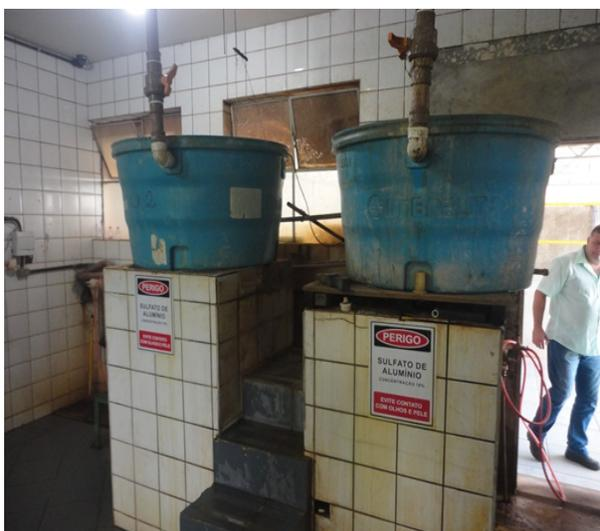
Imagem 37 – Armazenamento de sulfato de alumínio
