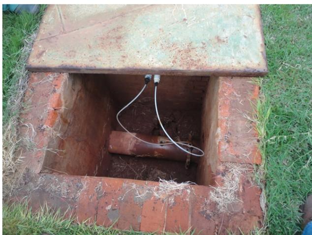
**Imagem 59 – Aplicação de hipoclorito de sódio e fluor na saída do cavalete do Poço São João**
