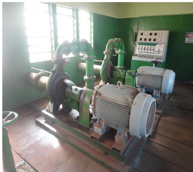
**Imagem 47 – Conjunto de bombas de recalque de água para os reservatórios do Pq. Minas Gerais (EEAT 02)**
