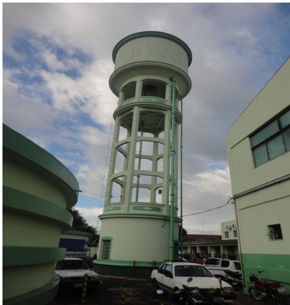
**Imagem 60 – Reservatório nº 01 – Elevado de concreto, com capacidade de 150 m<sup>3</sup> localizado no Pátio da SAE.**
