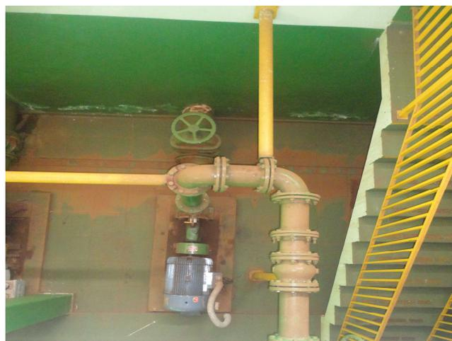
**Imagem 49 – Bomba de recalque de água para os reservatórios bairro Anchieta (EEAT 04)**
