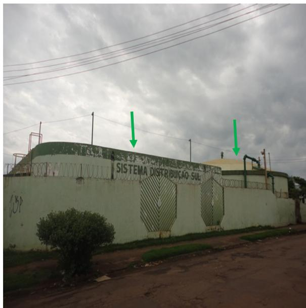
**Imagem 67 – Reservatórios nº 12 e 18 – Apoiados de concreto, com capacidade de 1000 m<sup>3</sup> cada, localizados no sistema de reservação São João.**
