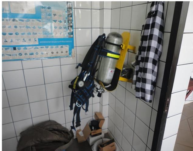
Imagem 36 – Mascáras e tubo de oxigênio para para adentrar a sala de armazenamento
