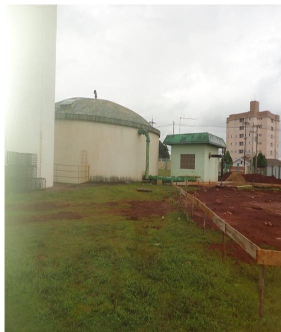
**Imagem 64 – Reservatório nº 22 – Apoiado de concreto, com capacidade de 1000 m<sup>3</sup> localizado no sistema de reservação São Silvestre.**
