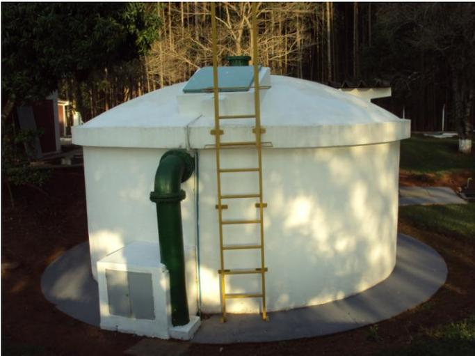
FOTO 4.5 - RESERVATÓRIO R1 DE 50M<sup>3</sup> - LOCALIZADO NA ETA BURI
