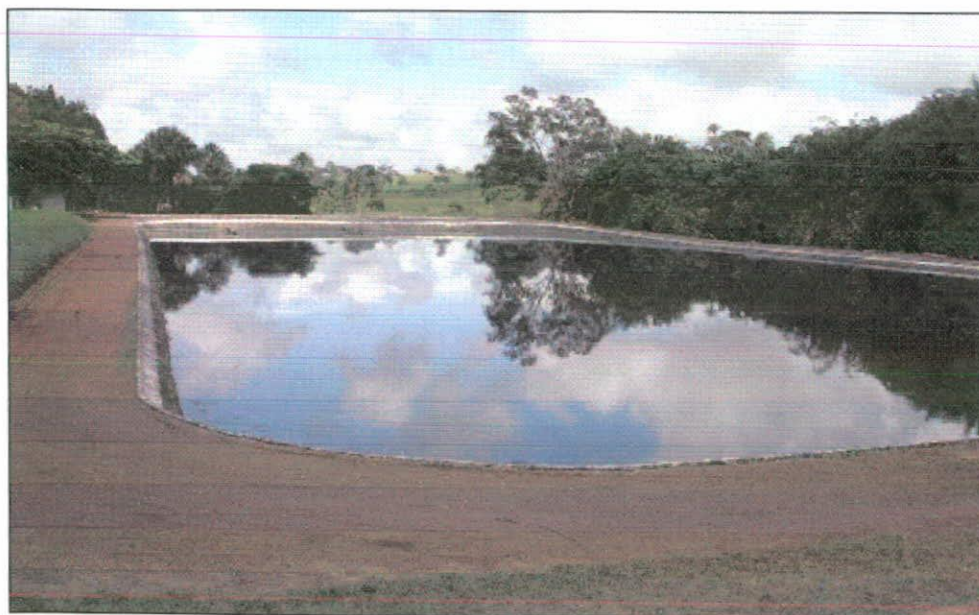
Foto 11- Lagoas de tratamento de esgoto anaeróbia e facultativa
