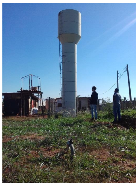
Foto 3.40 – Vista do reservatório R15
