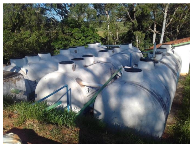
Foto 3.60 – ETE Bacuriti desativada
