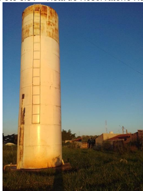
Foto 3.36 – Vista do reservatório R09
