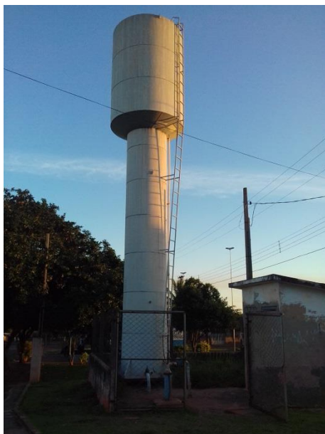
Foto 3.37 – Vista do reservatório R10
