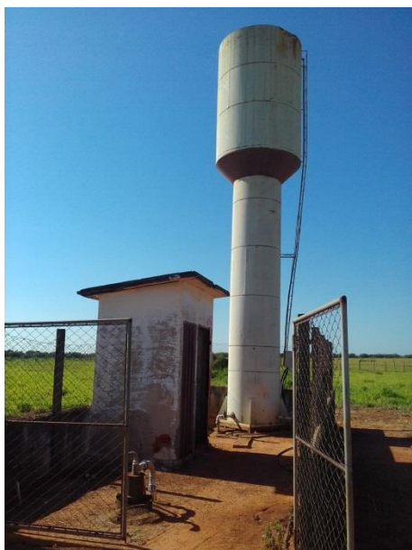
Foto 3.41 – Vista do reservatório R16
