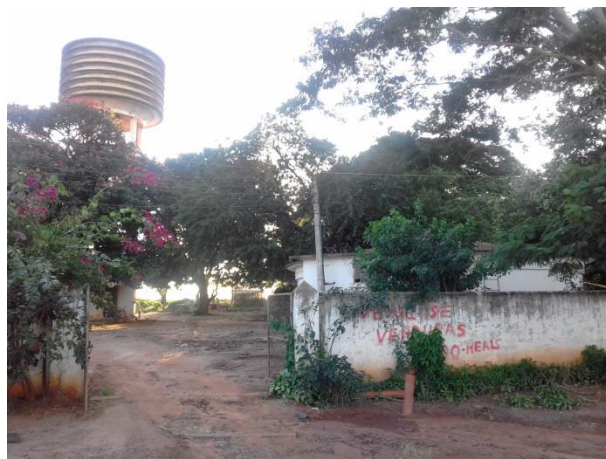
Foto 3.34 – Vista do Reservatório R07
