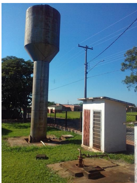
Foto 3.39 – Vista do reservatório R14
