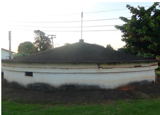
Foto 3.29 – Vista do reservatório R02
