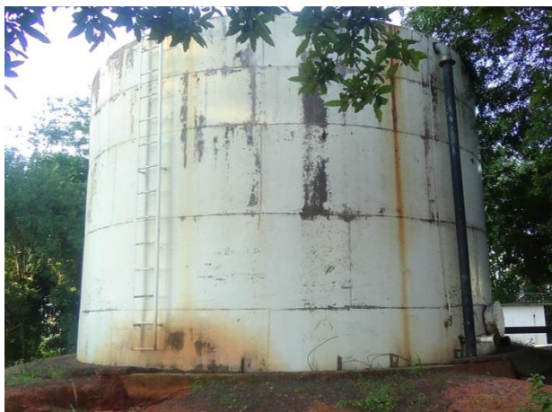
Foto 3.33 – Vista do reservatório R06
