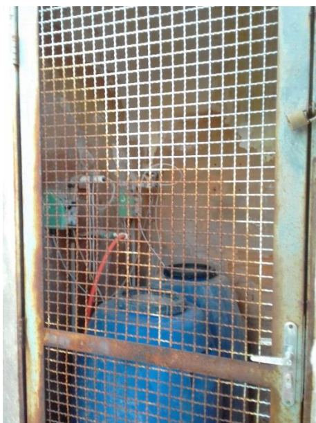
Foto 3.26 – Vista do tratamento do P5
