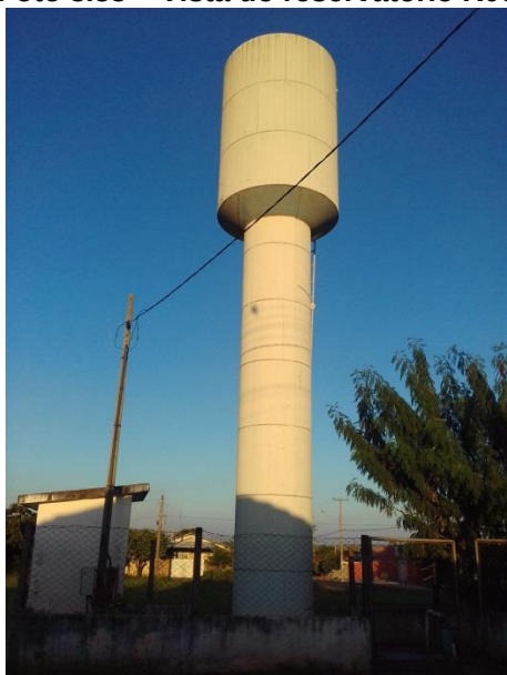
Foto 3.35 – Vista do reservatório R8
