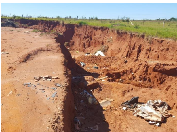
Foto 3.70 – Descarte inadequado de resíduos no “Buracão”
