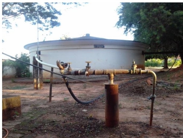
Foto 3.32 – Vista do reservatório R05
