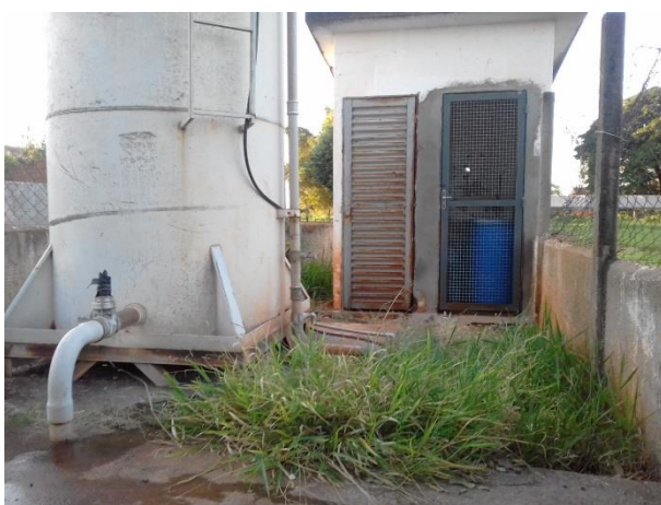
Foto 3.24 – Vista do tratamento do P3
