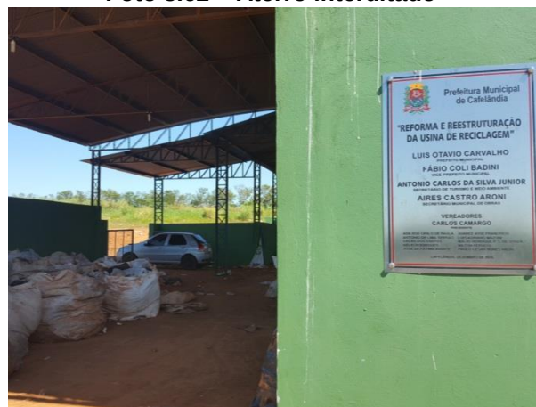
Foto 3.64 – Galpão de triagem
