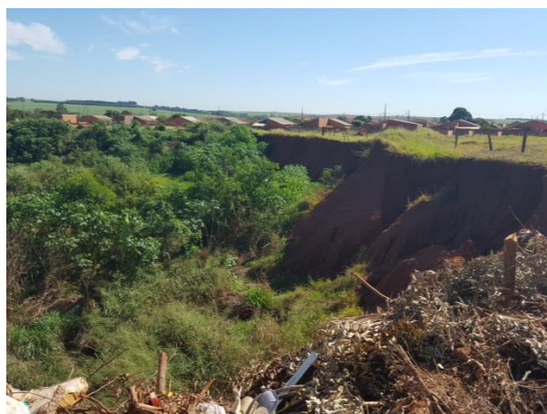
Foto 3.69 – Descarte inadequado de resíduos no “Buracão”
