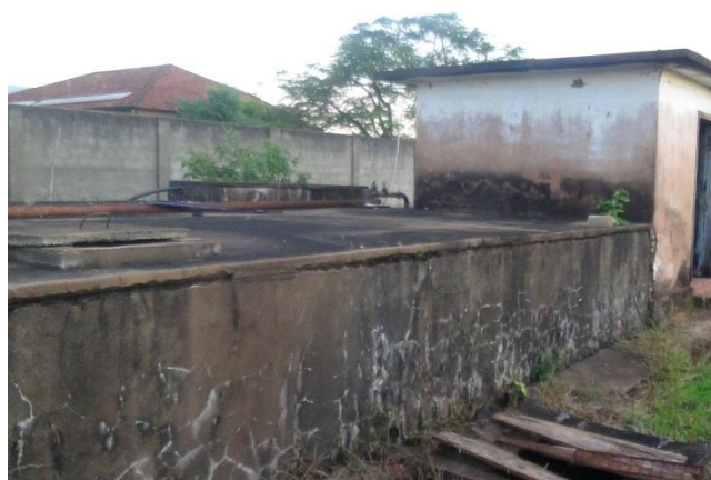
Foto 3.30 – Vista do reservatório R03
