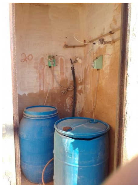
Foto 3.27 – Vista do tratamento do P9
