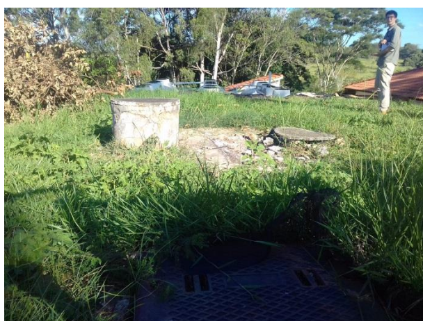
Foto 3.59 – ETE Bacuriti desativada
