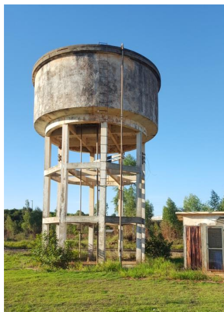
Foto 3.42 – Vista do reservatório R17
