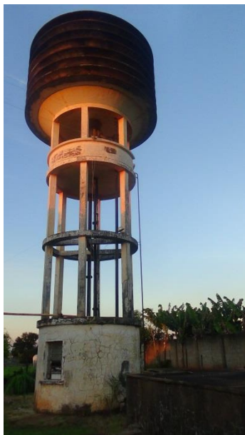
Foto 3.31 – Vista do reservatório R04
