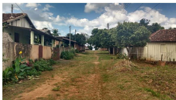
Foto 3.18 – Via sem pavimentação e drenagem – Rua Manoel Batista do Santos – Dist. Iubatinga
