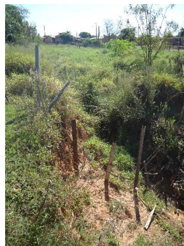
Foto 3.22 – Ponto de descarga da galeria de água pluvial – Bairro Sol Nascente
