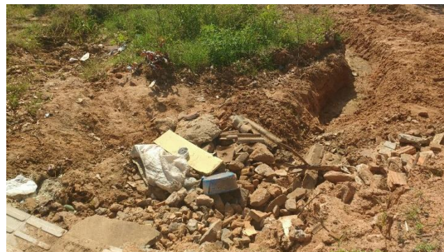
Foto 3.20 – Uso de RCC para dissipação de energia – Rua Domingos Mareco de Souza
