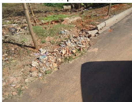
Foto 3.16 – Utilização de RCC nas vias do município
