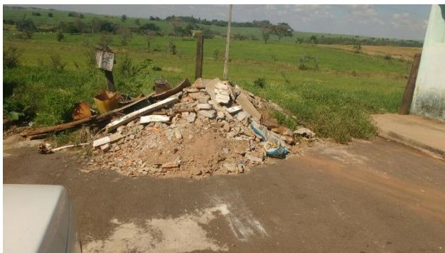
Foto 3.13 – Disposição de RCC para recolhimento pela Prefeitura
