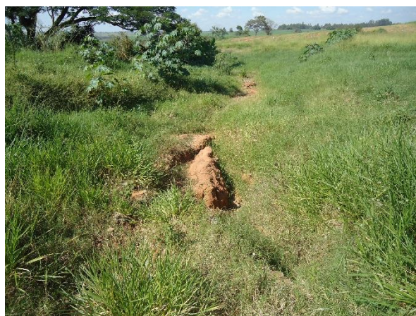
Foto 3.28 – Extensão do processo erosivo – COAB 3
