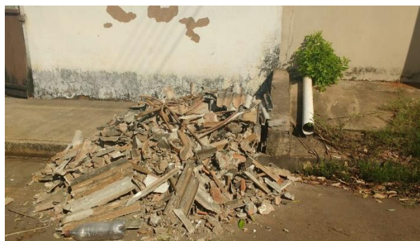
Foto 3.14 – Disposição de RCC para recolhimento pela Prefeitura
