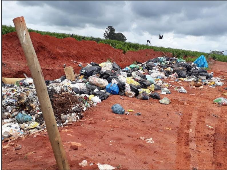
Figura 16: Rejeitos depositados na vala.
