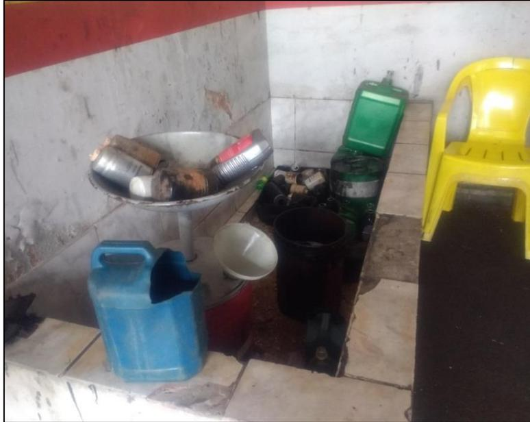
No entorno da canaleta de captação, existem canaletas menores que fazem a captação do óleo derramado e que vão diretamente à caixa SAO (Separadora de Água e Óleo) para que posteriormente sejam recolhidas pela empresa Suplicerve, juntamente com o tambor de armazenamento, embalagens e estopas como mostrado nas Figuras 54 e 55.
