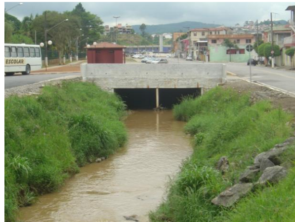
Figura 19 Início do trecho canalizado do Ribeirão dos Cristais no Distrito de Jordanésia
