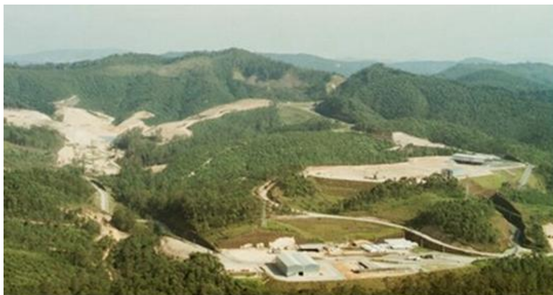
Figura 40 Unidade de Caieiras – Essencis
