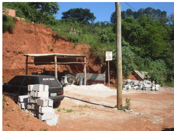
Vau Novo – fábrica de blocos
