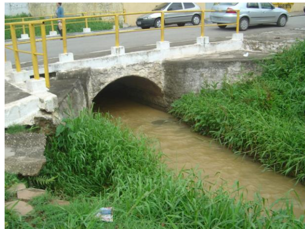
Figura 20 Travessia sob o Córrego da Lavrinha na sede de Cajamar
