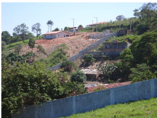
Ponunduva – aterro com RCC
