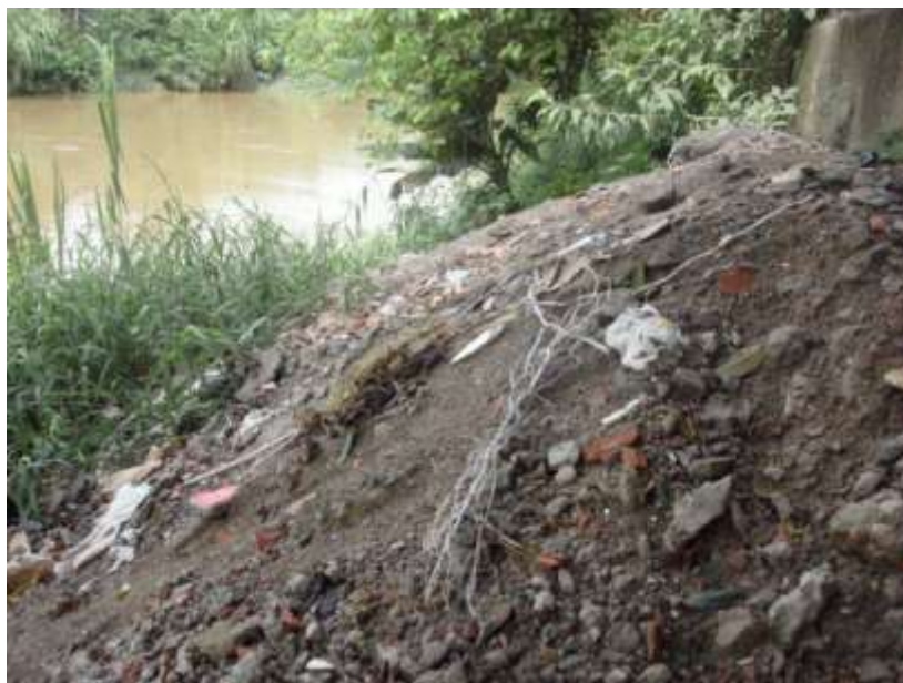
Figura 19 - Local de Disposição Irregular de RCC.
