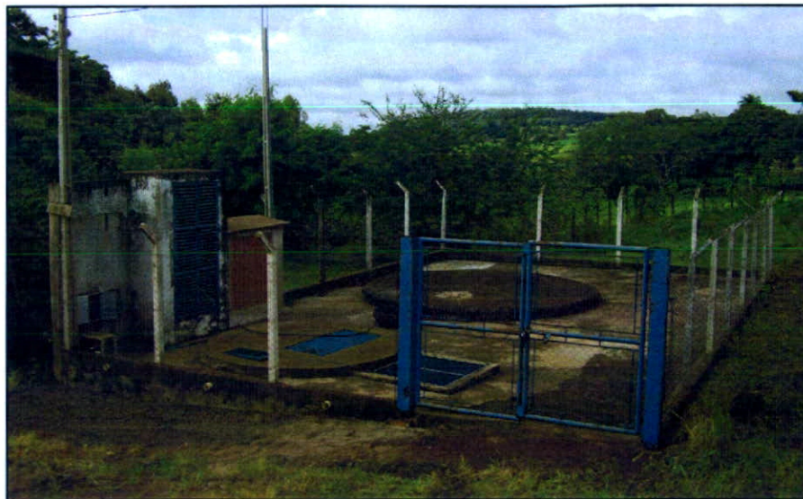
Foto 14 - Vista da EEE Matadouro
