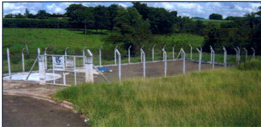
Foto 13 - Vista da EEE Três Marias
