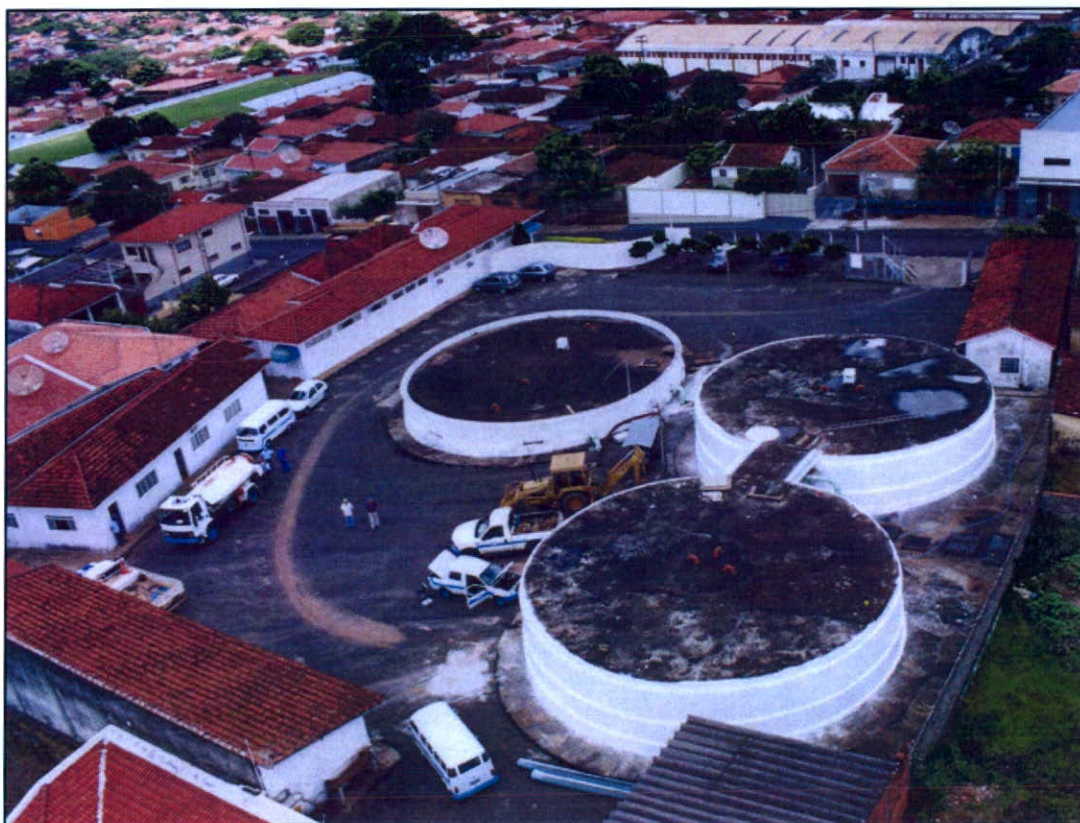
Foto 6 - Vista da área de reservação e atendimento comercial
