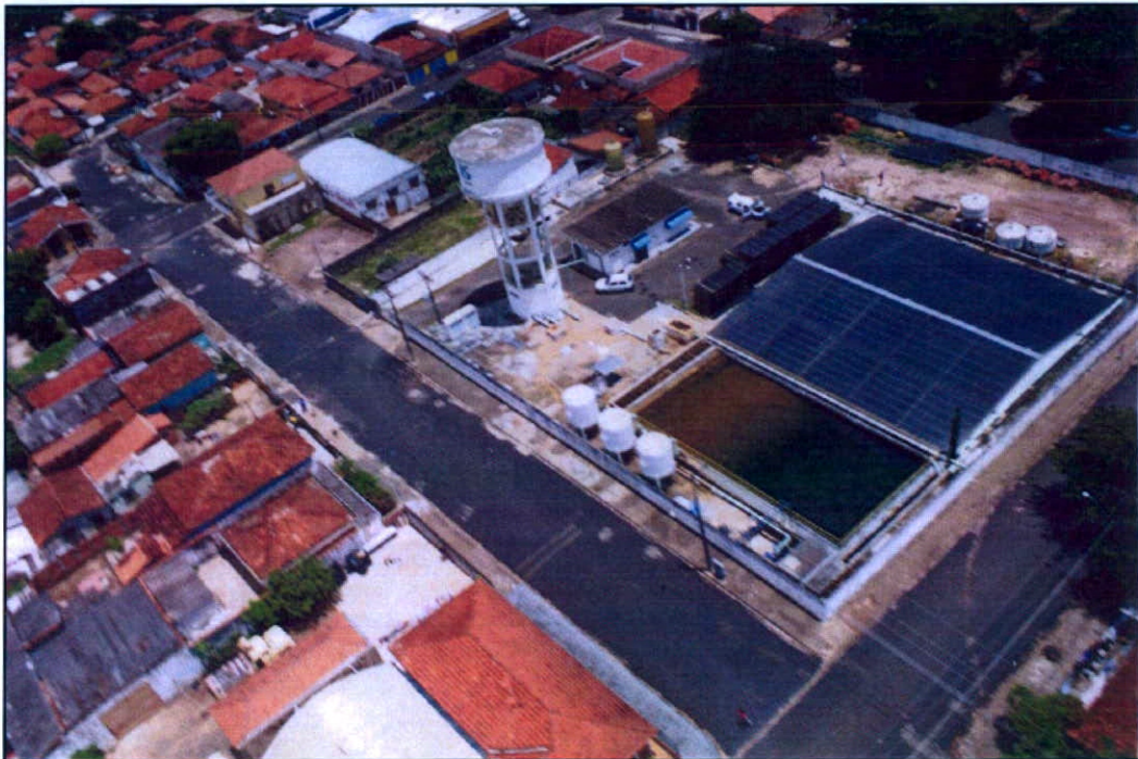
Foto 3 - Vista aérea da estação de tratamento de água
