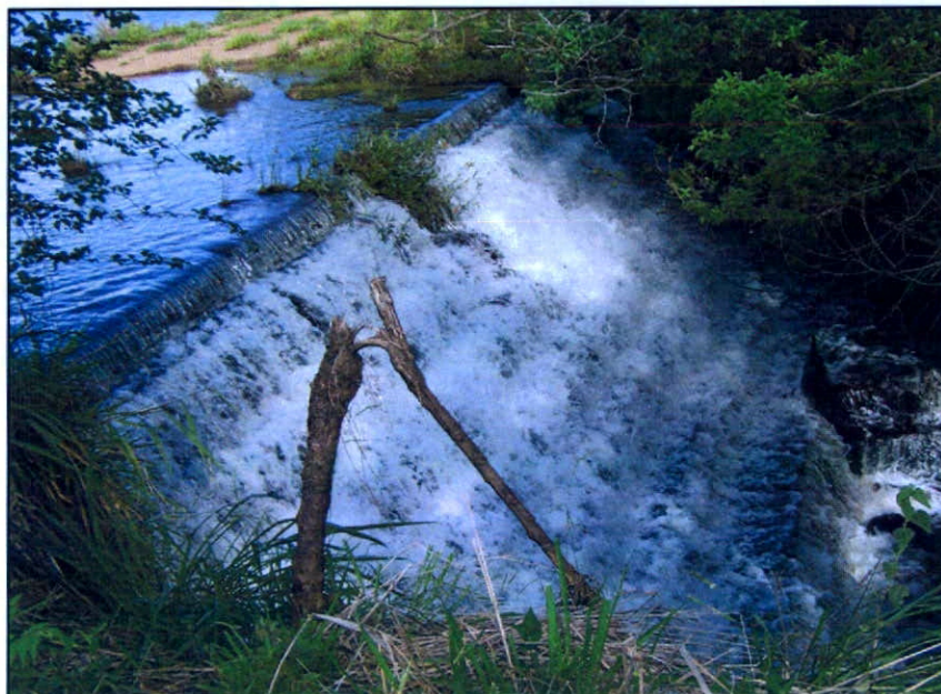
Foto 2 - Vista do Vertedouro
