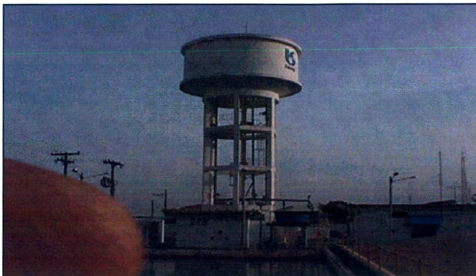
Foto 7 - Vista da área ETA - Reservatório elevado
