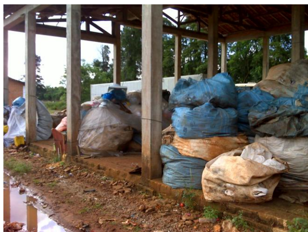
FOTO 4.25 – GALPÃO DE TRIAGEM DE MATERIAL RECICLÁVEL
