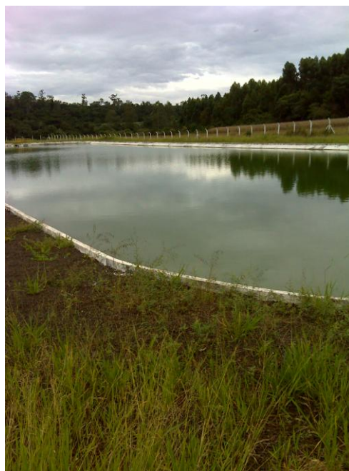
FOTO 4.21 – ETE SALTO DO PARANAPANEMA – LAGOA FACULTATIVA
