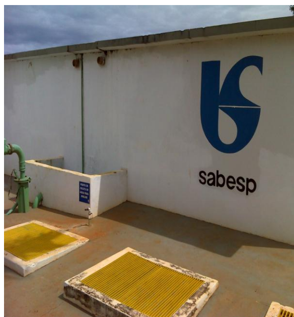
FOTO 4.6 - RESERVATÓRIO R1 (ALVENARIA) - SALTO DO PARANAPANEMA
