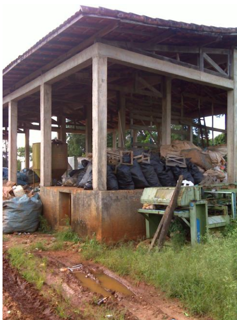
FOTO 4.24 - GALPÃO DE TRIAGEM DE MATERIAL RECICLÁVEL
