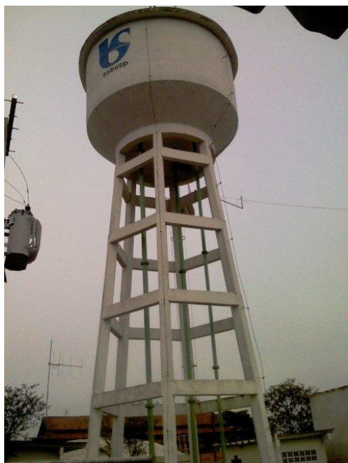
FOTO 4.3 - RESERVATÓRIO R1 - SEDE
