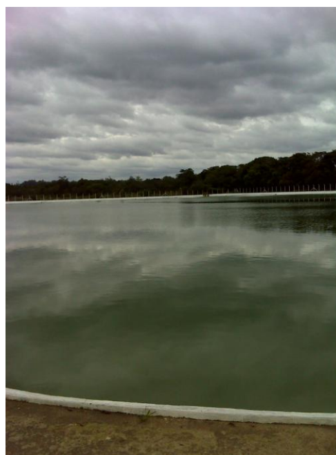
FOTO 4.15 – ETE – LAGOA FACULTATIVA
