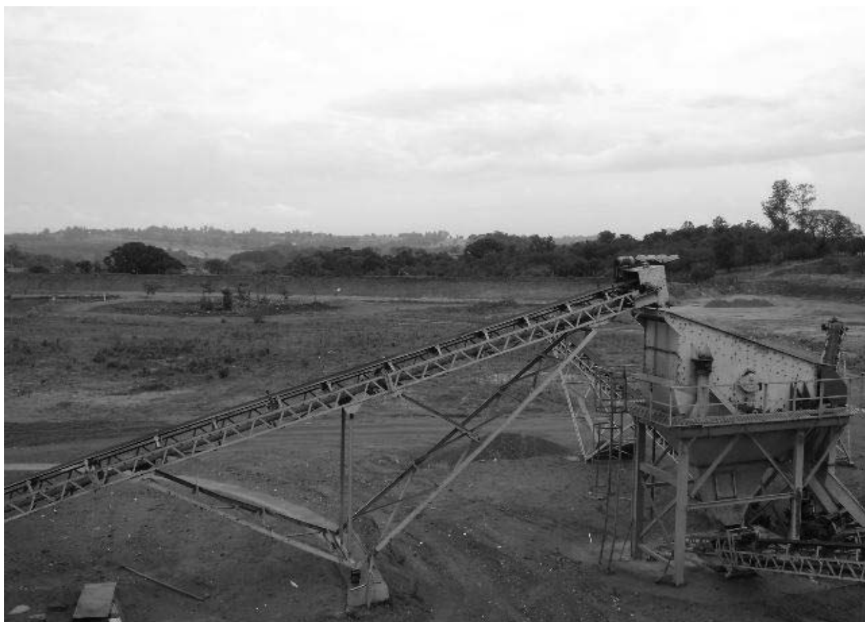
Vista da URM – Britador
