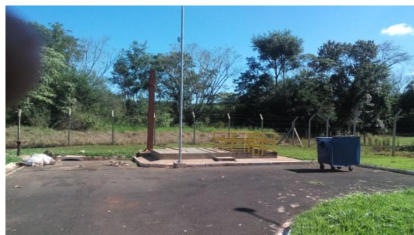
Foto 3.11 – Poço de sucção – EEE Final
