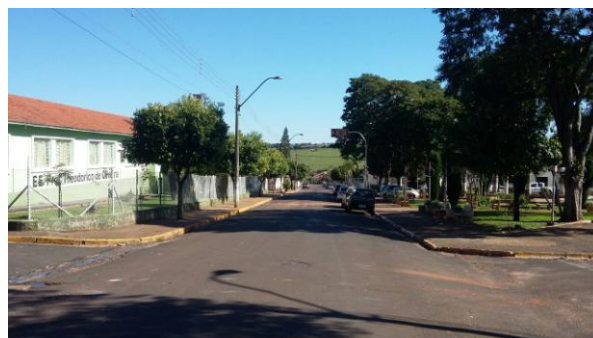
Foto 3.19 – Rua Artur Spinelli – Sentido Rio Novo
