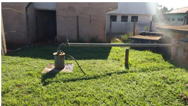
Foto 3.3 – Poço Profundo – PP 03
