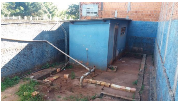
Foto 3.1 – Poço Profundo – PP 01
