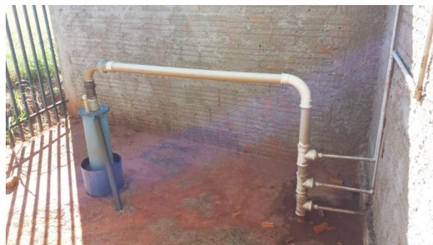
Foto 3.4 – Poço Profundo – PP 04
