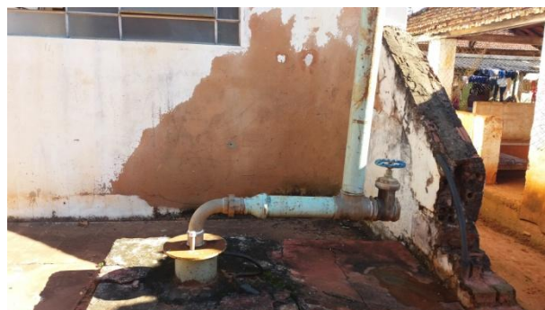
Foto 3.2 – Poço Profundo – PP 02
