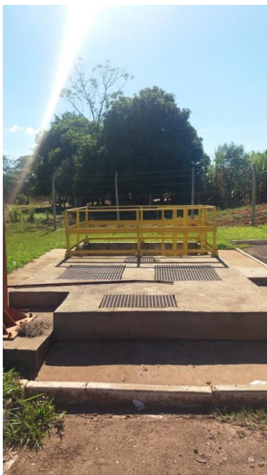
Foto 3.12 – Detalhe do Poço de Sucção
