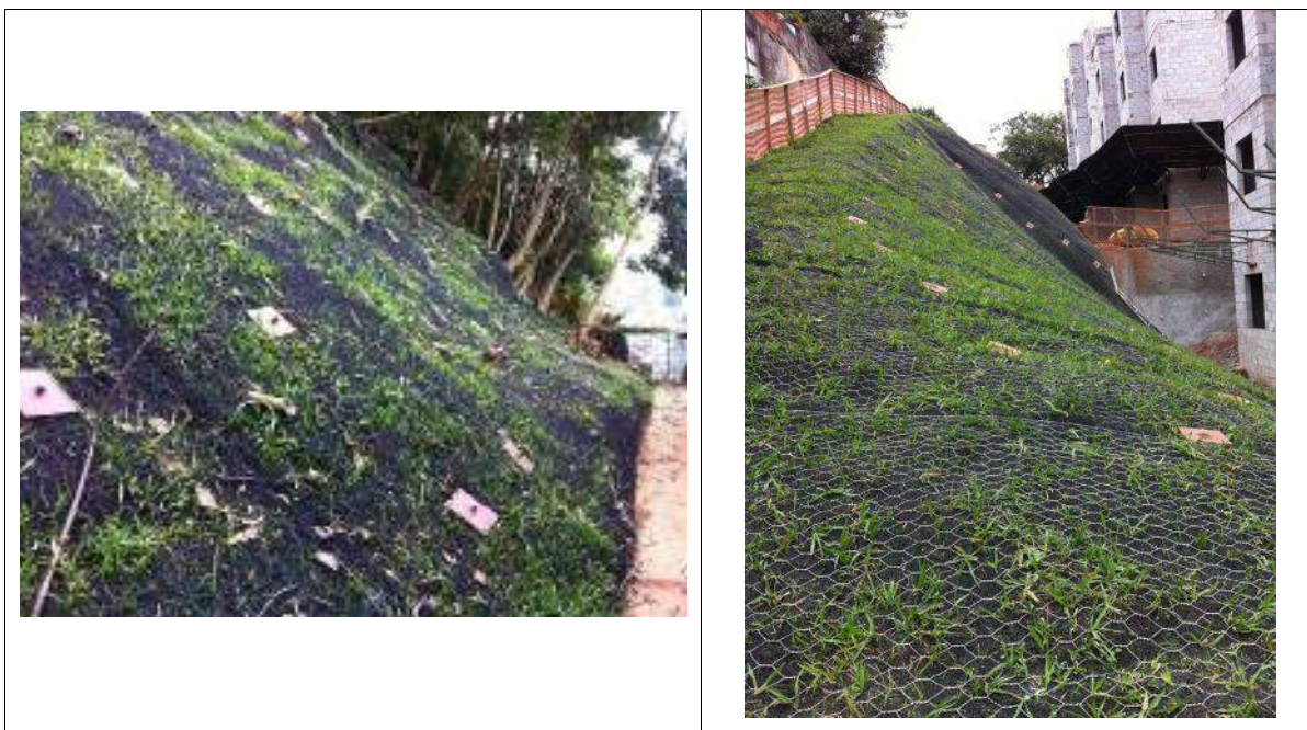
Figura 33 – Revestimento com grama do solo grampeado
