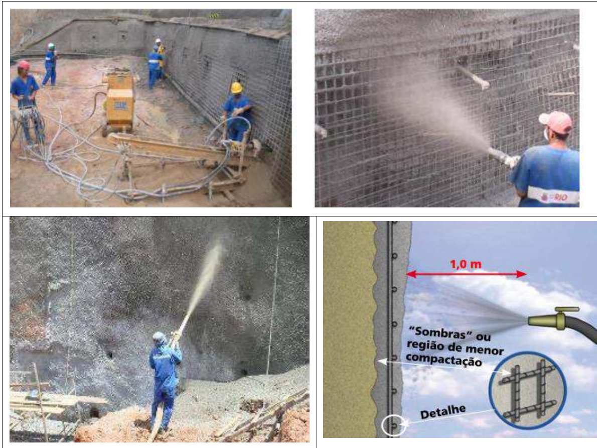
Figura 32 – Lançamento do concreto projetado
