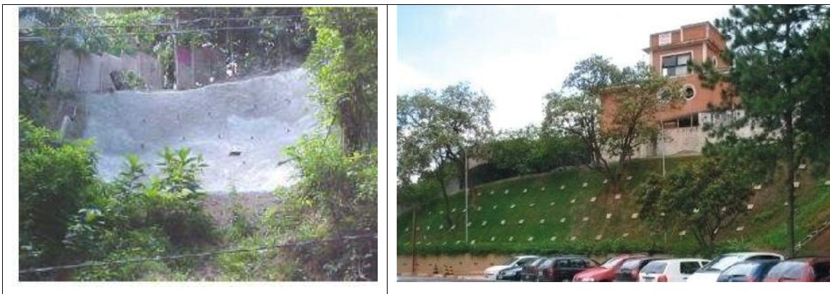
Figura 29 – Exemplo de aplicação de solo grampeado
