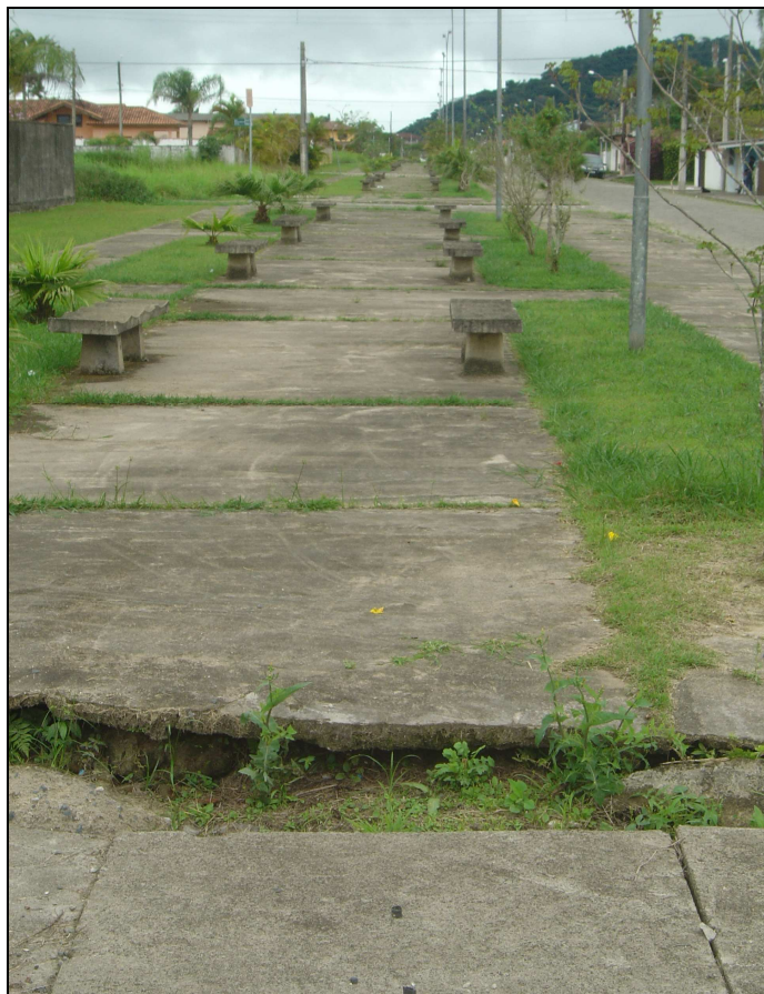
Foto 1 – Trecho Canalizado do Córrego do Barril, na Avenida Francisco de Assis Paiva
