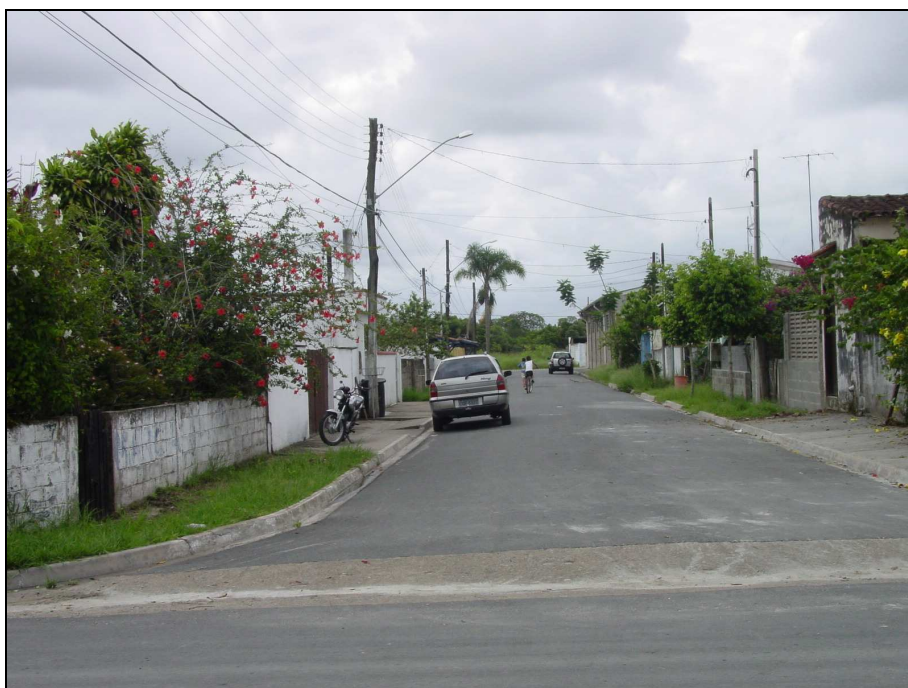
Foto 2 – Detalhe de Sarjetão na Rua José Maria Panei, visto da Rua Ranulfo Paiva
