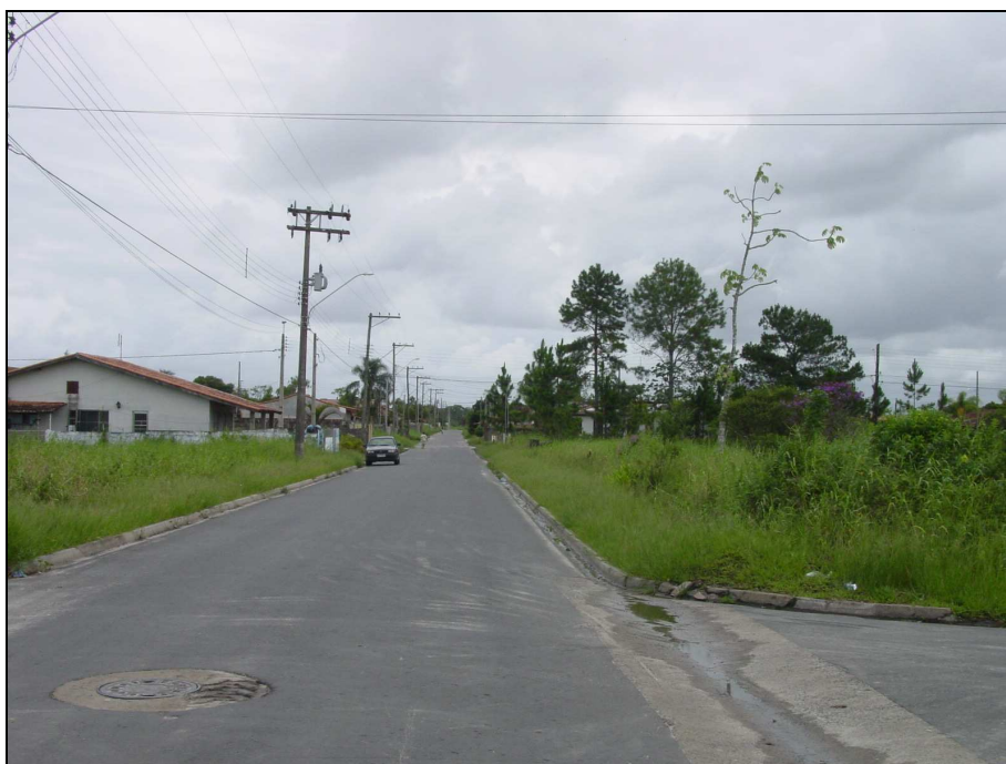
Foto 3 – Detalhe de Sarjetão e Sarjetas na Rua José Maria Panei, visto da Rua Ranulfo Paiva
