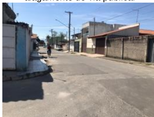
Figura 39. Vista do local afetado pelo alagamento de via pública.
