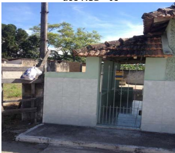
Figura 48. Formas de acondicionamento dos RSD - 03
