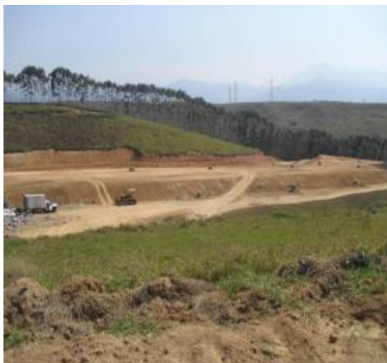
Figura 54. Vista do Maciço do Aterro Sanitário de Cachoeira Paulista
