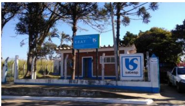
Figura 21. Poço P4 e Estação Elevatória de Água Tratada
