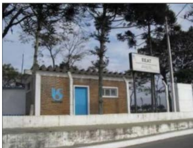
Figura 22. Estação de tratamento de água, de reservação e estação elevatória (EEAT)
