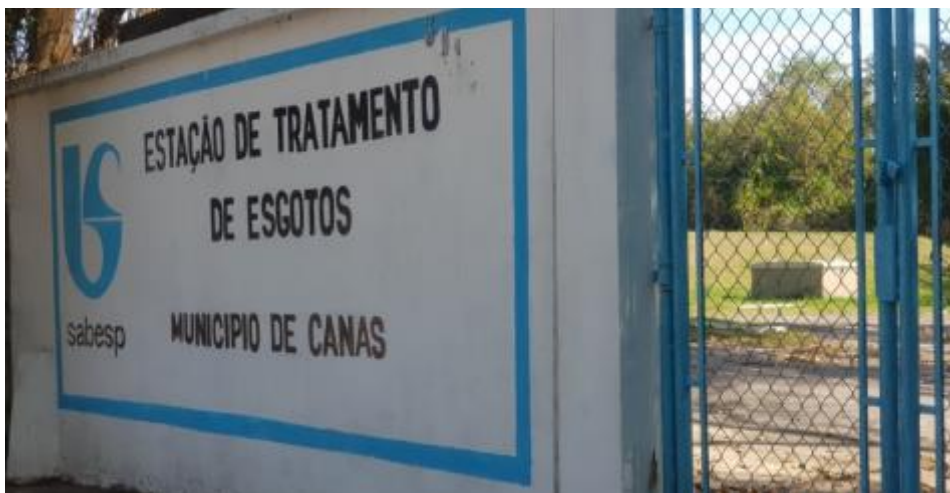
Figura 25. Entrada da Estação de Tratamento de Esgotos
