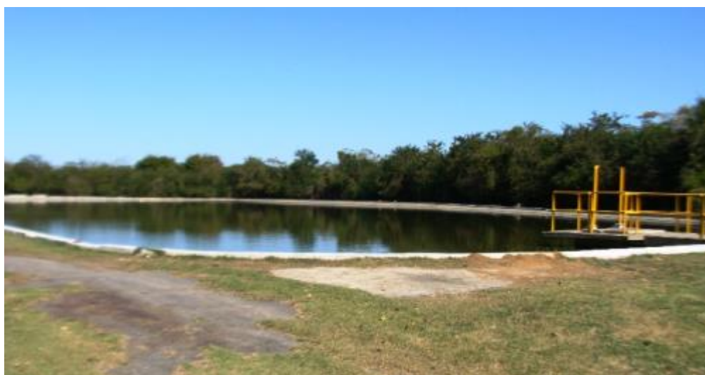
Figura 26. Vista da Lagoa de estabilização
