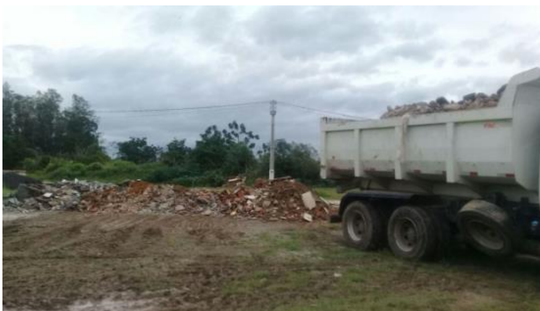
Figura 73. Caminhão basculante depositando os RCC atrás da Prefeitura Municipal
