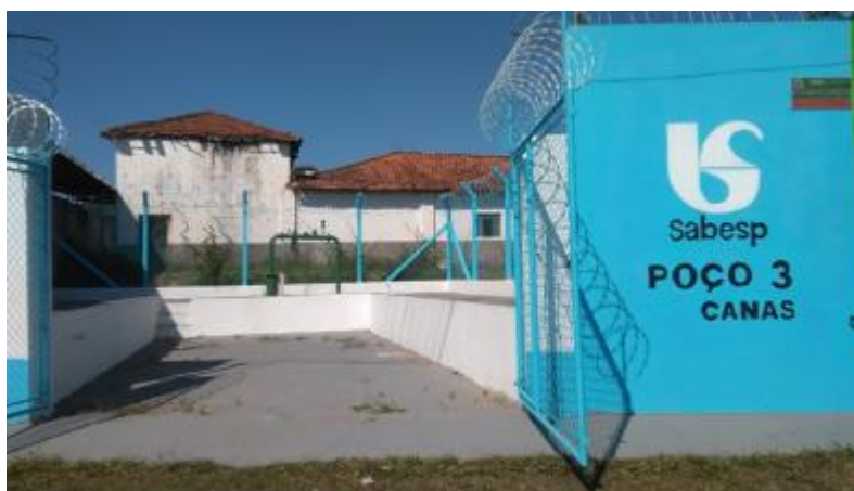
Figura 20. Captação de Água - Poço P.3
