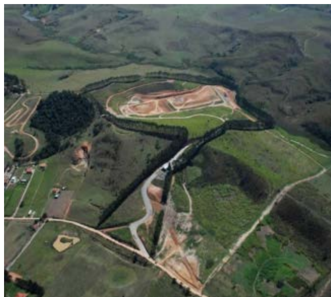
Figura 53. Vista Aérea do Aterro Sanitário de Cachoeira Paulista
