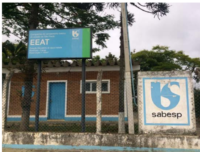
Figura 23. Sistema de reservação de água tratada e Estação Elevatória de Água Tratada
