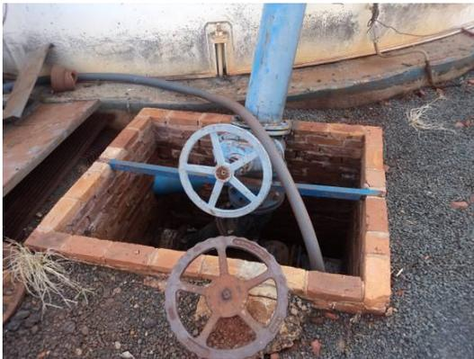
Figura 37. Vista da chegada da tubulação da Elevatória no sistema de reservação Central
