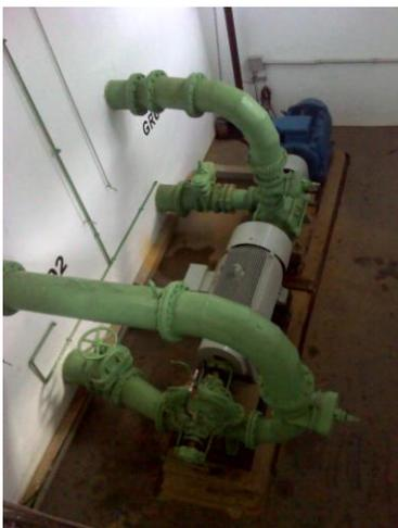
FOTO 4.2 – EEAB - ESTAÇÃO ELEVATÓRIA DE ÁGUA BRUTA
