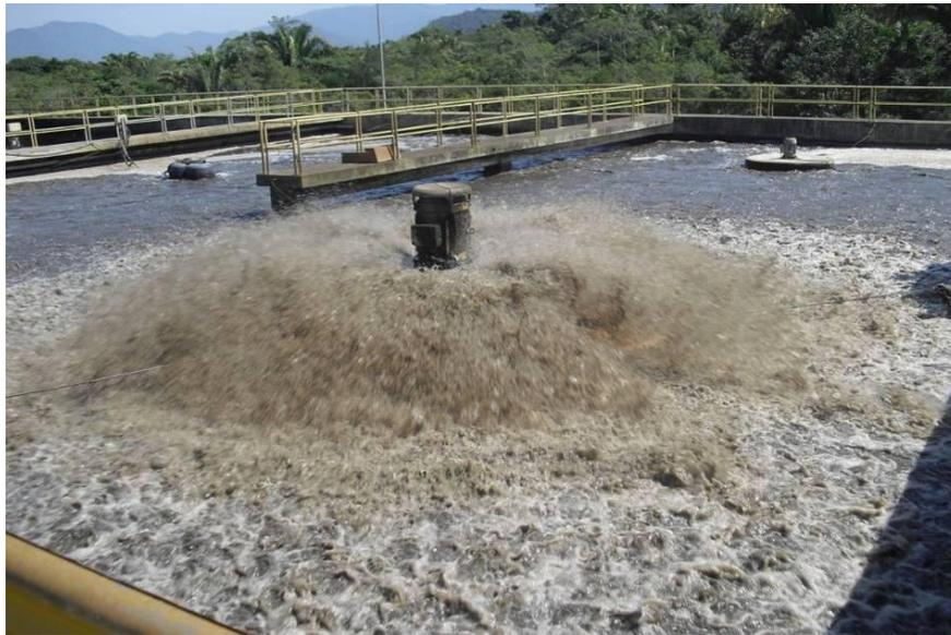
**Foto 25 – Tanques de Aeração/Sedimentação da ETE Indaiá**
