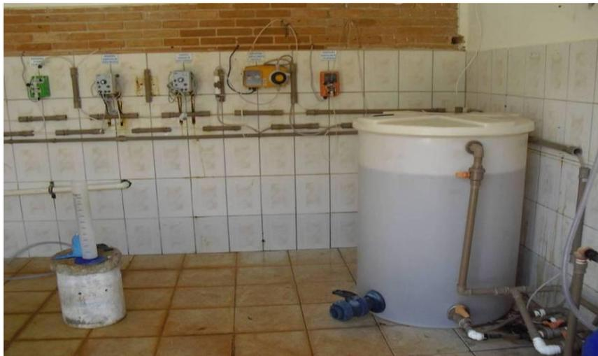
**Foto 16 – Sistema de Aplicação de Cloro e Flúor**
