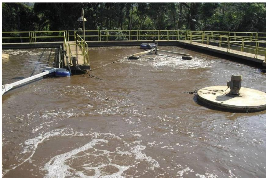
Foto 29 – Tanques de Aeração/Sedimentação da ETE Massaguaçu
