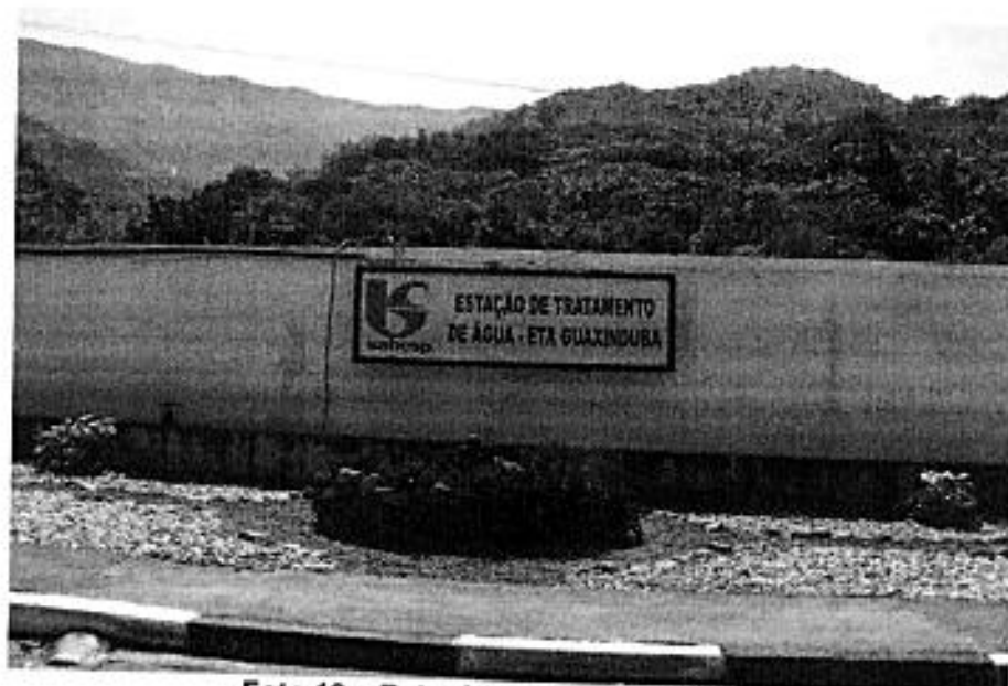
Foto 10 – Entrada da ETA Guaxinduba
