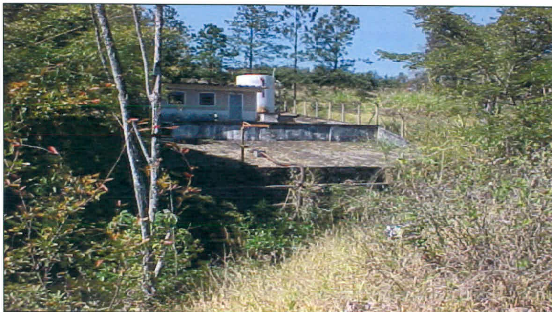
Foto 1 - Captação de Água Bruta - Vista da Margem Direita
