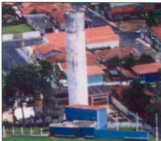
Foto 5 - Reservatório T01 e vista da ETA
