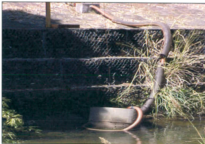
Foto 2- Estação elevatória de água bruta - EEAB01 - Detalhe da tomada de água
