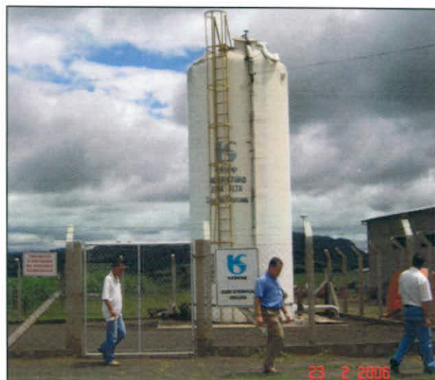
Foto 6 - Reservatório apoiado 75 m³ - RA01
