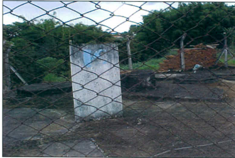
Foto 11- Estação elevatória de esgotos desativada
