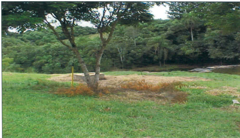
Foto 10- Emissário 01 - Vista do poço de visita
