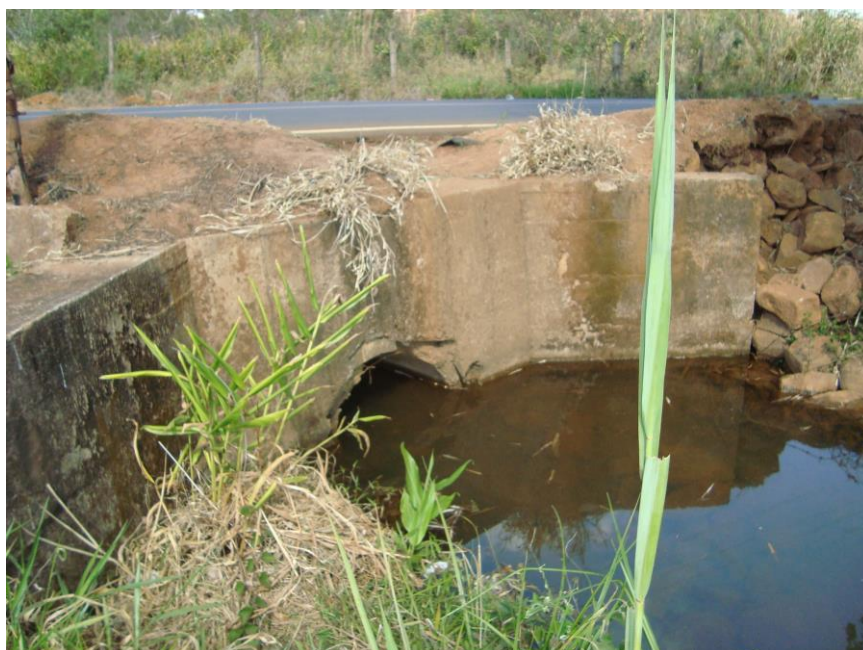
Figura 5.2 – Bueiro de talvegue na Rua Clara Maria de Jesus (Córrego Taquaral) – Jusante.
