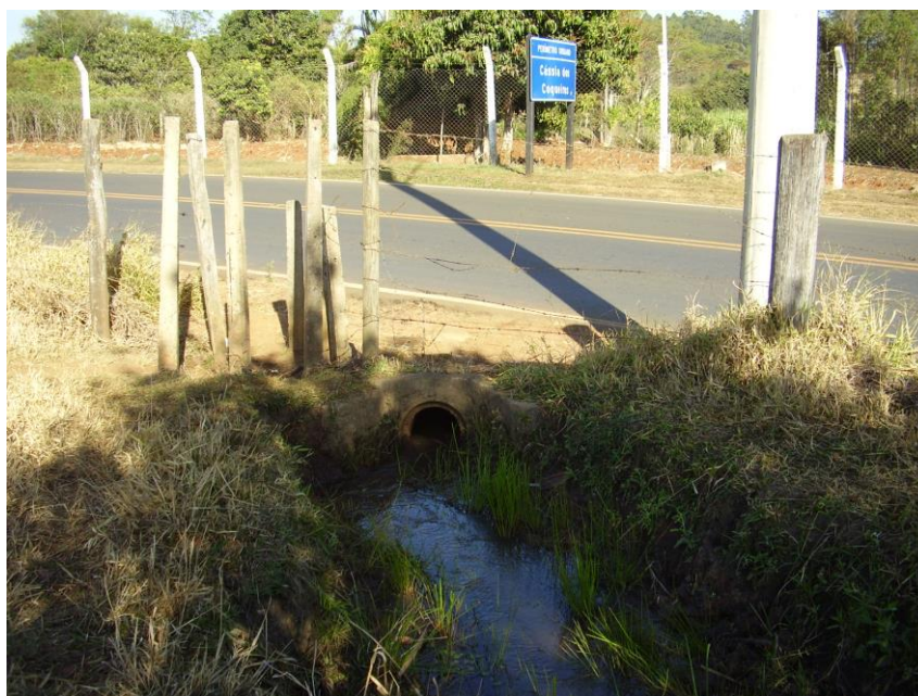
Figura 12.9 – Tubo de escoamento do curso das águas transpostas, do Córrego Santa Rita, sob a estrada a Santo Antonio da Alegria.
