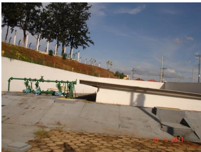
Figura 2.8 – Vista do Reservatório Semi-Enterrado RS01 de 150 m 3 .
