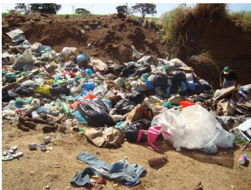
Figura 4.5 – Aterro em Valas – Resíduos Aguardando Recobrimento.
