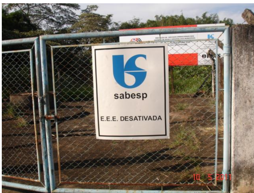
Figura 3.3 – Vista da EEE Desativada.
