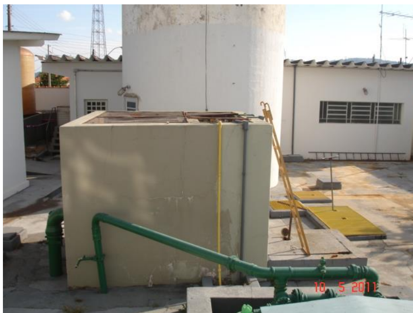
Figura 2.5 – Vista da ETA.
