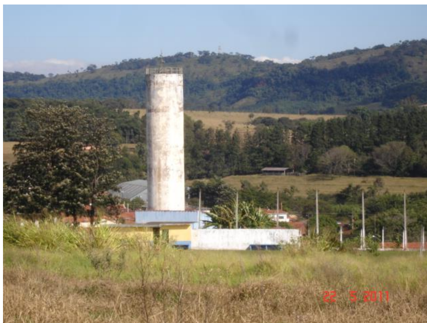
Figura 2.6 – Vista do Reservatório Elevado T01 de 100 m 3 .
