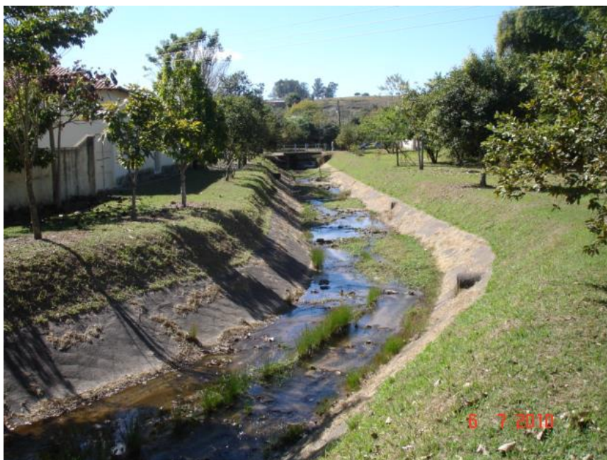
Figura 16.8 – Córrego Tamanduá. Trecho canalizado.
