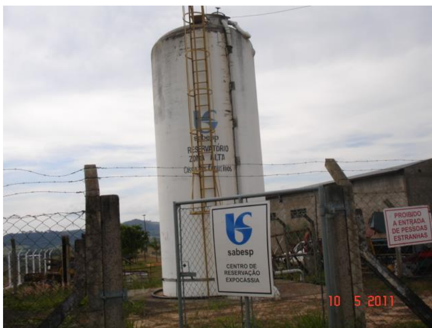
Figura 2.7 – Vista do Reservatório Apoiado RA01 de 75 m 3 .
