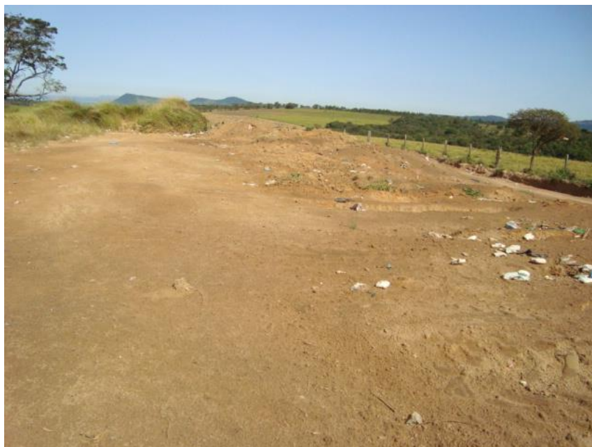
Figura 4.6 – Aterro em Valas – Resíduos Recobertos.
