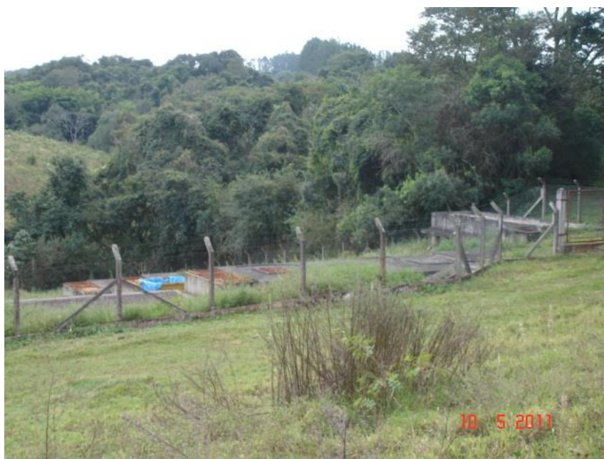
Figura 3.4 – Vista Geral da ETE.
