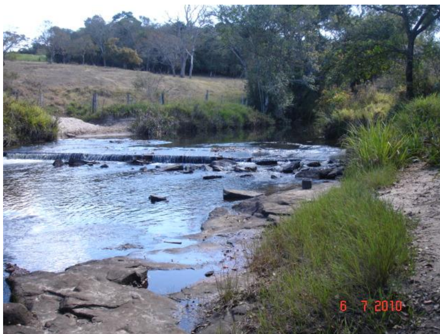
Figura 16.11 – Cubatão: Ausência de mata ciliar margem superior. Leito sobre diabásio.
