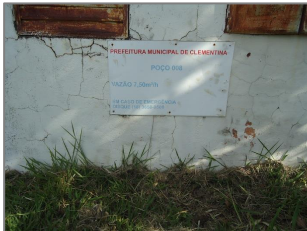
Foto 3.8 – Identificação do Poço P-08
