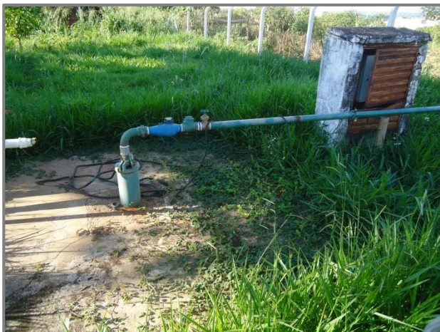
Foto 3.7 – Identificação do Poço P-07
