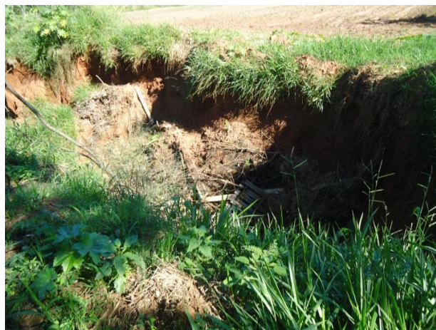
Foto 3.51 – Ponto de erosão na Rua Henriqueta Zandonate
