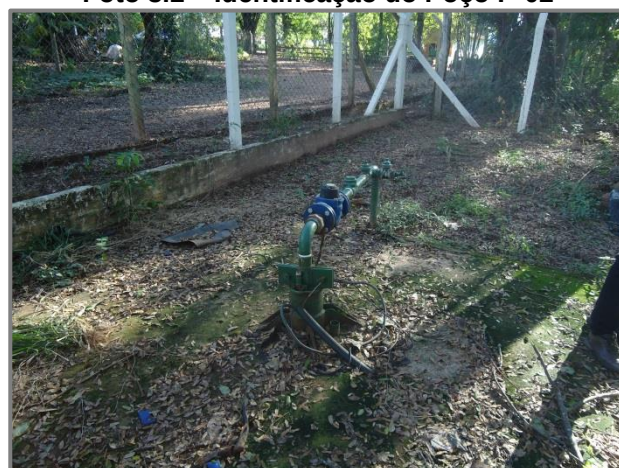
Foto 3.4 – Identificação do Poço P-04
