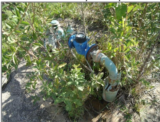
Foto 3.9 – Identificação do Poço P-09
