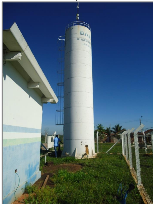
Foto 3.31 – Identificação do Reservatório 06
