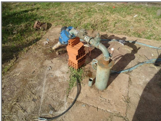
Foto 3.13 – Identificação do Poço P-13
