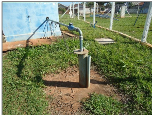
Foto 3.14 – Identificação do Poço P-14
