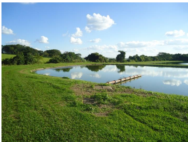
Foto 3.37 – Vista da Lagoa Anaeróbia ETE Matadouro
