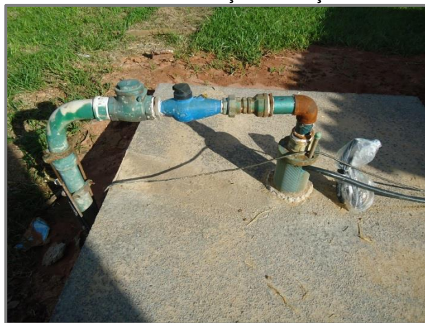
Foto 3.10 – Identificação do Poço P-10
