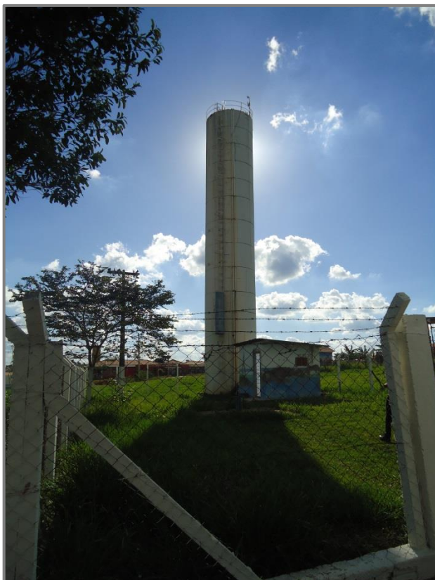
Foto 3.26 – Identificação do Reservatório 01
