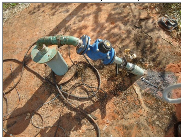
Foto 3.16 – Identificação do Poço P-16
