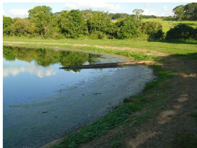
Foto 3.38 – Vista da Lagoa Facultativa ETE Matadouro
