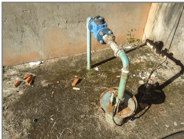
Foto 3.1 – Identificação do Poço P-01
