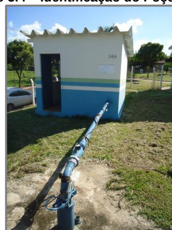
Foto 3.6 – Identificação do Poço P-06
