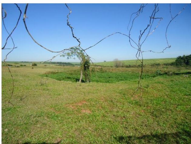
Foto 3.43 – Vista da ETE Lauro penteado
