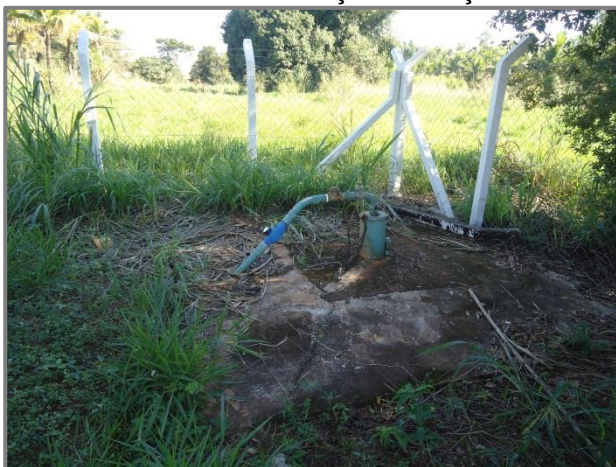
Foto 3.15 – Identificação do Poço P-15
