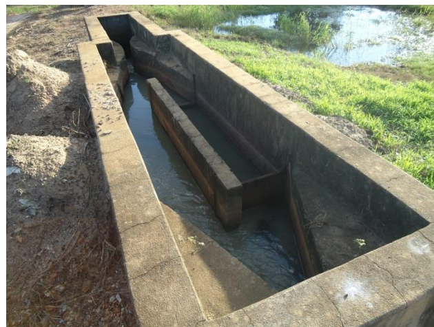
Foto 3.34 – Vista do desarenador ETE Clealco
