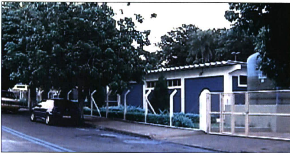
Foto 4 - Vista da fachada do escritório
