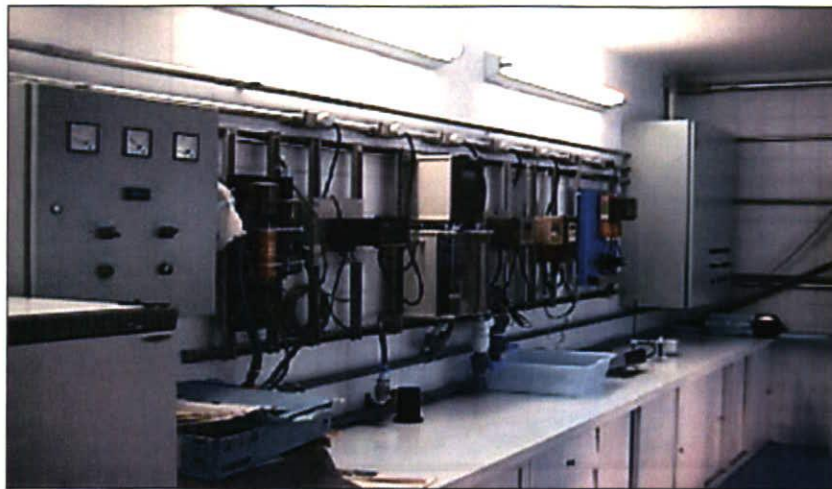
Foto 11 - Sistema automático de dosagem de produtos químicos
