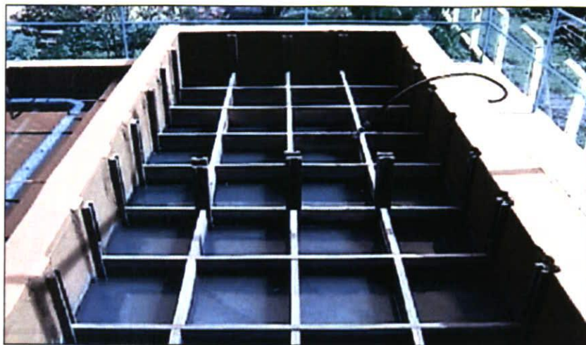
Foto 7 - Vista dos decantadores da estação de tratamento de água
