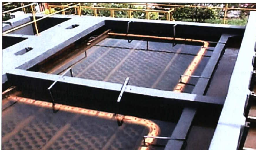
Foto 7 - Vista dos decantadores da estação de tratamento de água
