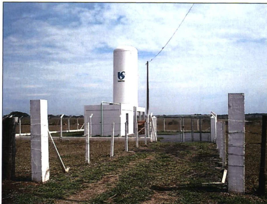
Foto 15 - Reservatório Elevado T01 - Colômbia
