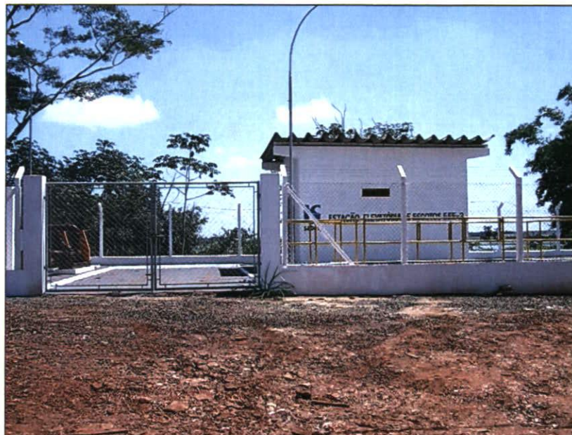
Foto 21 - Estação elevatória EEE02
