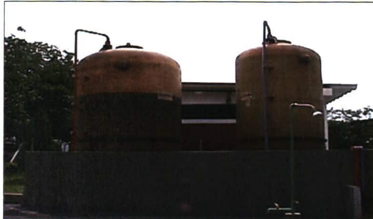
Foto 9 - Tanques de estocagem de produtos químicos
