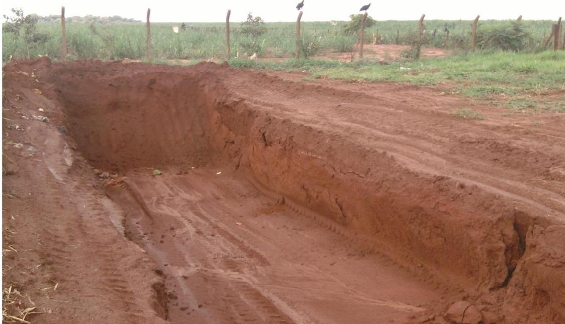
Figura 10: Controle das valas no interior do Aterro Sanitário.
