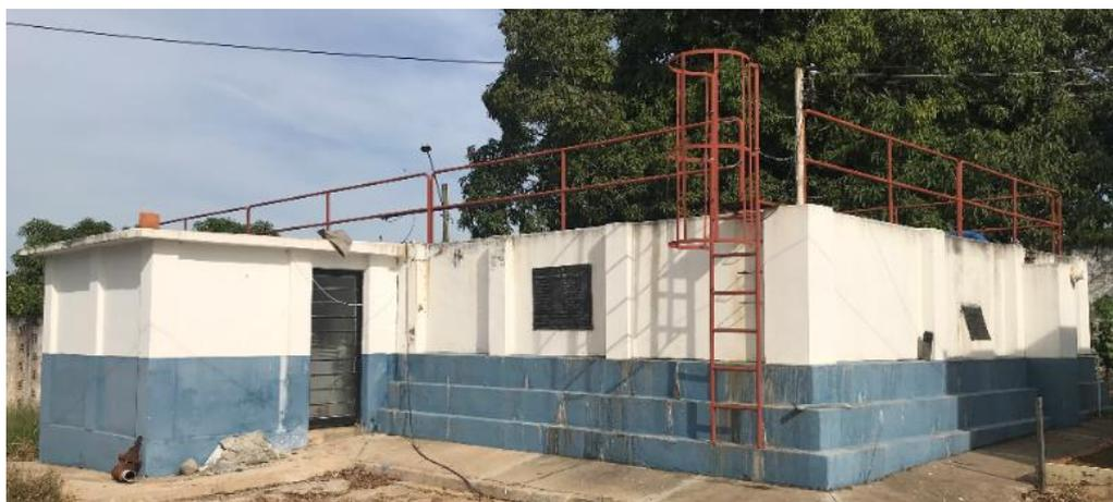
Foto 18: Reservatório Semienterrado - 350 m<sup>3</sup>
