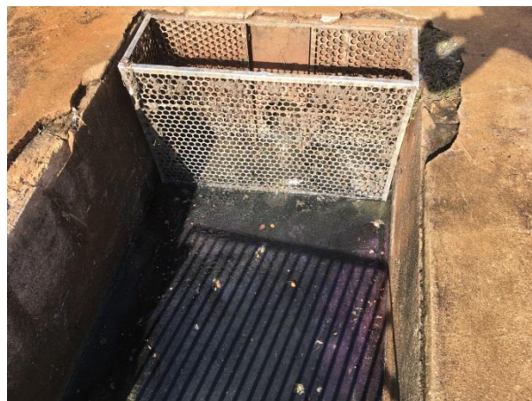
Foto 3.42 – Detalhe do cesto na chegada do emissário ETE Vila Nova
