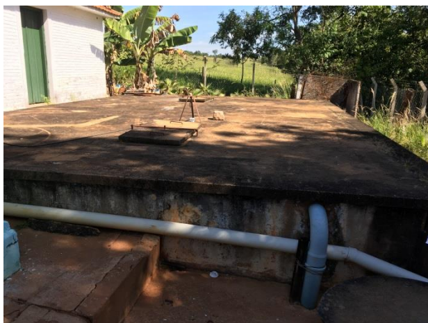
Foto 3.16 - Identificação do Reservatório: RSE 01
