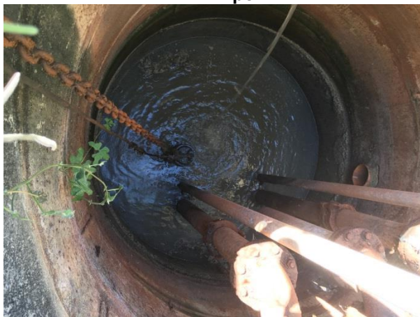
Foto 3.25 – Vista do poço de sucção EEEB Ipê
