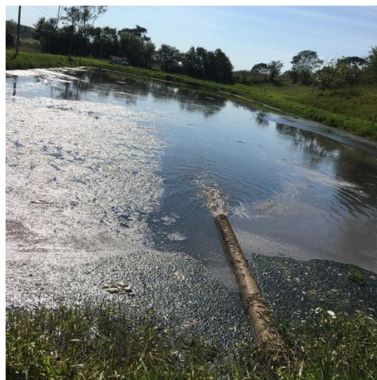
Foto 3.37 – Vista geral da lagoa anaeróbia 01 ETE Cosmorama
