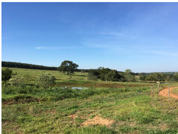
Foto 3.67 – Bacia de retenção
