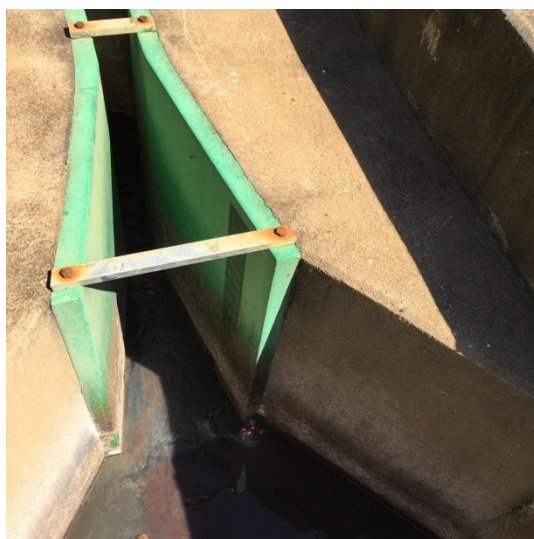
Foto 3.24 – Vista da Calha Parshall EEEB Ipê
