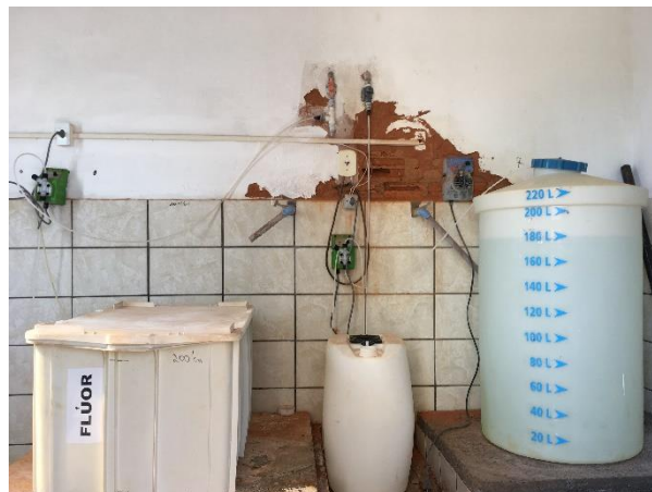
Foto 6.3 – Vista interna da estrutura física de armazenamento de produtos químicos e painel elétrico das bombas
