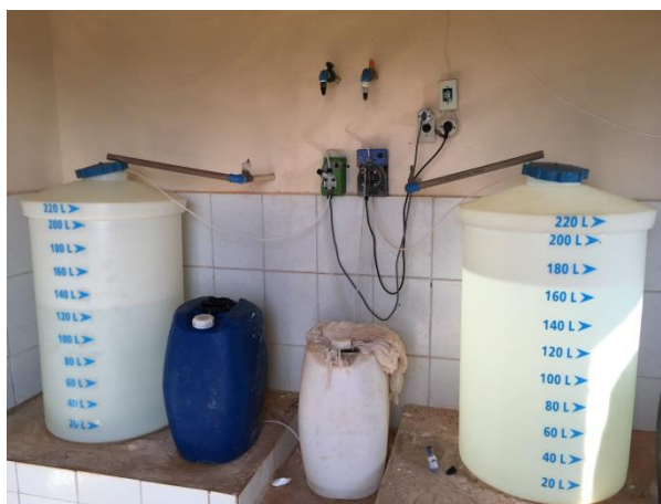
Foto 3.13 - Unidades de Fluoretação e Cloração
