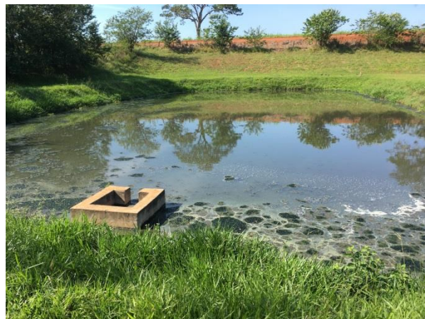
Foto 3.39 – Vista geral da lagoa anaeróbia 03 ETE Cosmorama
