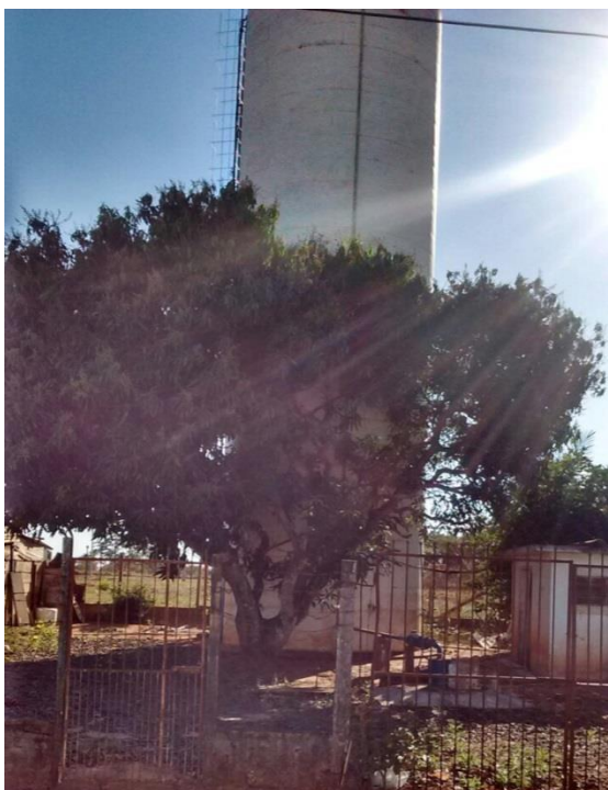
Foto 3.18 - Identificação do Reservatório: REL 03
