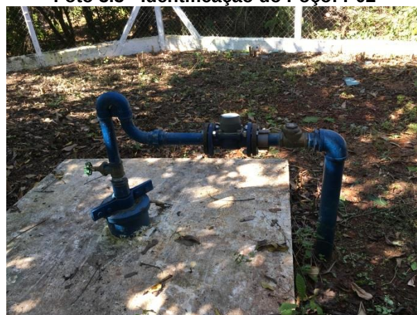
Foto 3.5 - Identificação do Poço: P04
