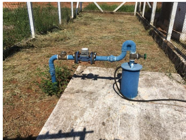
Foto 3.9 - Identificação do Poço: P08
