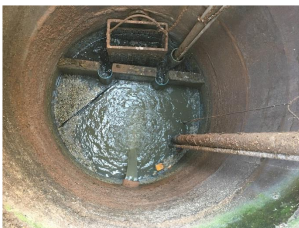
Foto 3.29 – Vista do poço de sucção t EEEB Área de Lazer
