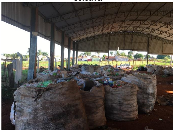
Foto 3.55 – Resíduos segregados armazenados em bags
