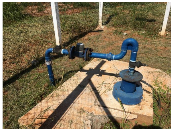
Foto 3.3 - Identificação do Poço: P02
