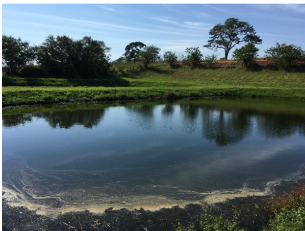
Foto 3.38 – Vista geral da lagoa anaeróbia 02 ETE Cosmorama
