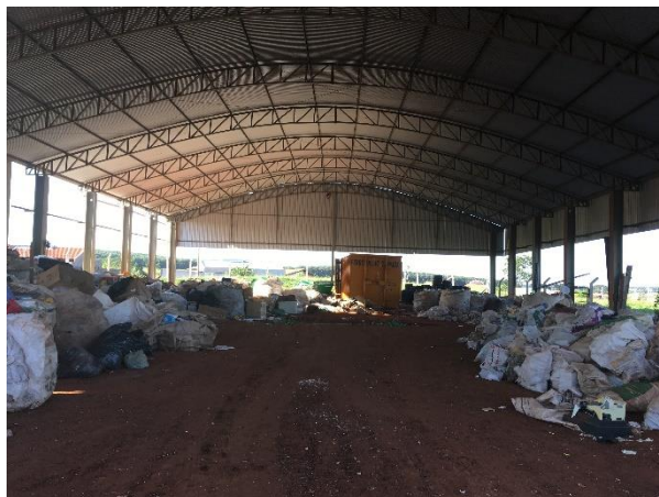
Foto 3.52 – Vista interna barracão de triagem
