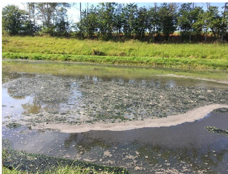
Foto 6.6 – Vista da presença de sobrenadante e placas de lodo desprendido do fundo na superfície líquida da lagoa anaeróbia
