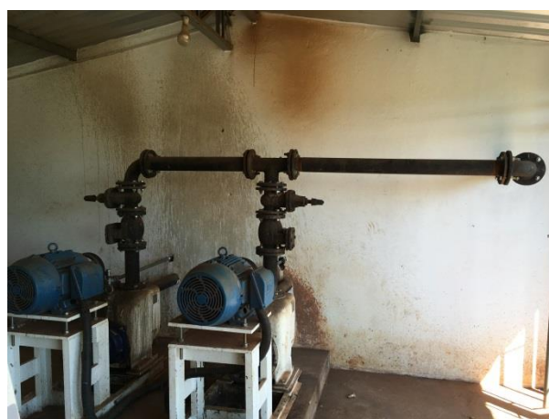
Foto 3.30 – Vista dos conjuntos motor-bombas EEEB Área de Lazer
