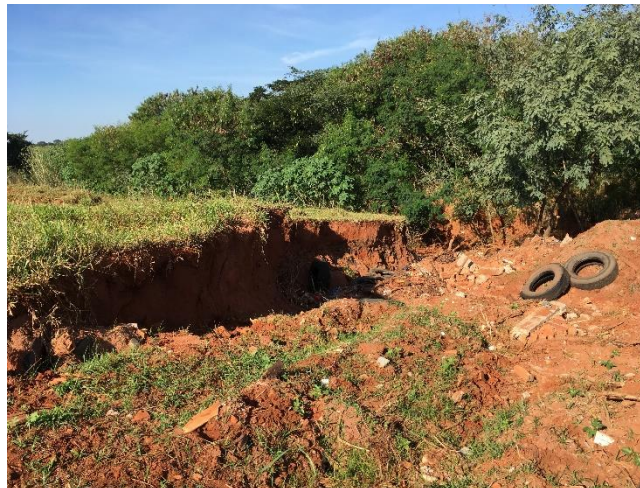
Foto 3.73 – Erosão na área do antigo lixão
