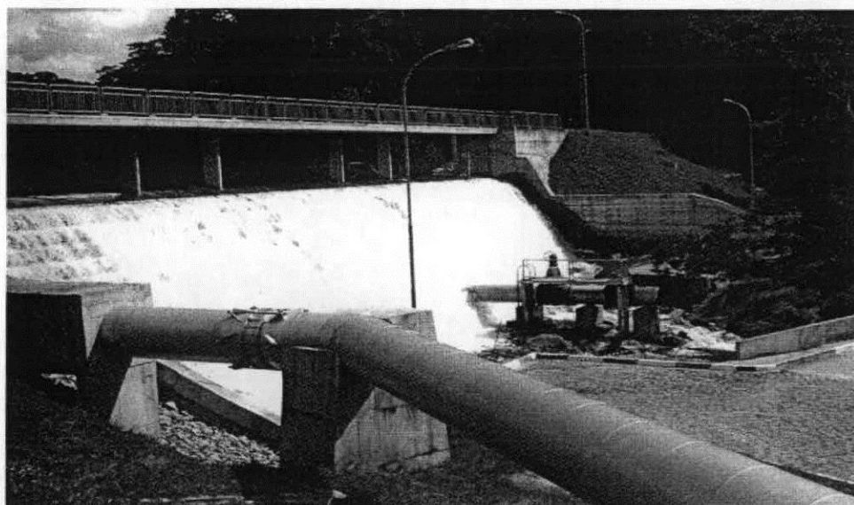
CAPTAÇÃO: SISTEMA ALTO COTIA CAPACIDADE: 1.200 L/s
