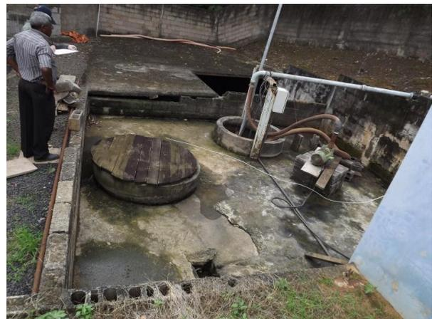
**Foto 3.52 – Poços de Sucção (PS1 e PS2) e Reservatório ‘Pulmão’ (fundo).**
