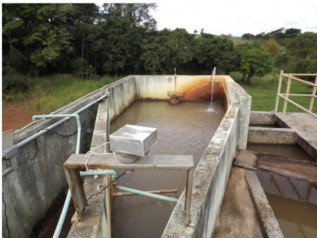
**Foto 3.19 – Canal de Entrada: Pré-cloração e Medidor Ultrassônico.**
