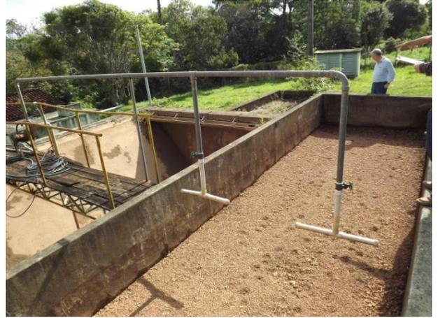
**Foto 3.34 – Tratamento do Lodo – Detalhe do lançamento de Lodo no Leito.**
