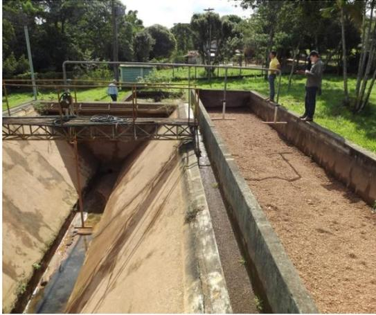
**Foto 3.33 – Tratamento do Lodo – Recalque do Lodo para o Leito.**
