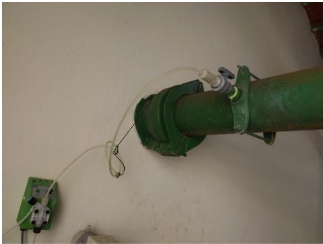
**Foto 3.35 – Aplicação de Flúor no recalque da EEAT-1.**
