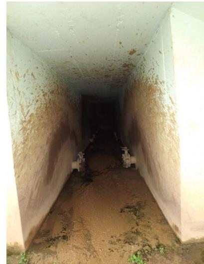
**Foto 3.36 – Operação da ETA – Válvulas de limpeza dos drenos.**
