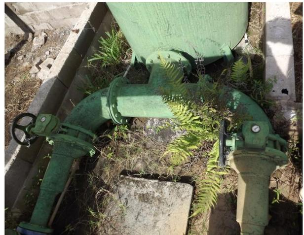
Foto 3.14 – EEAB – Tubulação de Sucção no Tanque de Escorva.
